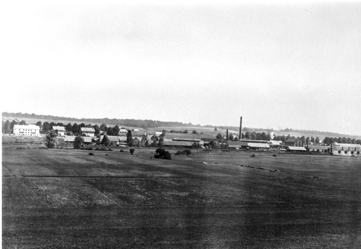
Les Forges de Grandvillars depuis l'ouest.
