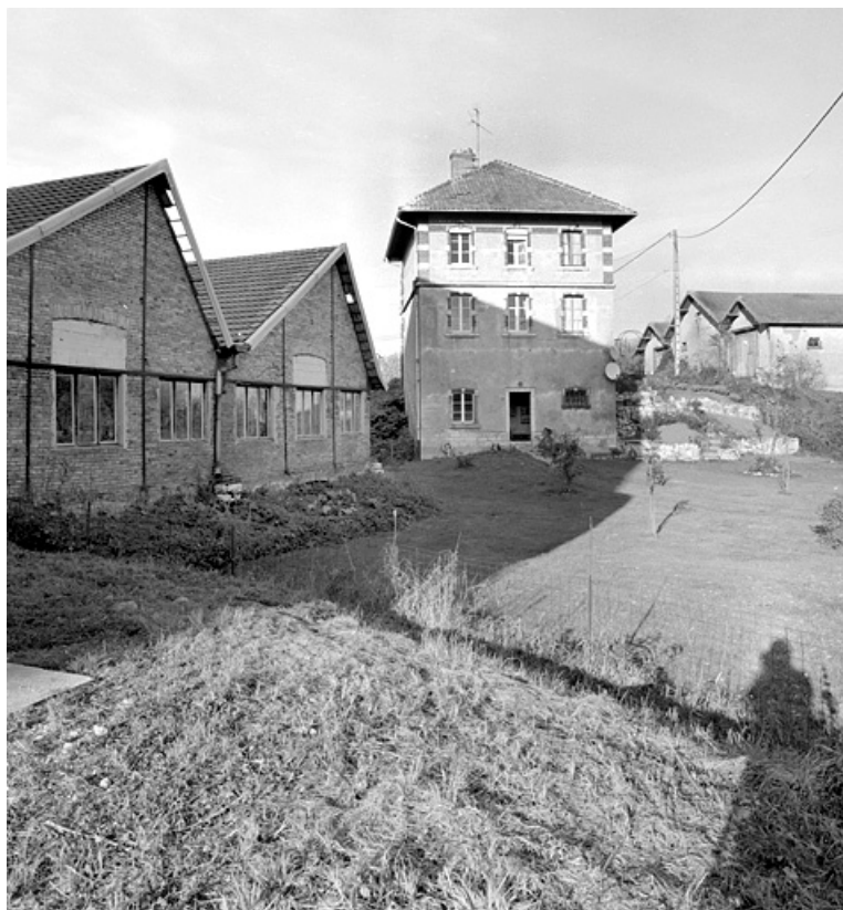
Extrémité sud des ateliers de fabrication et logement.
