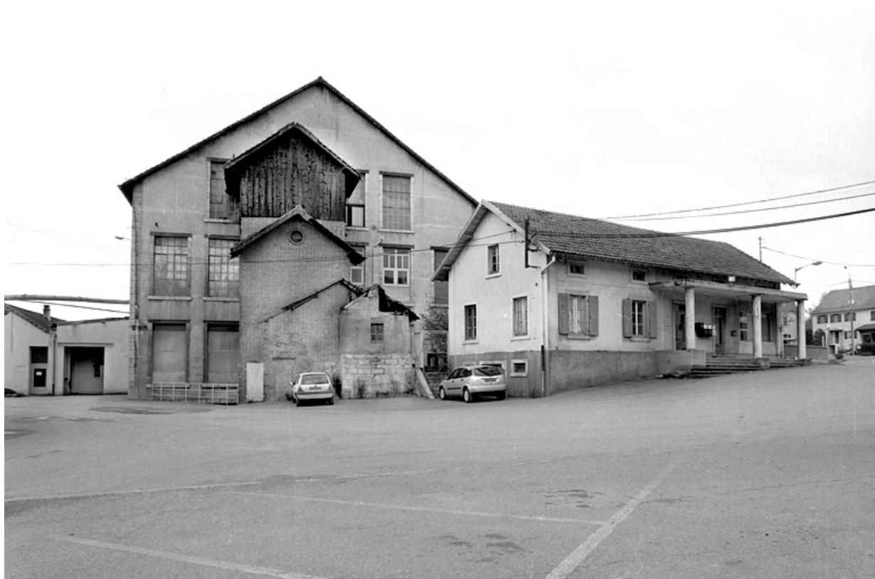
Pignon d'un atelier de fabrication, bâtiment d'eau et bureau.
