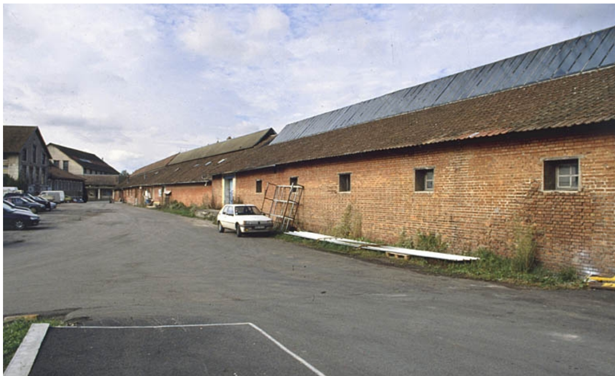
Magasin et entrepôt industriel couvrant le canal depuis le sud-est.
