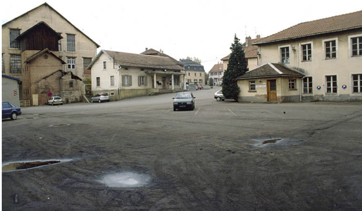
Entrée de l'usine depuis le sud de la cour.
