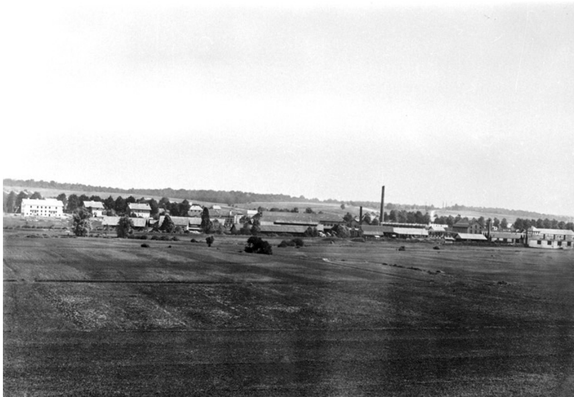
Les Forges de Grandvillars depuis l'ouest.
