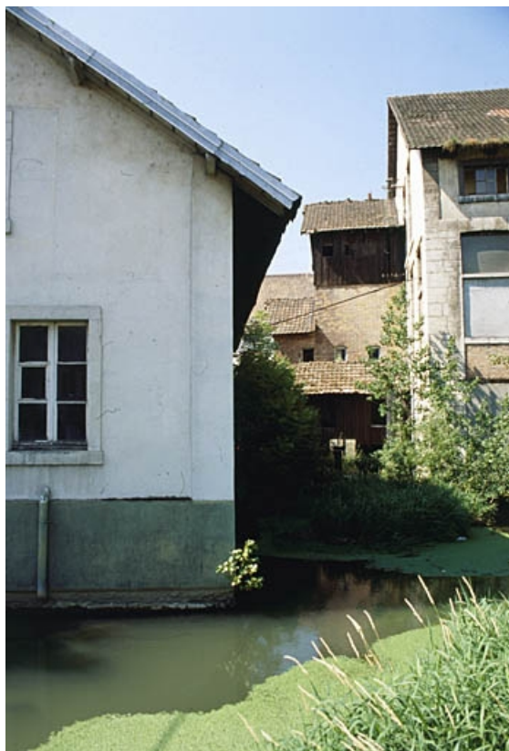
Retenue de prise d'eau sur le canal et bâtiment d'eau.
