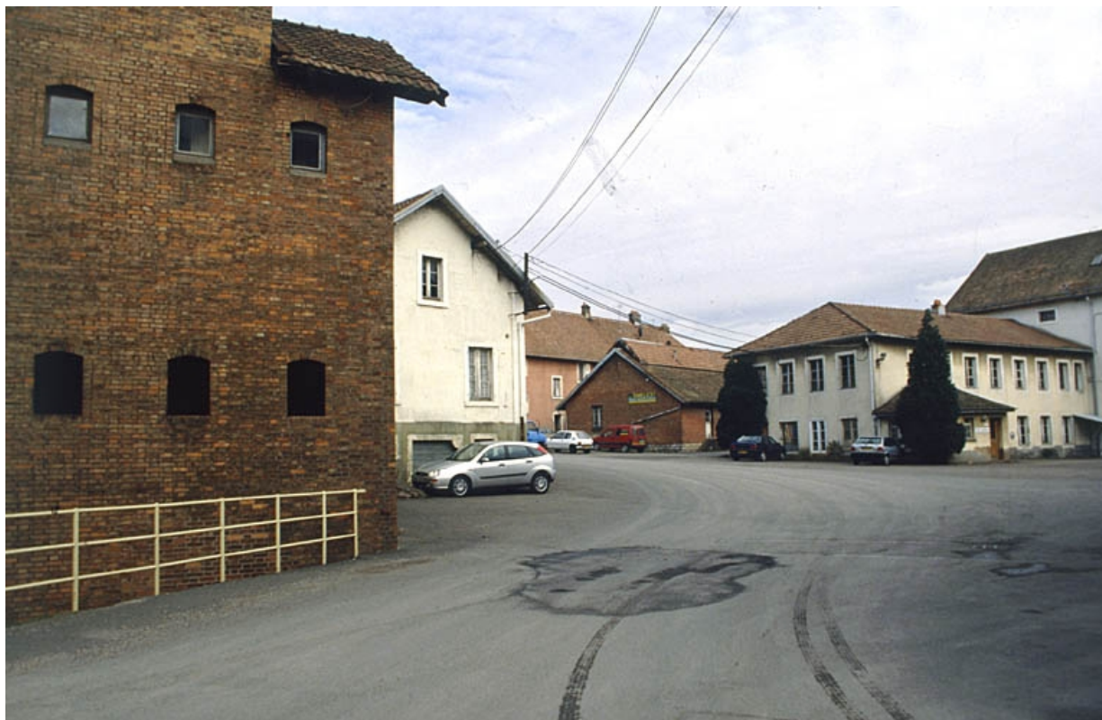
Vue depuis l'ouest de la cour. 90, Grandvillars, lieudit : les Forges
