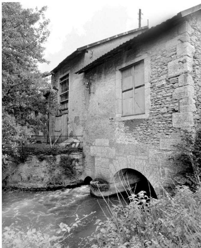
Canal de fuite et bâtiment d'eau.
