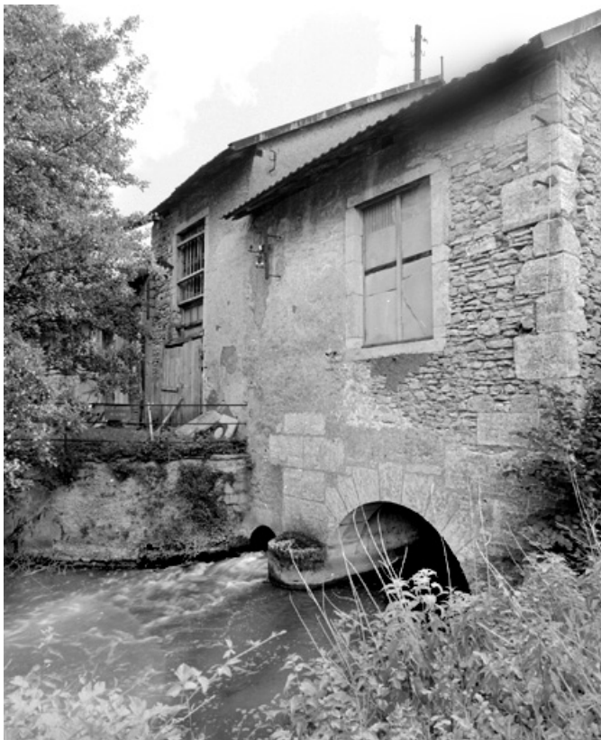
Canal de fuite et bâtiment d'eau.
