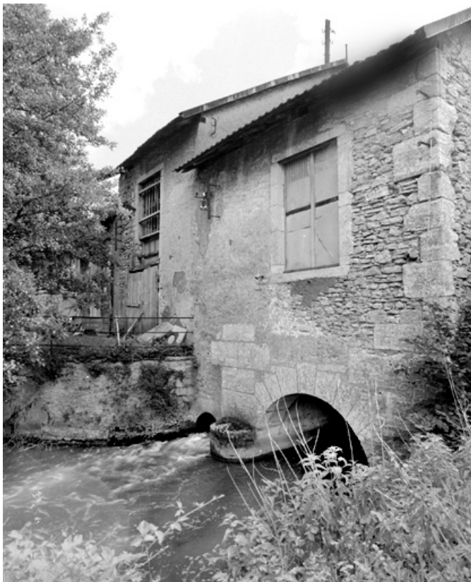
Canal de fuite et bâtiment d'eau.
