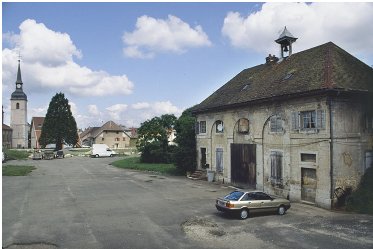
Cour et communs nord depuis le perron du château.
