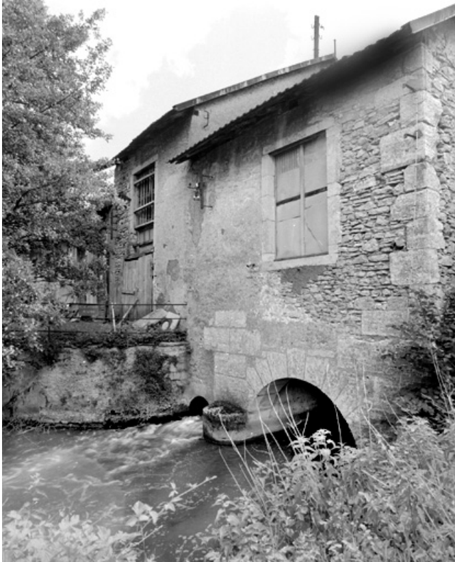
Canal de fuite et bâtiment d'eau.
