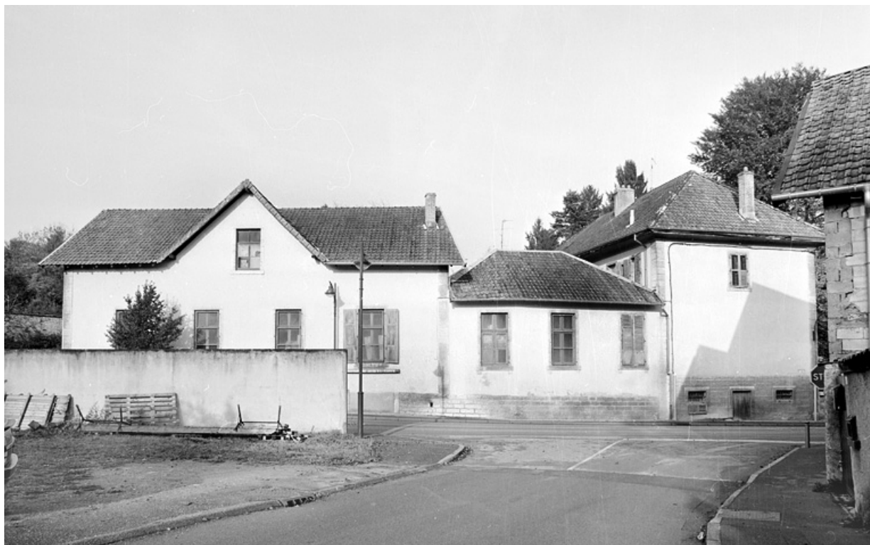
Salle de spectacle, chaufferie et école depuis l'est.
