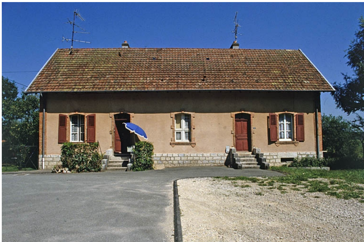
Façade antérieure d'un logement à 2 appartements.
