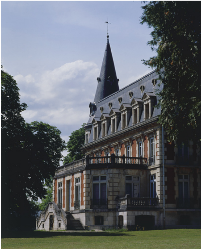
Façade sud vue de trois quarts.
