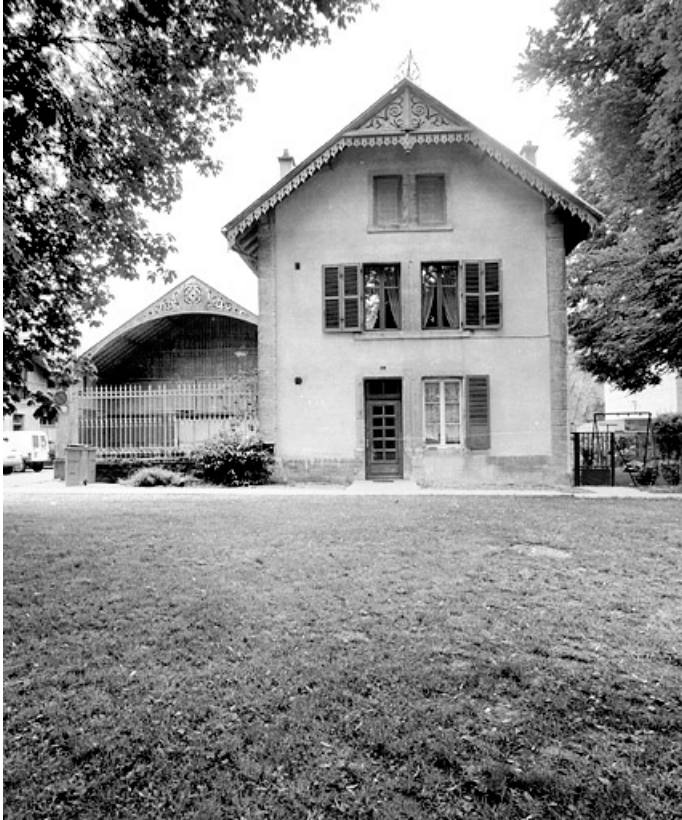
Les écuries : façade du logement.
