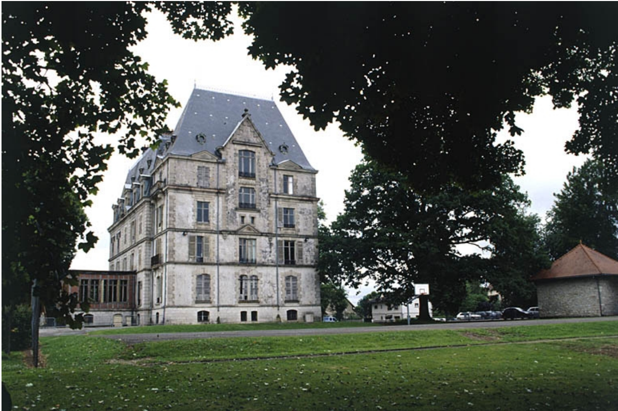
Façade ouest vue de trois quarts gauche.
