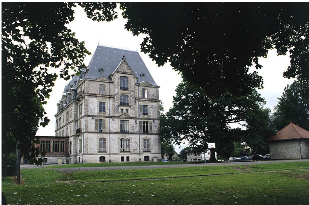
Façade ouest vue de trois quarts gauche.
