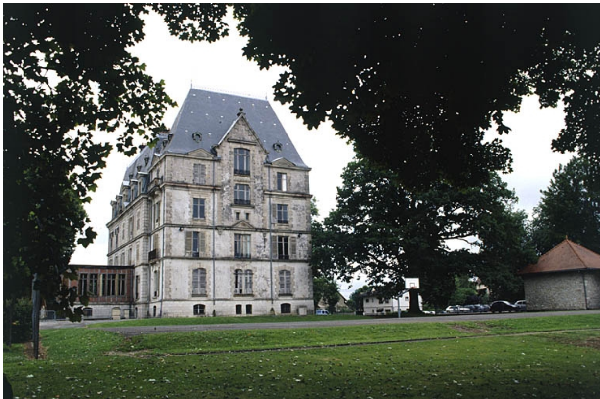
Façade ouest vue de trois quarts gauche.
