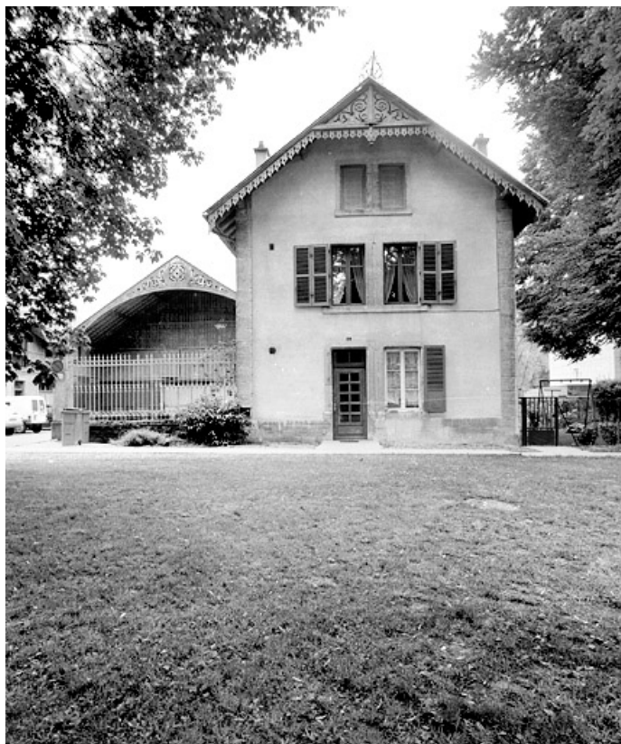
Les écuries : façade du logement.
