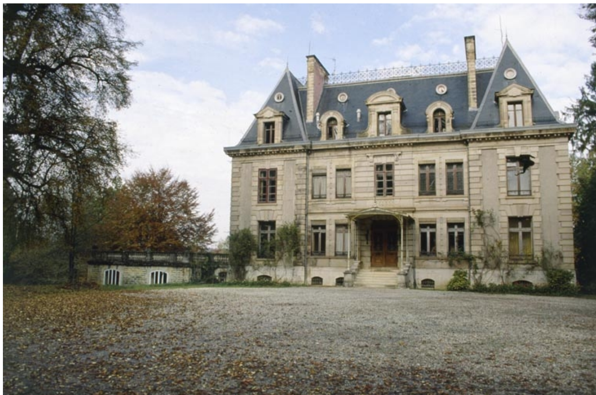
Façade antérieure depuis le sud.
