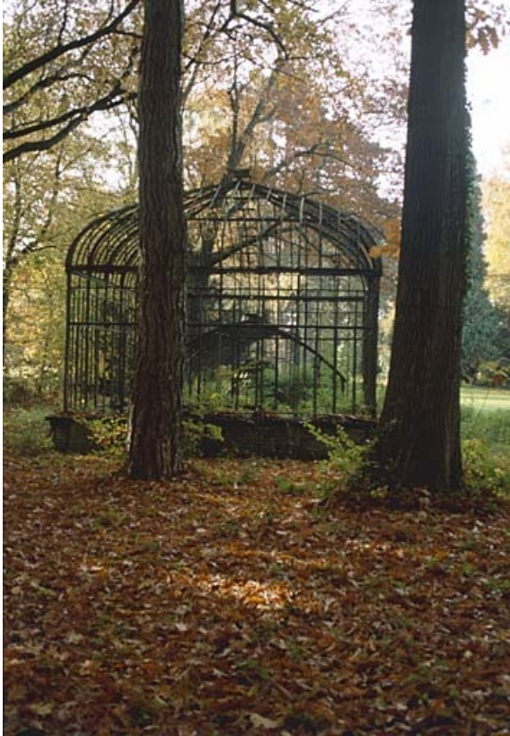
La serre : vue depuis l'est.
