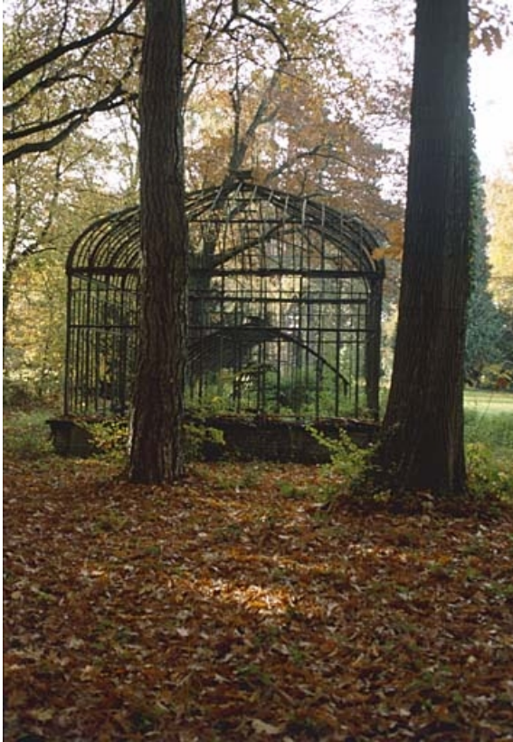
La serre : vue depuis l'est.
