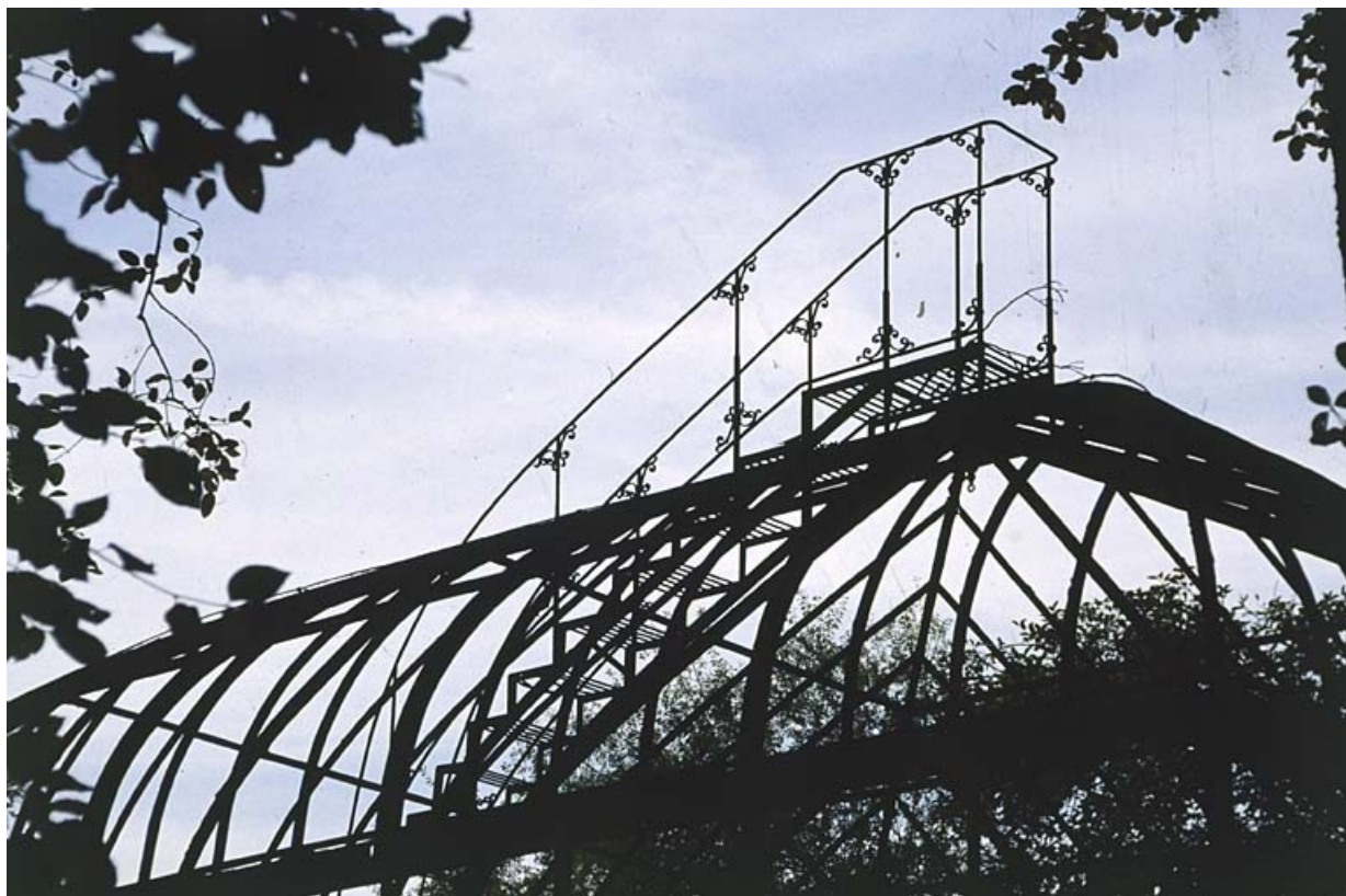
Détail de l'escalier d'accès au dôme de la serre.
