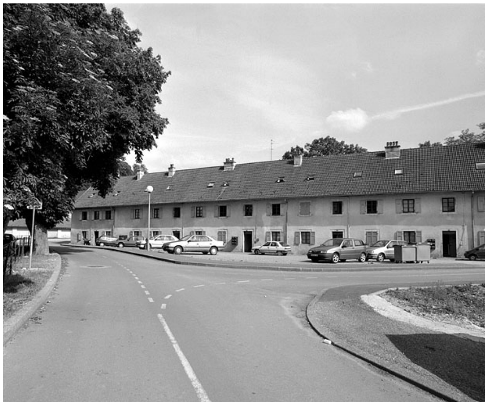
Logement ouvrier collectif (n° 17 à 25 rue du Canal). 90, Méziré rue de l' Allaine
