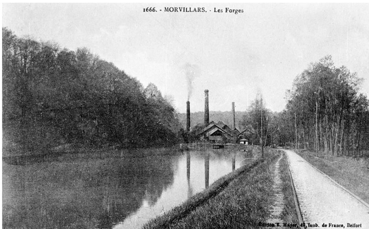
Morvillars - Les Forges. 90, Méziré rue du Canal
