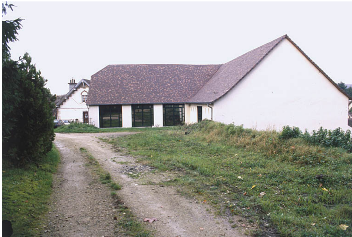
Ancienne halle à charbon depuis l'est. 90, Méziré rue du Canal
