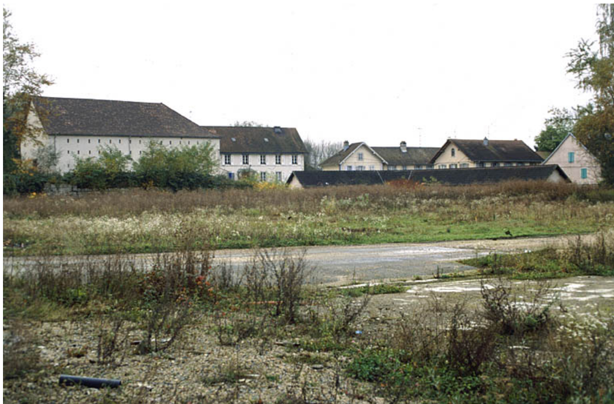
Vue d'ensemble depuis le nord. L'espace au premier plan était occupé par les bâtiments de la forge. 90, Méziré rue du Canal
