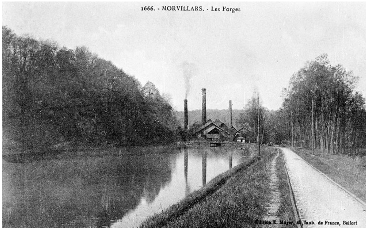
Morvillars - Les Forges. 90, Méziré rue du Canal
