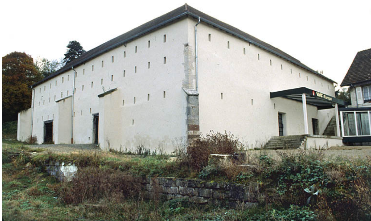
Ancienne halle à charbon depuis le nord-ouest.
