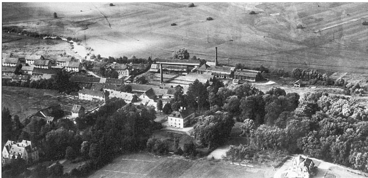
Vue aérienne des forges de Morvillars vers 1960.
