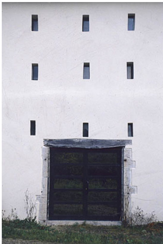
Détail de la façade nord de l'ancienne halle à charbon. 90, Méziré rue du Canal
