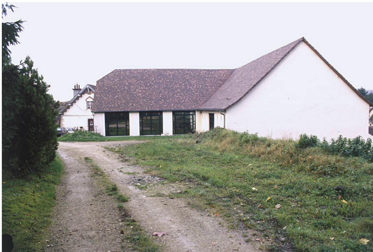
Ancienne halle à charbon depuis l'est.
