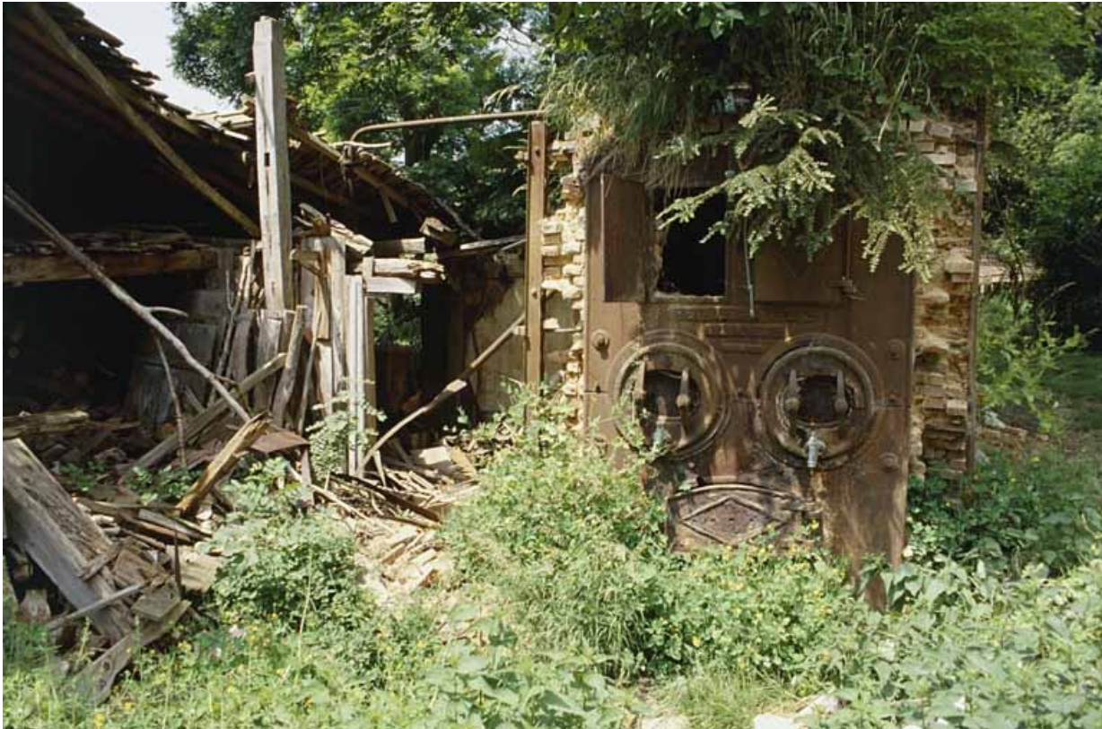
Façade de la chaudière de la machine à vapeur. 90, Suarce R.D. 13
