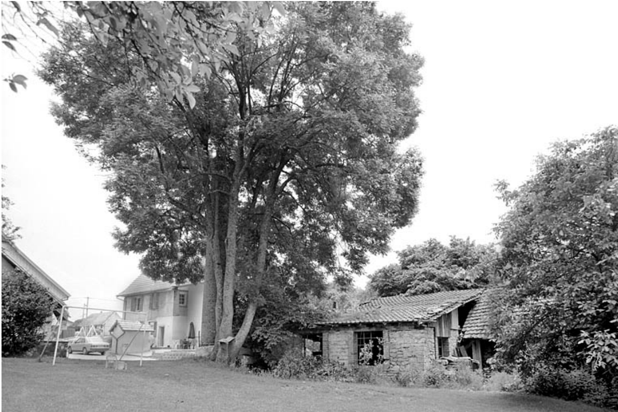
Logement patronal et salle des machines depuis l'ouest. 90, Suarce R.D. 13
