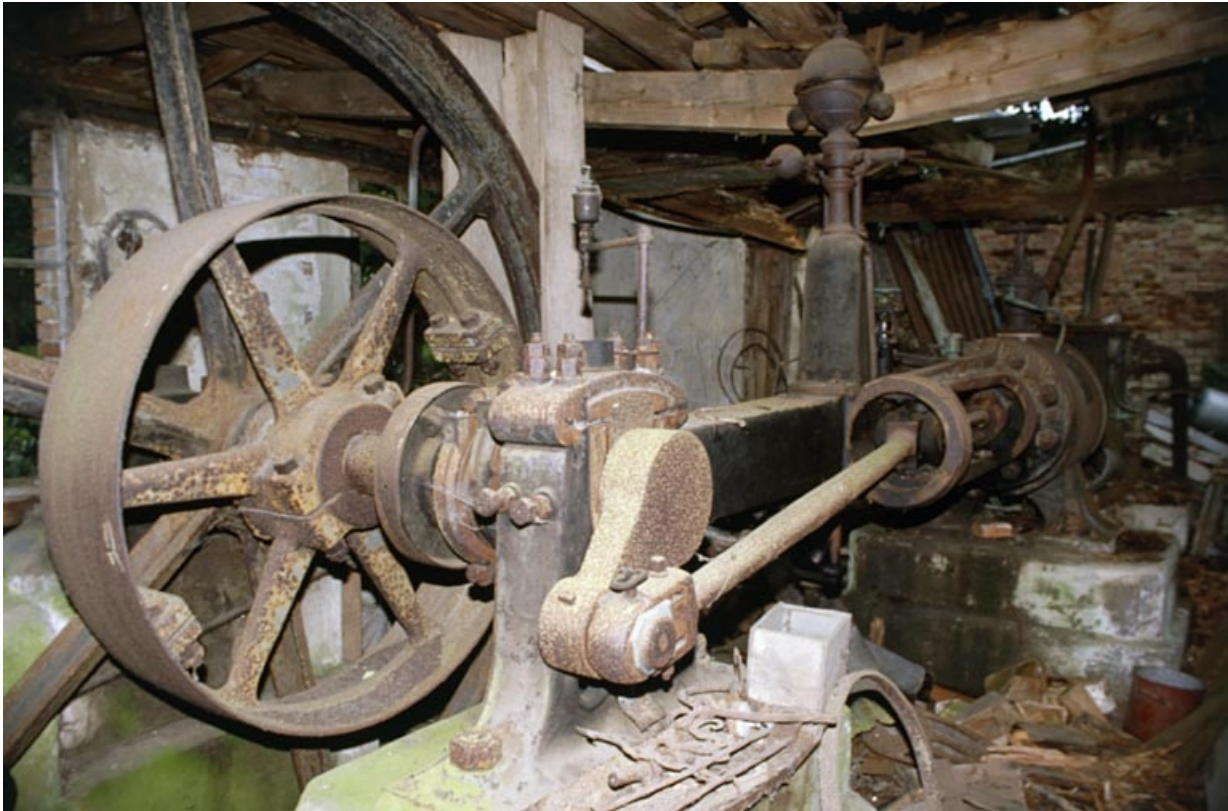
Vue d'ensemble de la machine à vapeur depuis le sud. 90, Suarce R.D. 13
