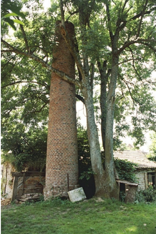
Cheminée et chaudière de la machine à vapeur depuis le nord. 90, Suarce R.D. 13
