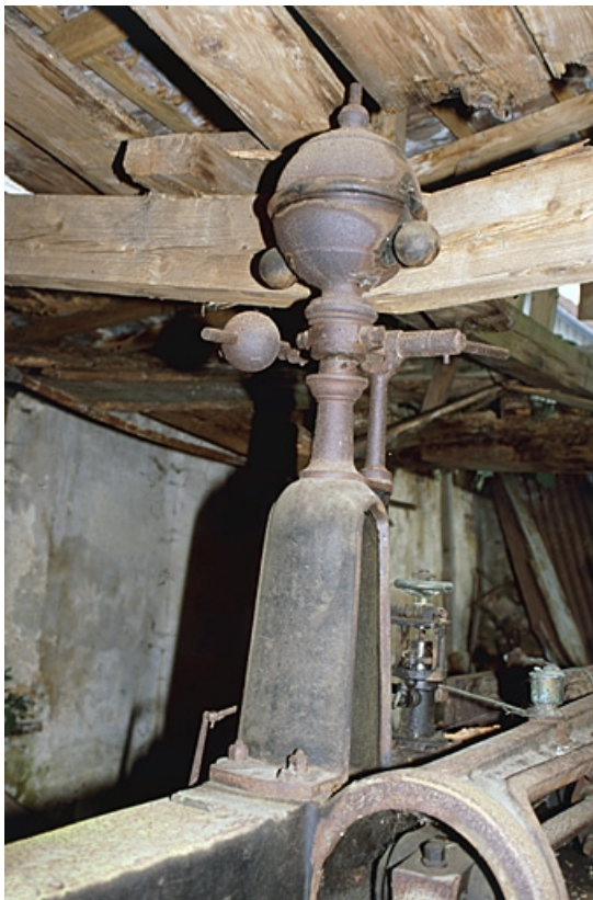
Machine à vapeur : détail du régulateur à boules. L'entrait de la charpente, brisé, repose sur le régulateur. 90, Suarce R.D. 13
