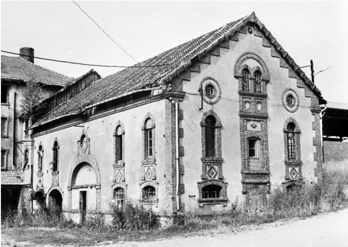
Briqueterie (?) vue de trois quarts vers 1980. 90, Froidefontaine, 2 à 7 rue André Viellard
