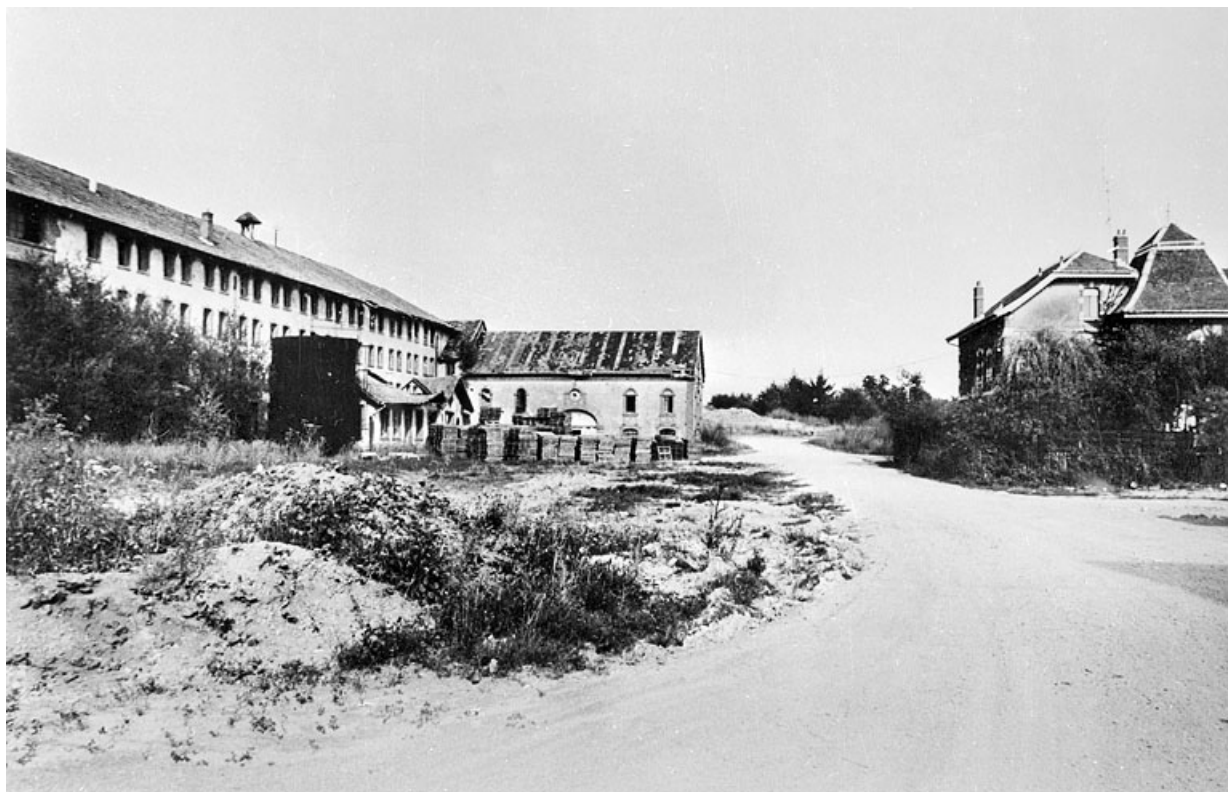
Vue d'ensemble depuis l'ouest vers 1980.
