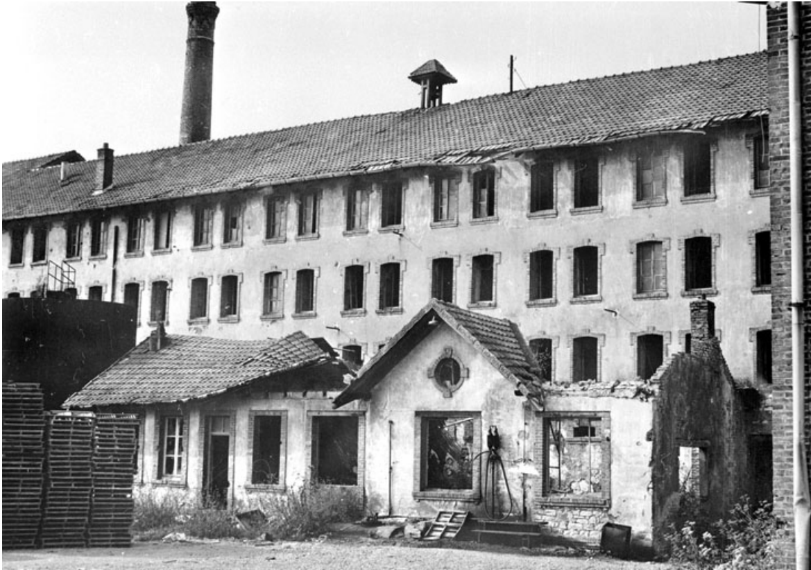
Façade de l'ancienne tuilerie et des bureaux (ruinés) vers 1980.
