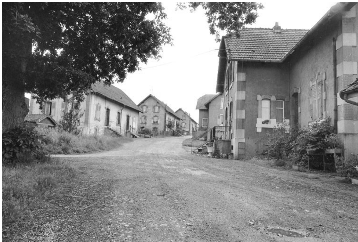
Cité ouvrière en 1980. SRI. Enquête régionale sur les bâtiments industriels (1979-1981). 90, Froidefontaine, 2 à 7 rue André Viellard
