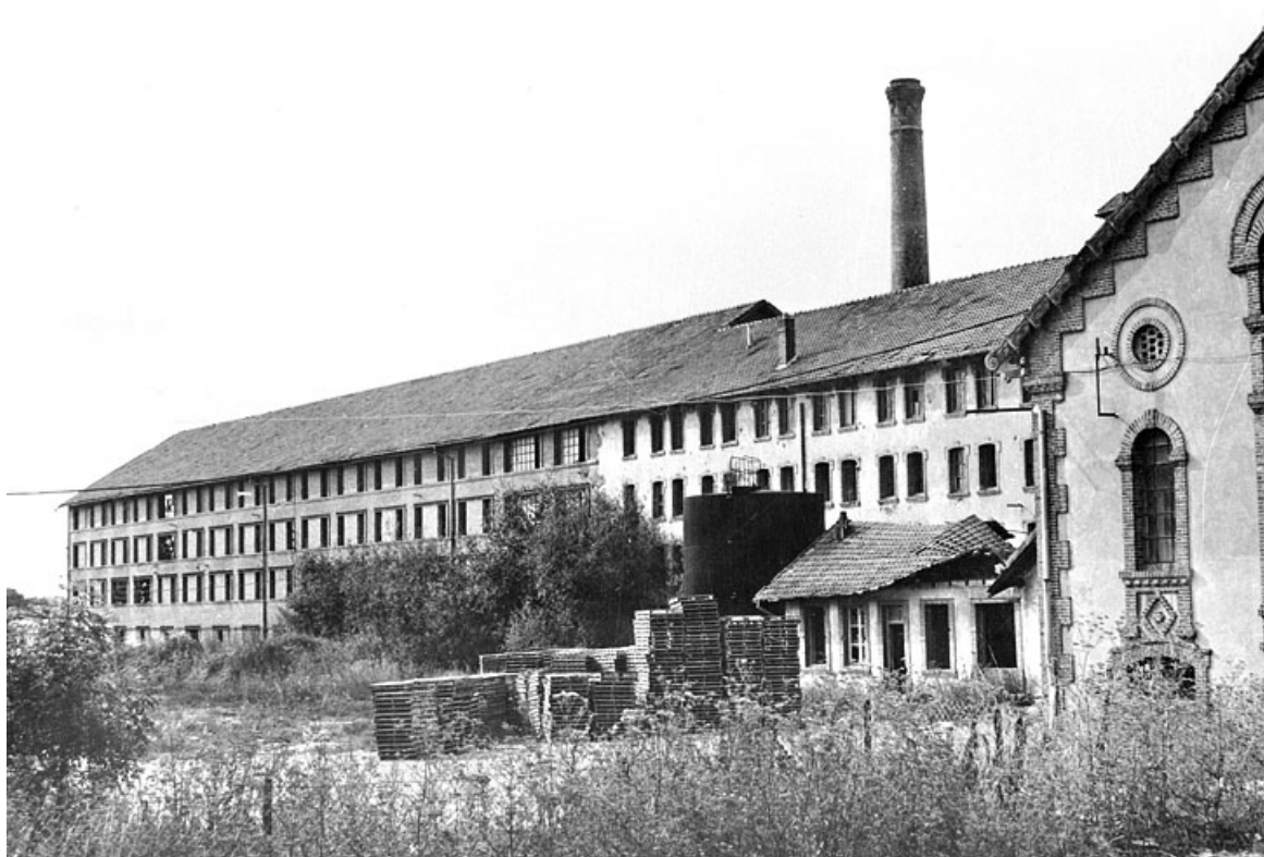
Vue de trois quarts de l'ancienne et de la nouvelle tuilerie vers 1980.
