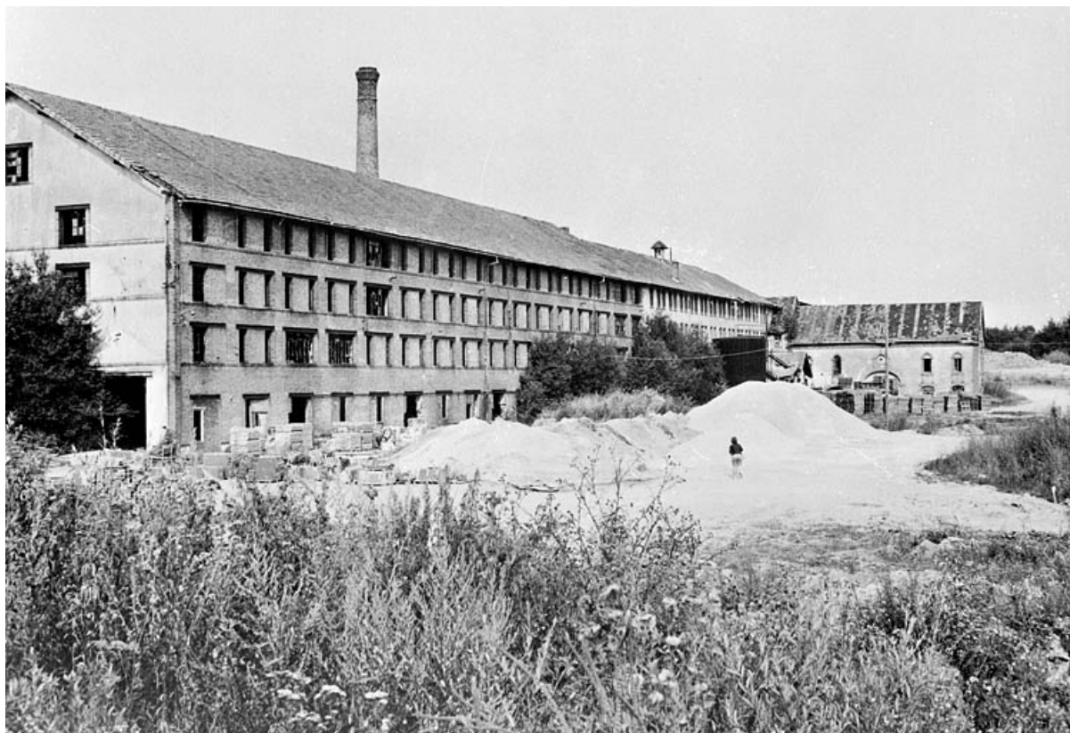
Ancienne et nouvelle tuilerie vers 1980.
