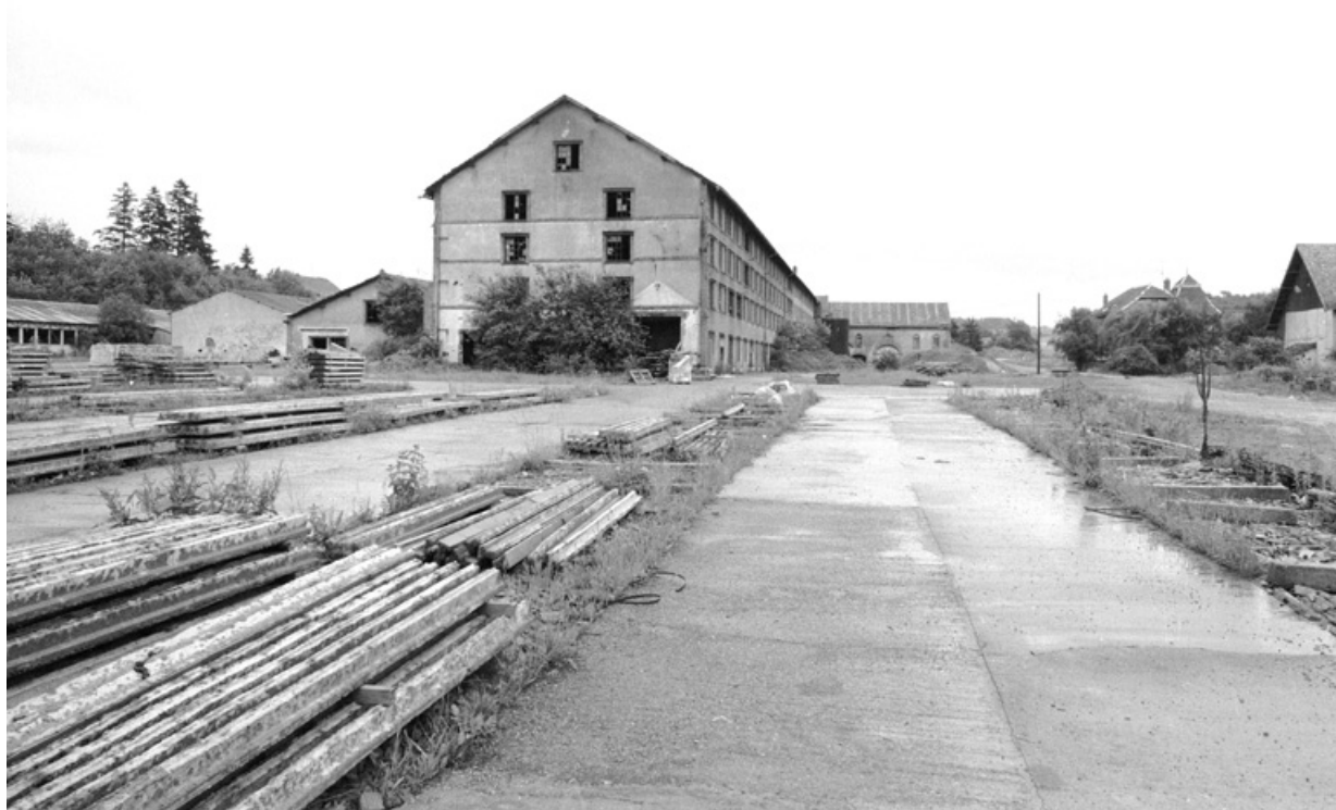
Vue d'ensemble depuis l'ouest en 1980. SRI. Enquête régionale sur les bâtiments industriels (1979-1981). 90, Froidefontaine, 2 à 7 rue André Viellard
