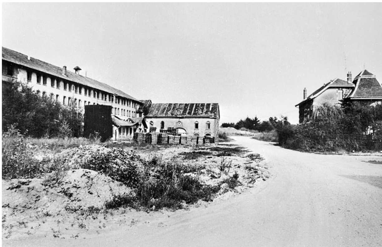
Vue d'ensemble depuis l'ouest vers 1980.
