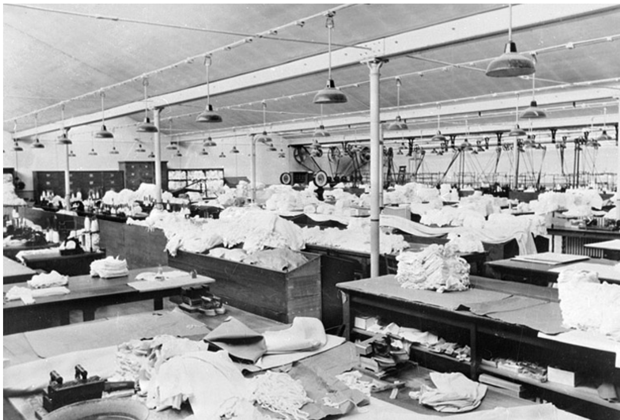
Etage supérieur : atelier de finition (?).
