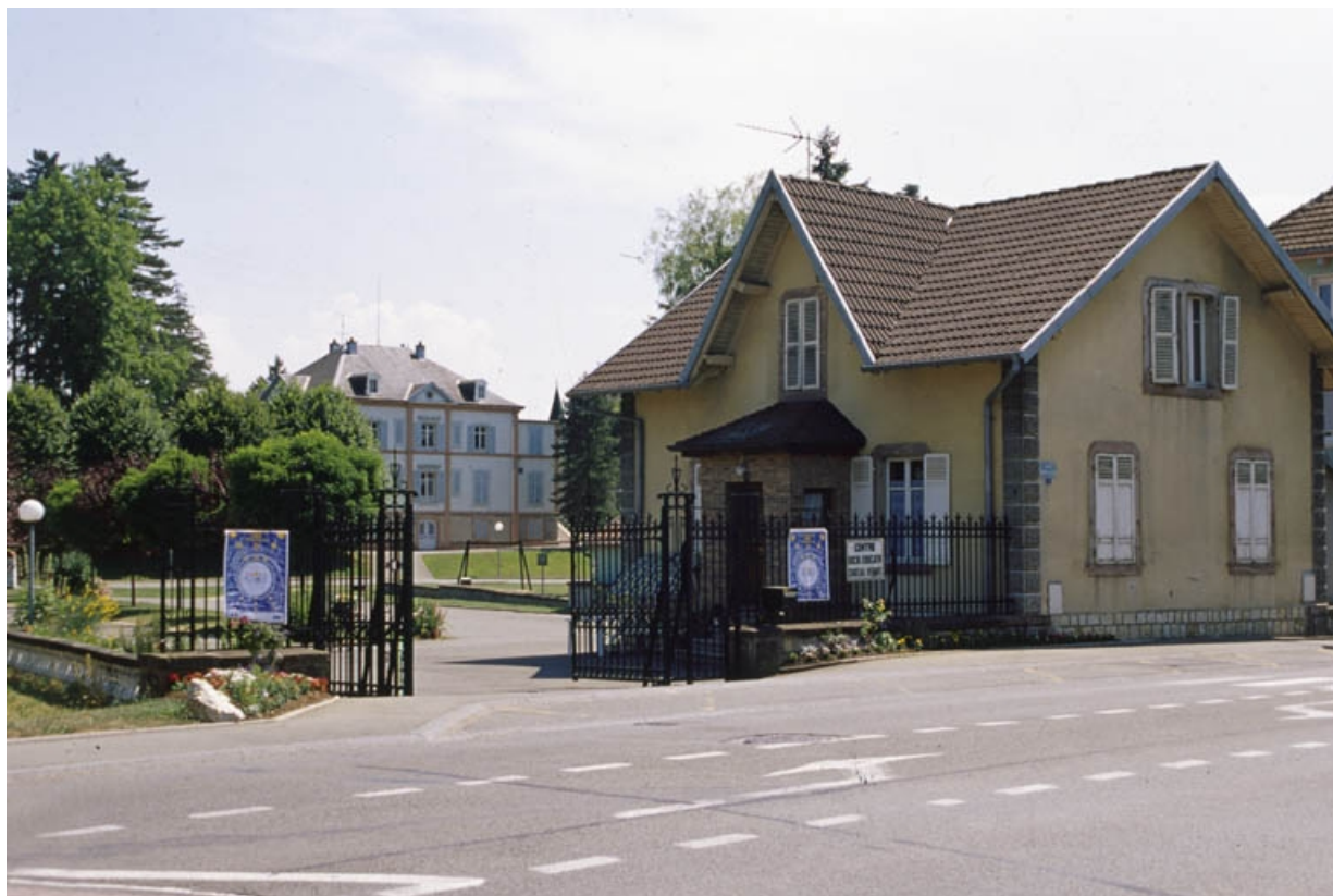
Logement patronal et conciergerie depuis la route départementale.
