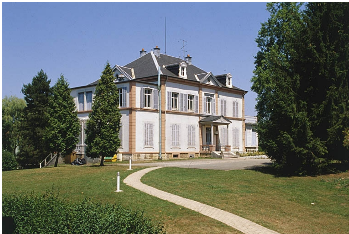
Vue de trois quarts arrière du logement patronal.
