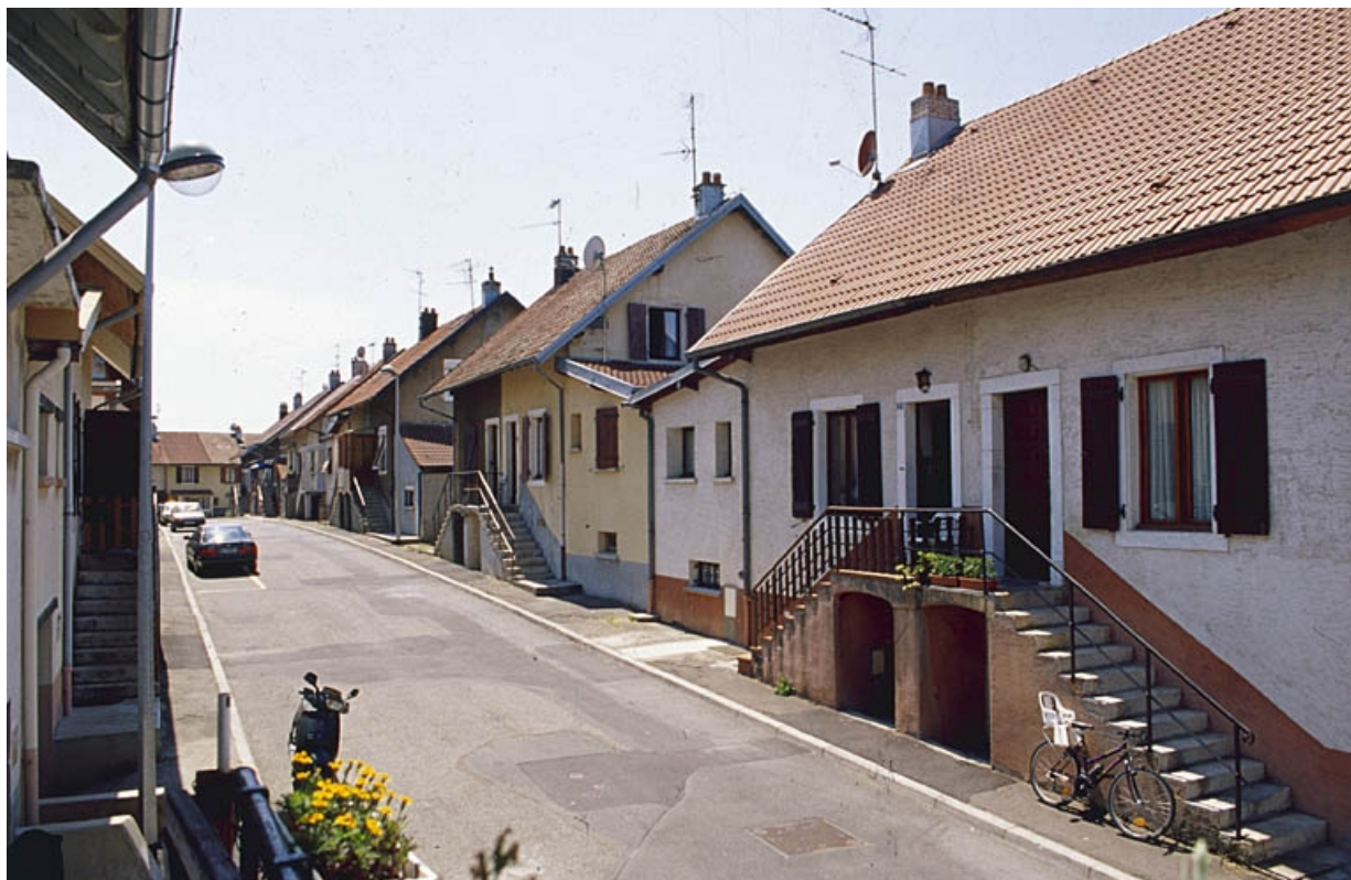
Logements ouvriers rue de la République. 90, Châtenois-les-Forges, 7 avenue des Forges
