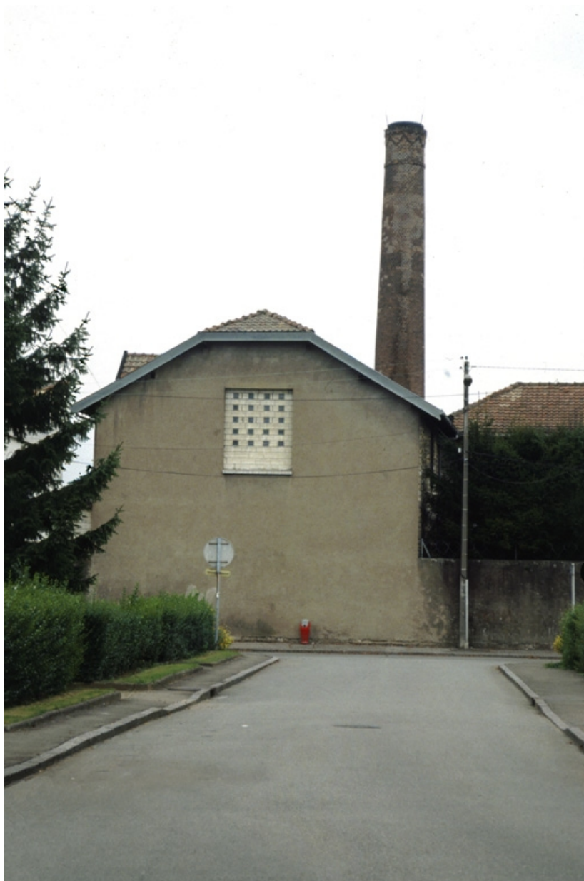
Mur-pignon de l'atelier de fabrication et cheminée depuis l'est.
