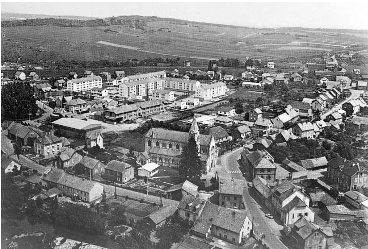
Danjoutin (Territoire de Belfort). Vue générale.
