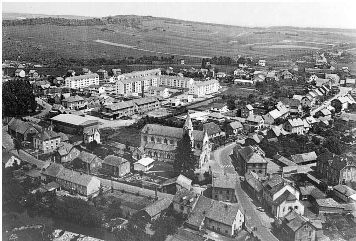
Danjoutin (Territoire de Belfort). Vue générale.
