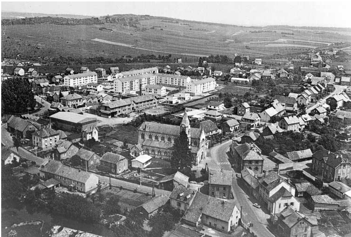
Danjoutin (Territoire de Belfort). Vue générale.
