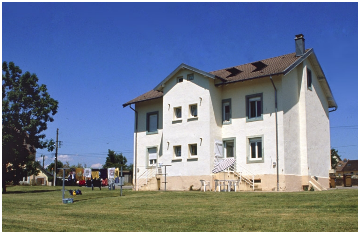
Façade postérieure d'un logement ouvrier.
