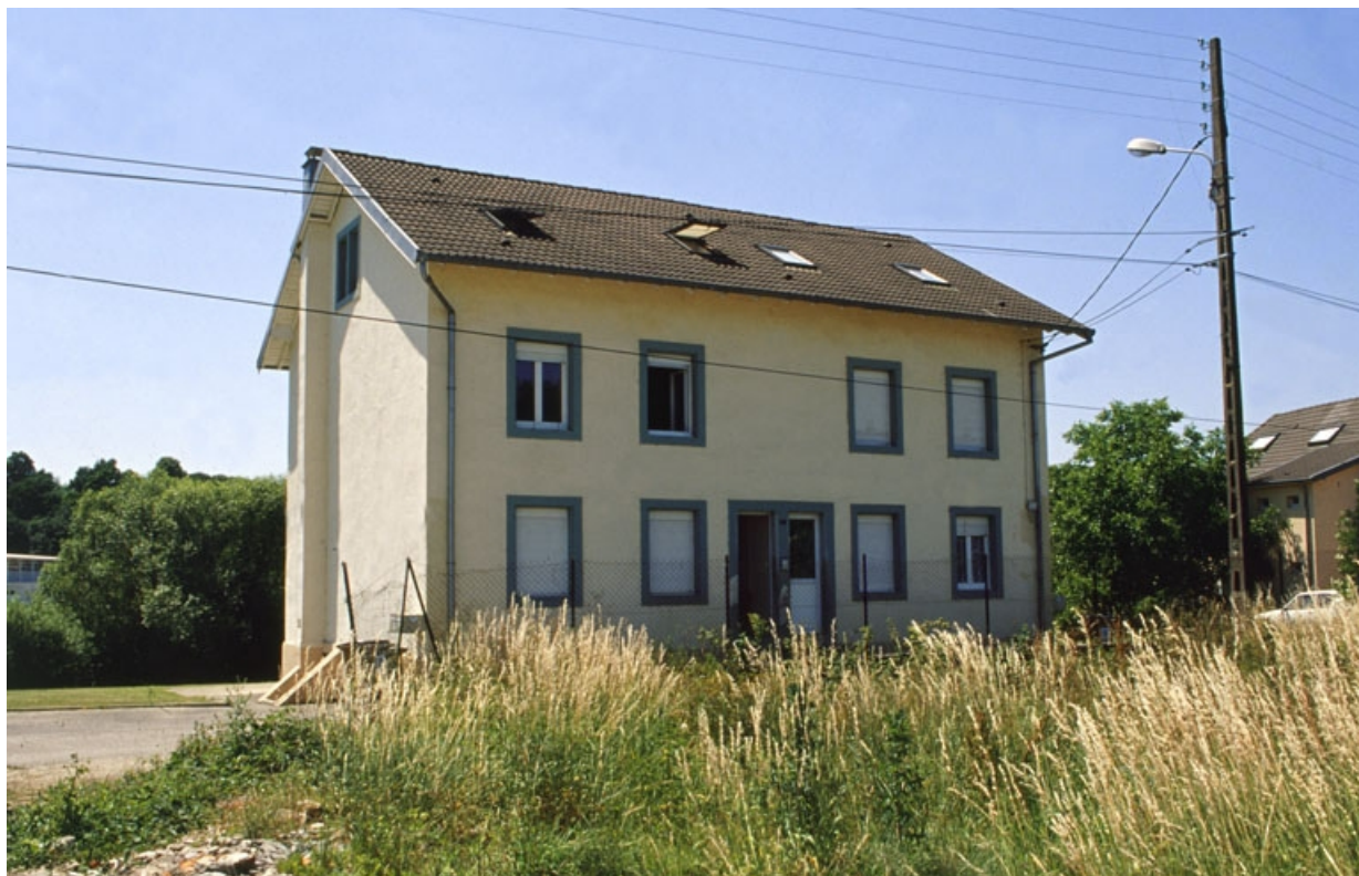
Façade antérieure d'un logement ouvrier rue de la Libération.
