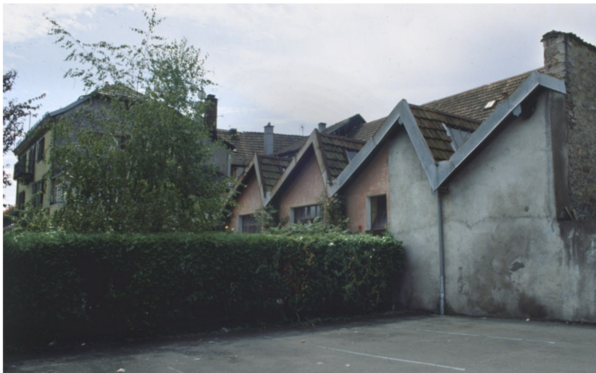
L'atelier de fabrication depuis le nord.
