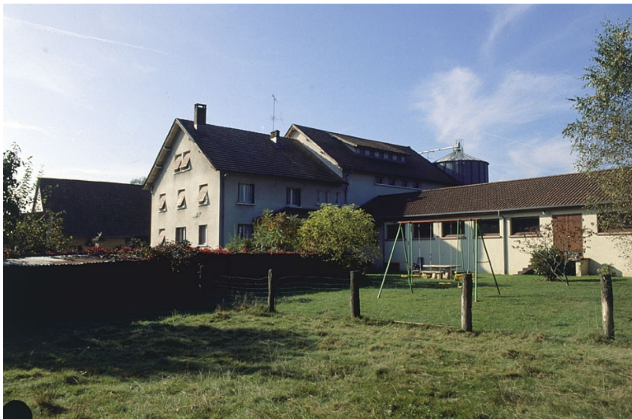
Façade postérieure du logement et de l'atelier de fabrication de la minoterie.
