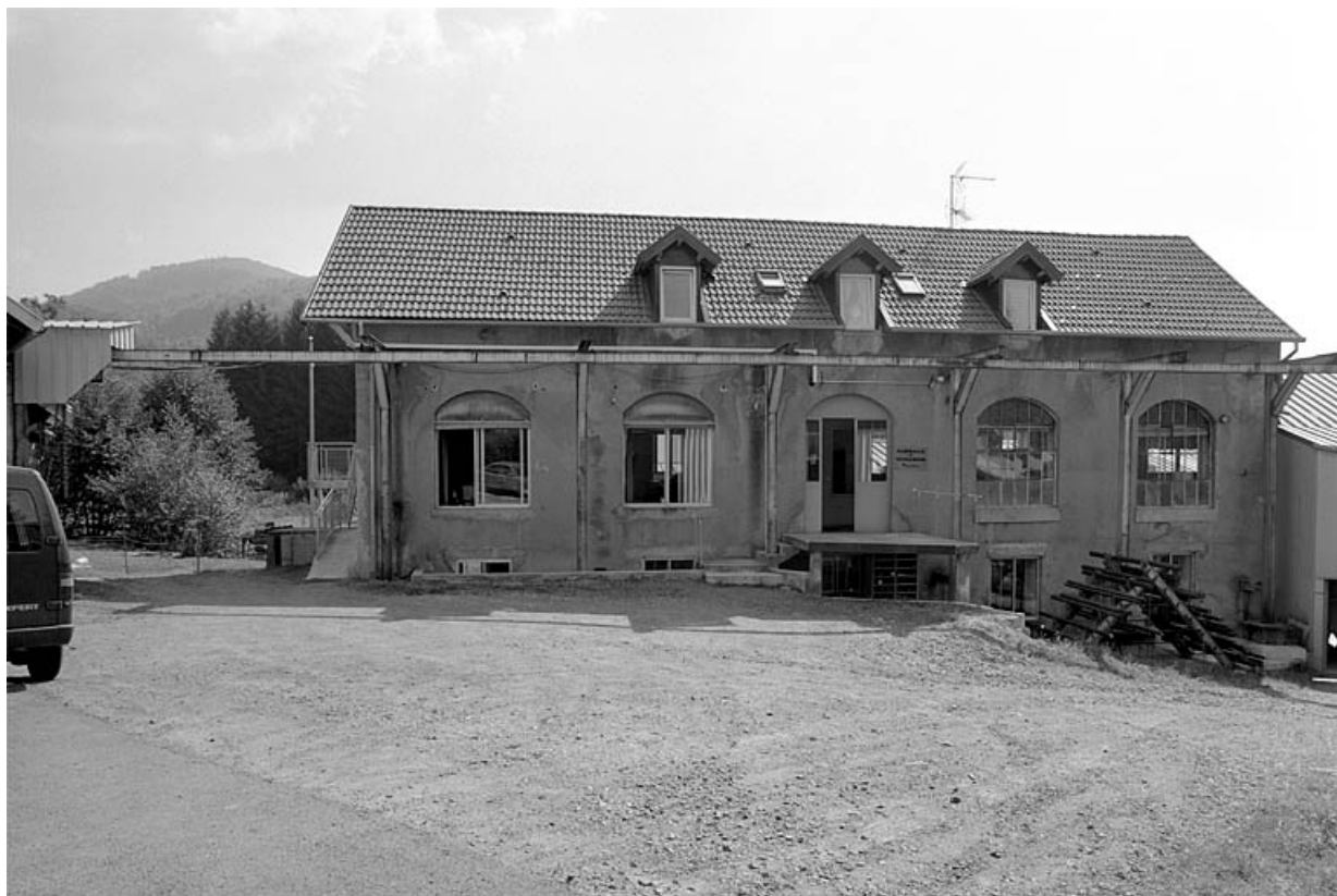
Façade ouest de l'atelier de fabrication primitif.
