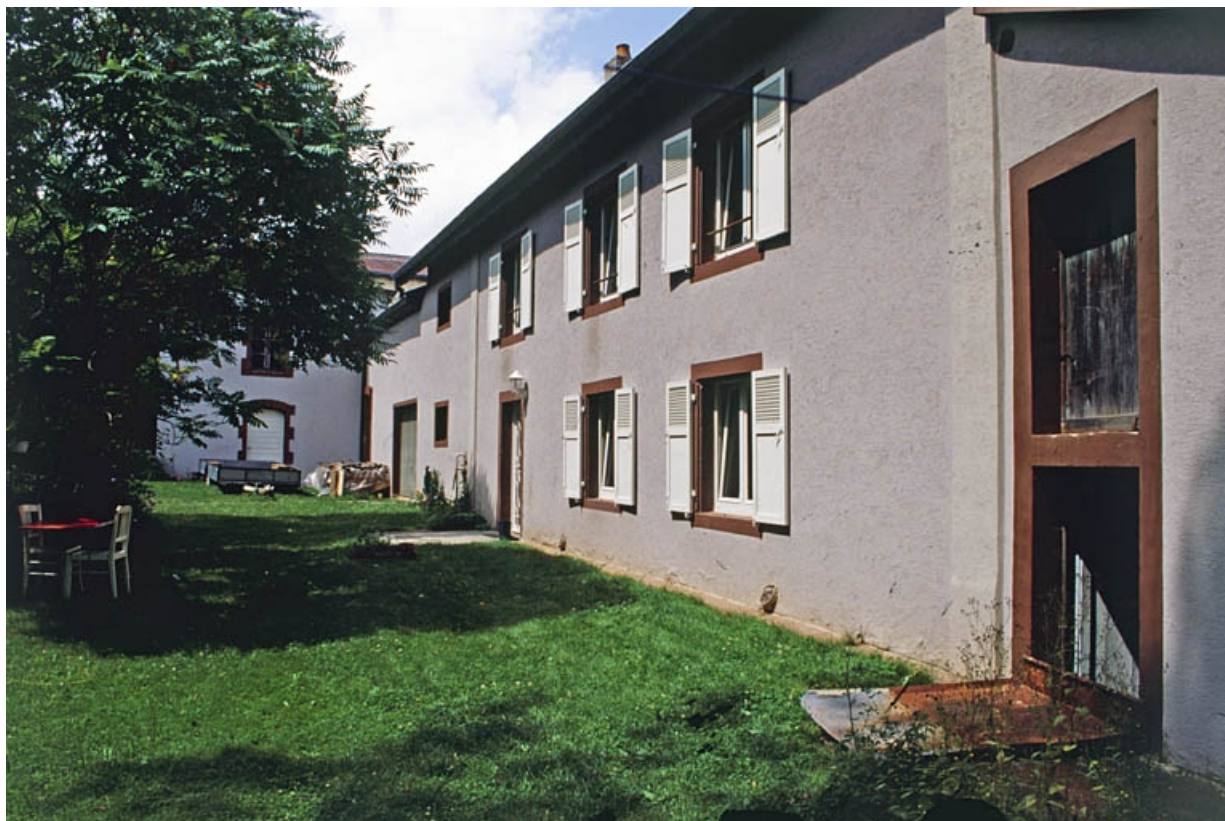
Bâtiment d'eau et atelier de fabrication (au fond) et logement.
