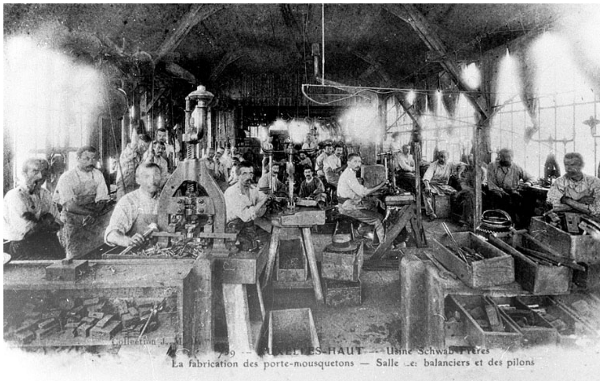
Auxelles-Haut - Usines Schwab Frères. La fabrication des porte-mousquetons. Salle des balanciers et des pilons. 90, Auxelles-Haut, 56 rue des Roches
