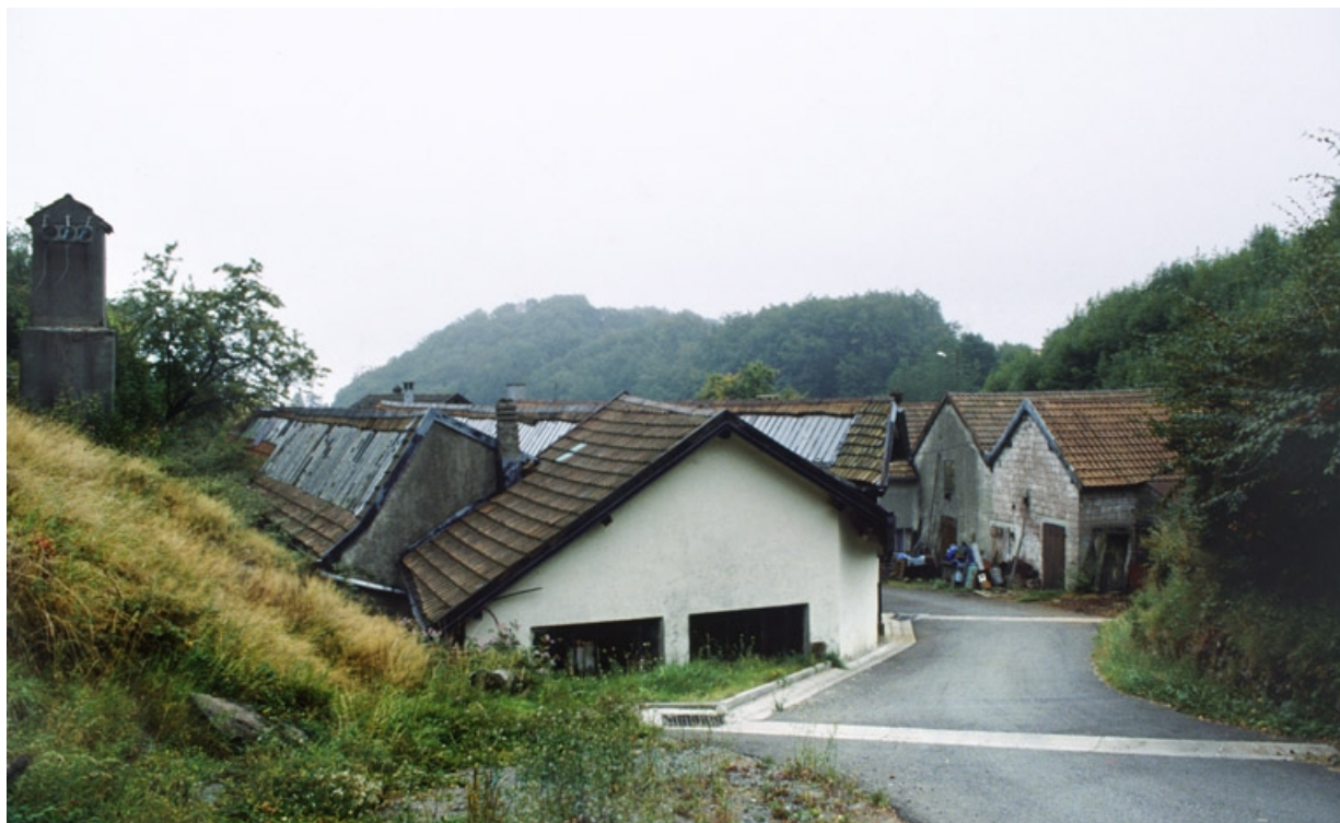
De gauche à droite : transformateur, atelier de fabrication, entrepôt industriel et atelier de réparation. 90, Auxelles-Haut, 48, 50 rue des Bruyères
