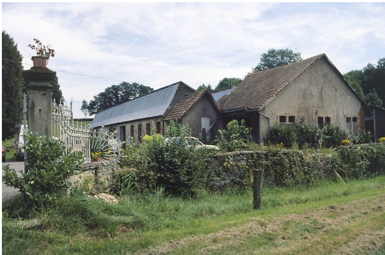
Atelier de fabrication et salle des machines depuis l'entrée.
