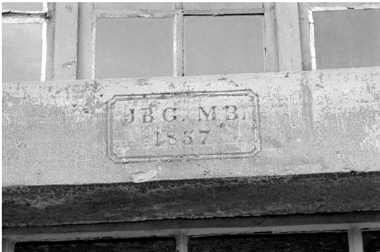
Cartouche gravé sur un linteau de porte de l'atelier de fabrication (eaux gazeuses). SRI. Enquête régionale sur les bâtiments industriels (1979-1981).
