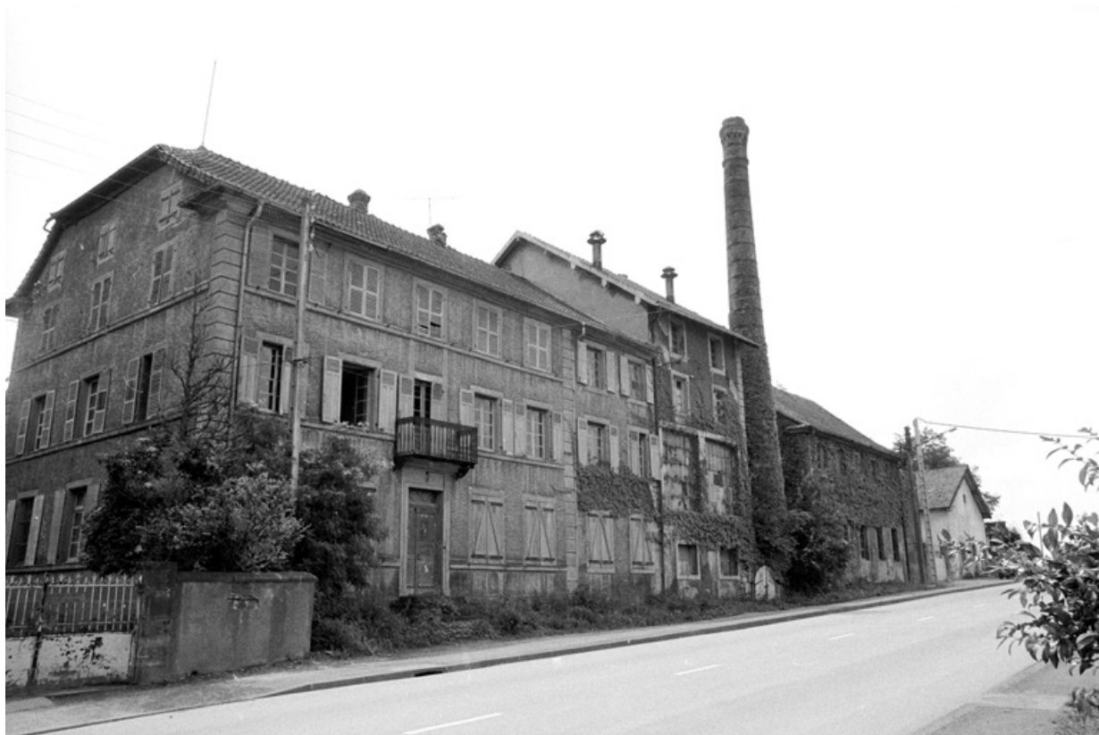
Façades sur rue en 1980. SRI. Enquête régionale sur les bâtiments industriels (1979-1981). 90, Lachapelle-sous-Rougemont, 4, 6 rue du Général de Gaulle
