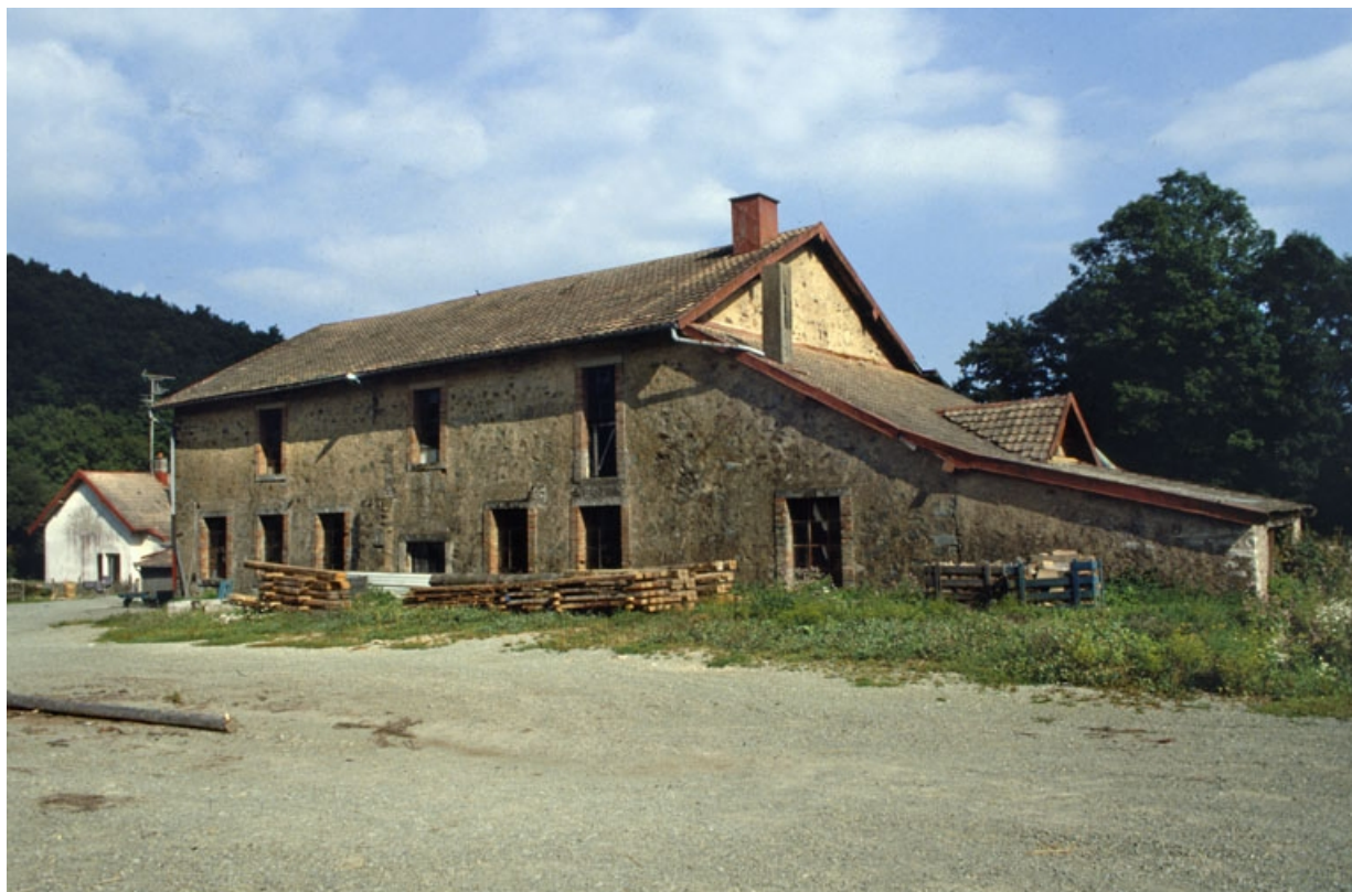
L'atelier de fabrication depuis le sud-est.
