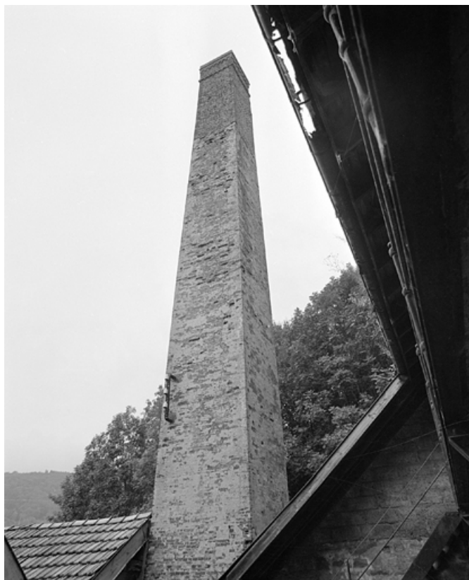
Cheminée de la chaufferie.
