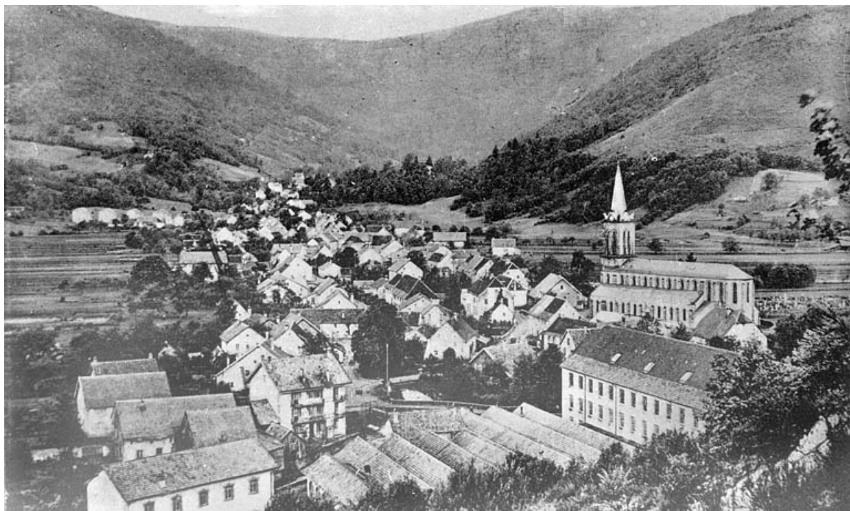
Le Puix. Vue générale.
