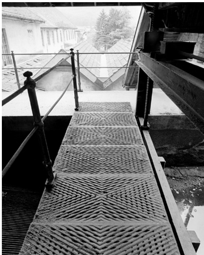
Passerelle sur le canal.
