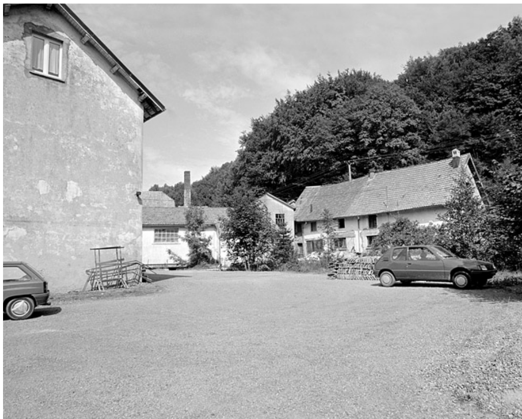
Logements d'ouvriers depuis le sud.
