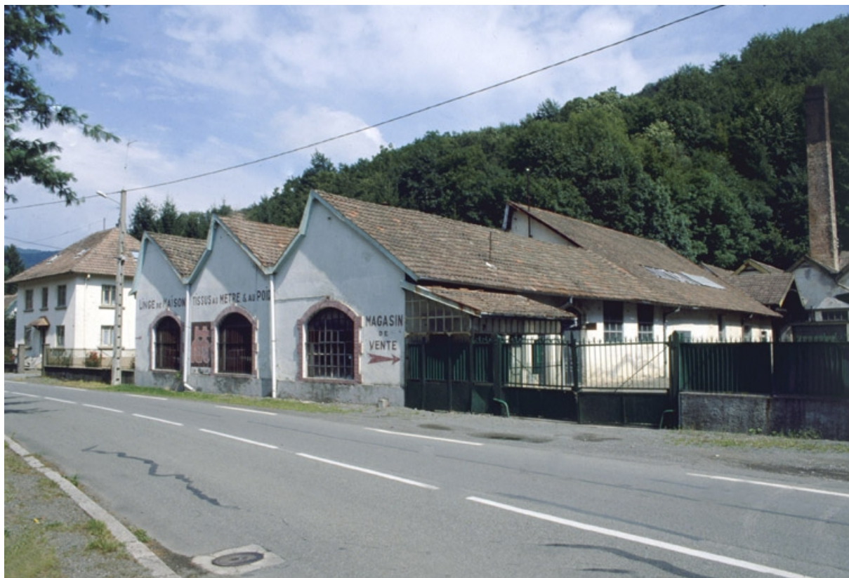
Magasin de vente et ateliers de fabrication nord.
