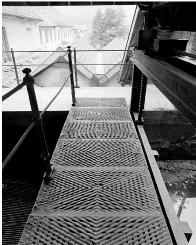
Passerelle sur le canal.
