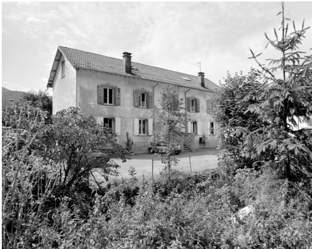
Façade antérieure du logement d'ouvriers.
