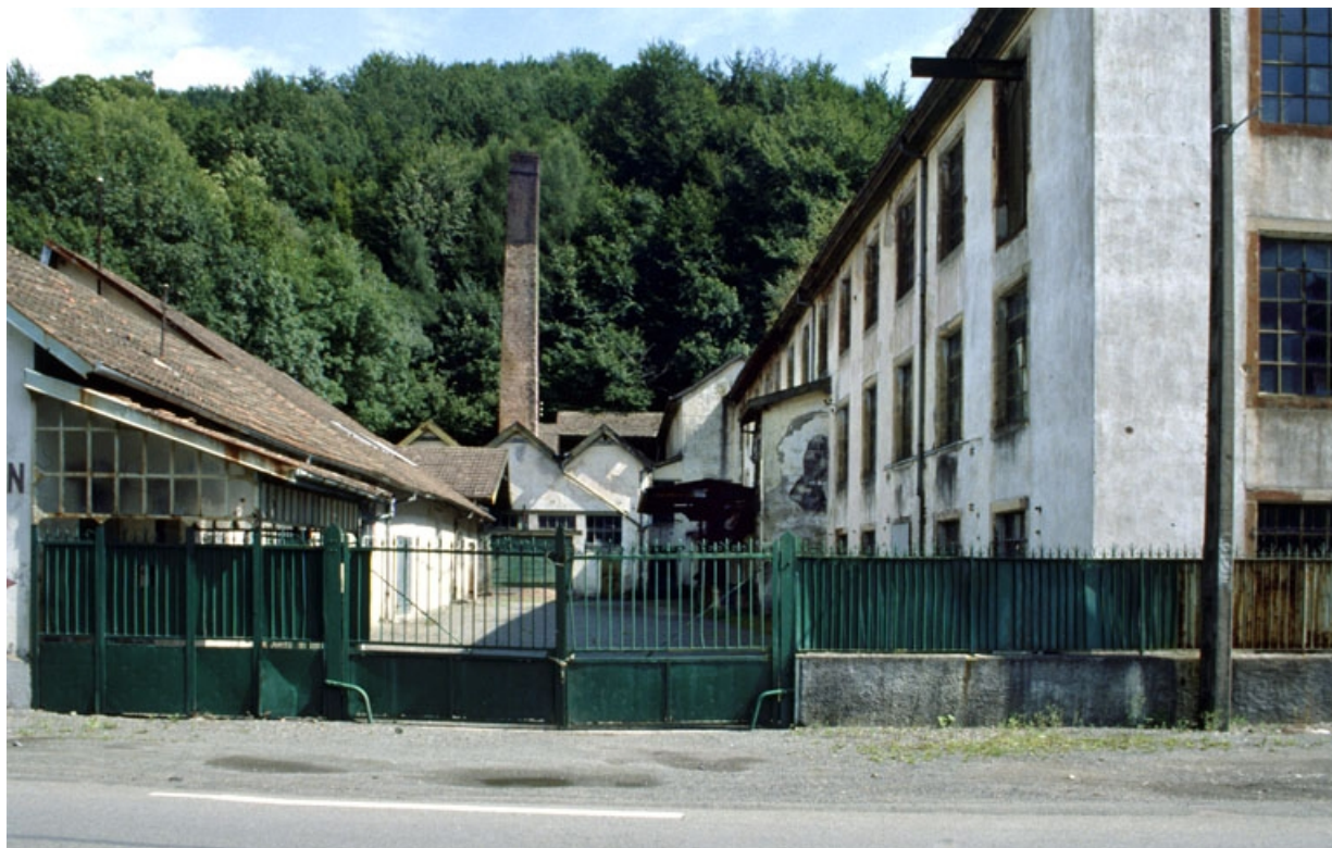
La cour de l'usine.
