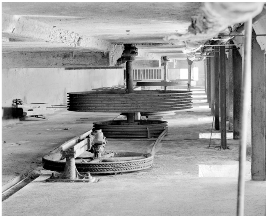
Poulies de transmission dans le couloir des câbles.
