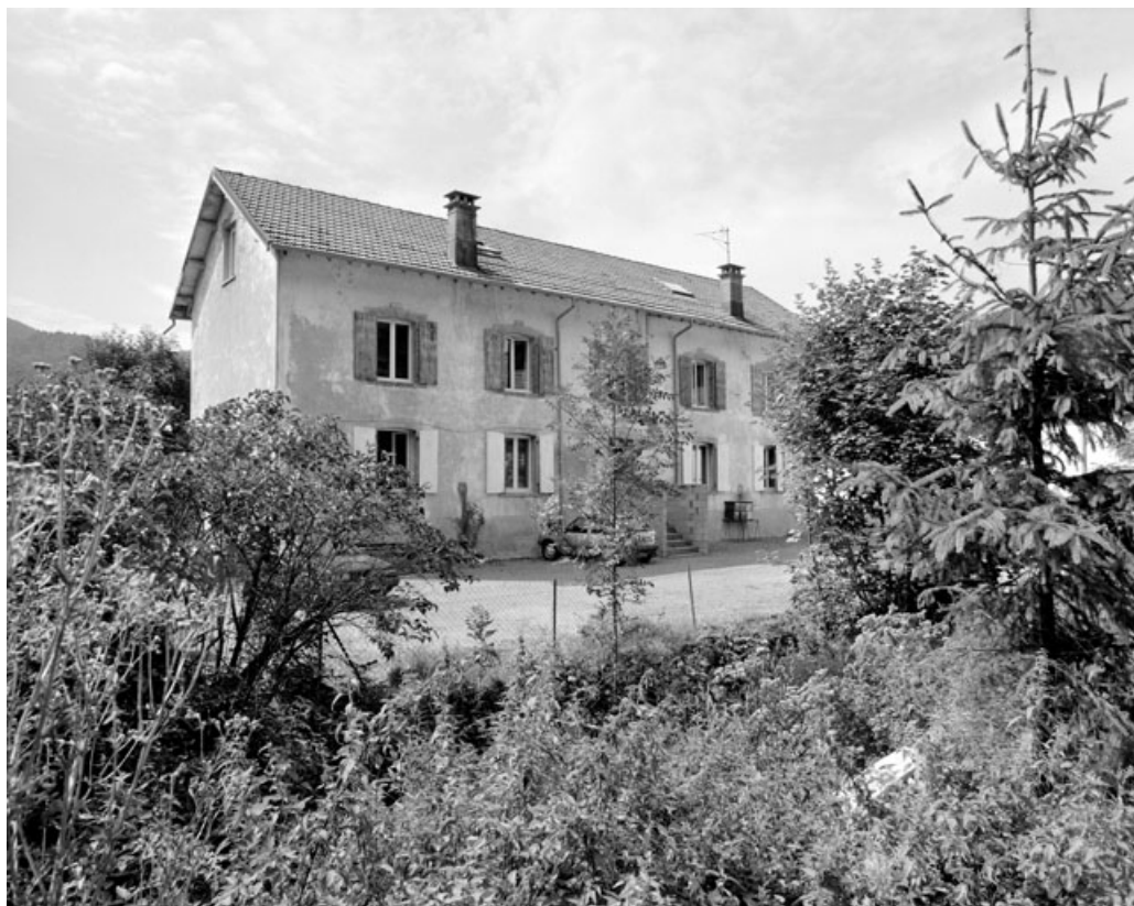
Façade antérieure du logement d'ouvriers.
