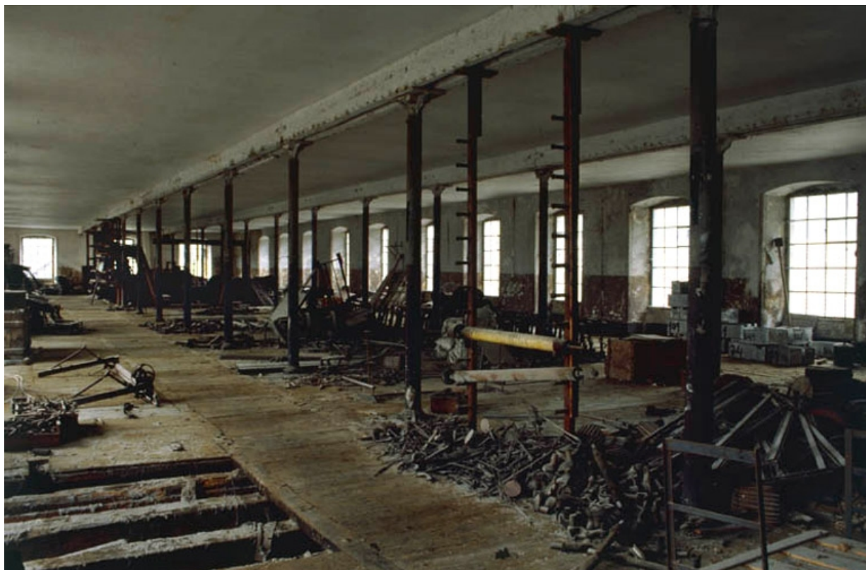
Salle de tissage du bâtiment à étages.
