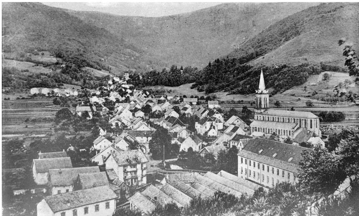
Le Puix. Vue générale.
