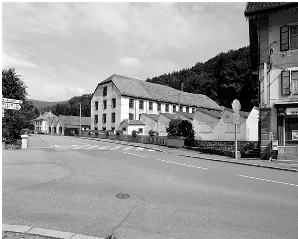
Vue d'ensemble depuis le sud-ouest. 90, Lepuix R.D. 465
