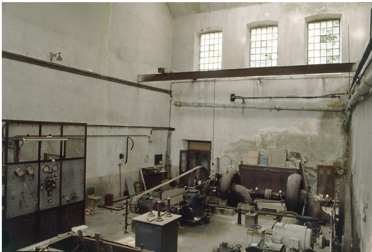
Vue d'ensemble du bâtiment d'eau (ancienne salle des machines). 90, Lepuix R.D. 465
