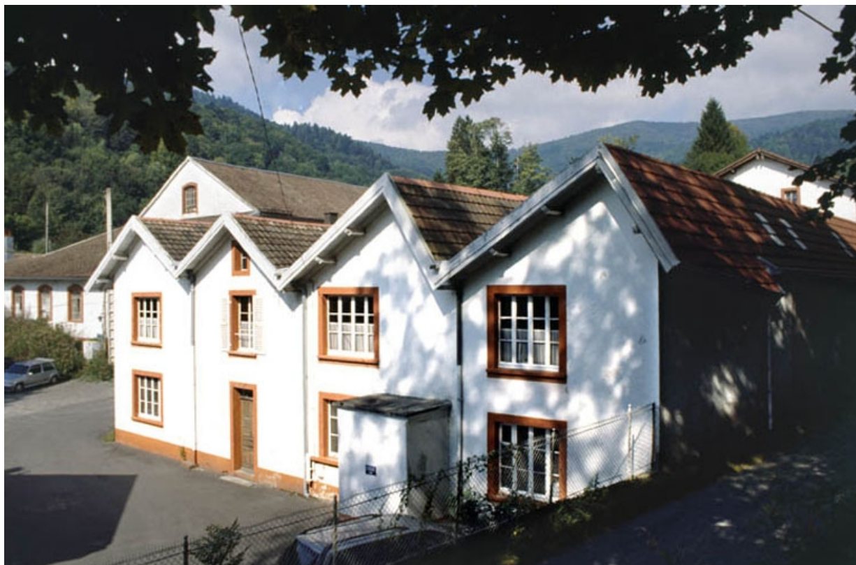
Bâtiment abritant les bureaux et l'atelier de réparation.
