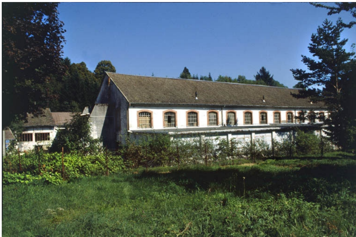
Façade occidentale de la salle de tissage.
