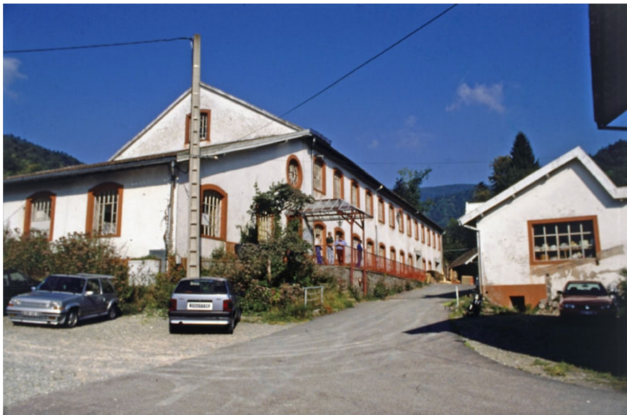
Atelier de fabrication (salle de tissage) depuis le sud-est.
