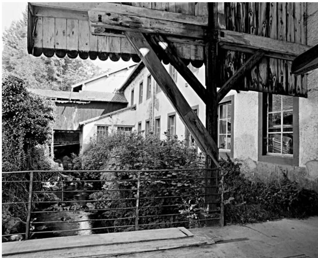
Façade sur le canal de la Beucinière de l'atelier de fabrication (préparation, bobinage, ourdissage, etc). 90, Lempdes, 10 rue de Chauveroches
