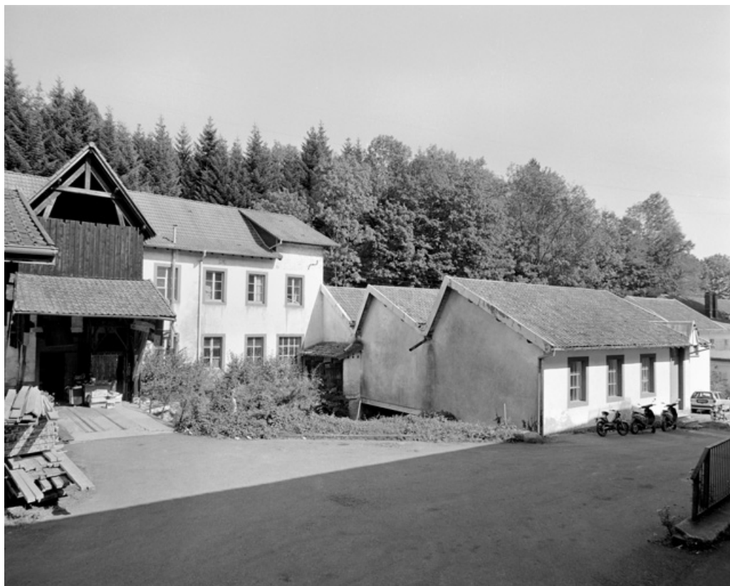
Extrémité sud de l'atelier de fabrication et atelier de réparation (forge).
