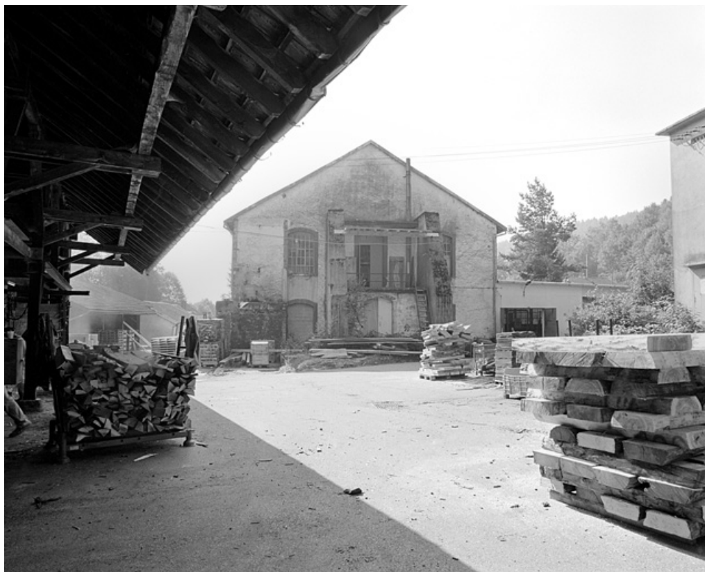
Pignon nord de la salle de tissage.
