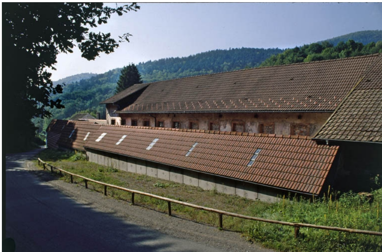
L'atelier de fabrication depuis la rue de Chauveroche.
