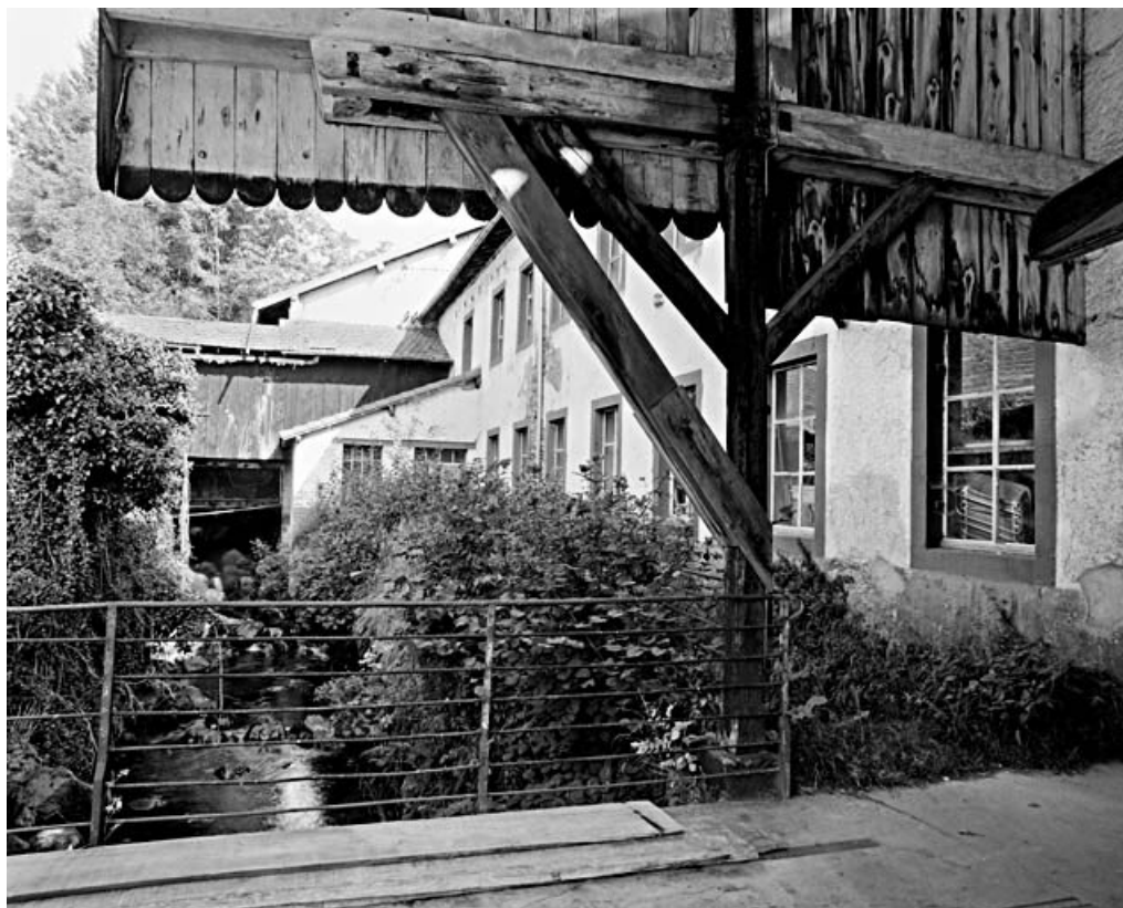
Façade sur le canal de la Beucinière de l'atelier de fabrication (préparation, bobinage, ourdissage, etc). 90, Lempuix, 10 rue de Chauveroché
