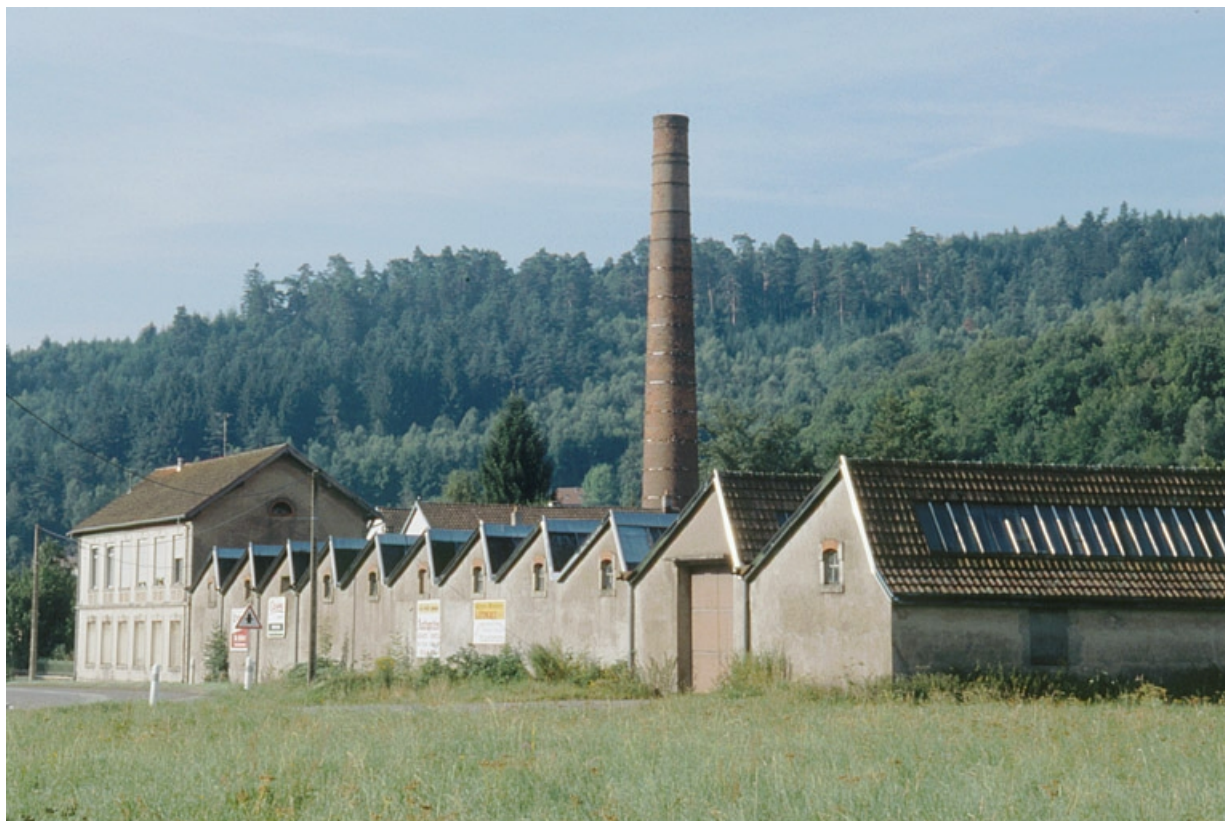
Façade sur la route départementale 465. 90, Lepuix R.D. 465
