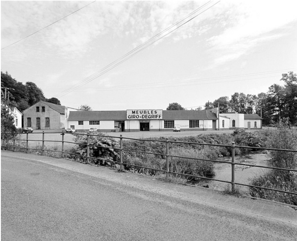
Vue d'ensemble depuis le pont de la Savoureuse.
