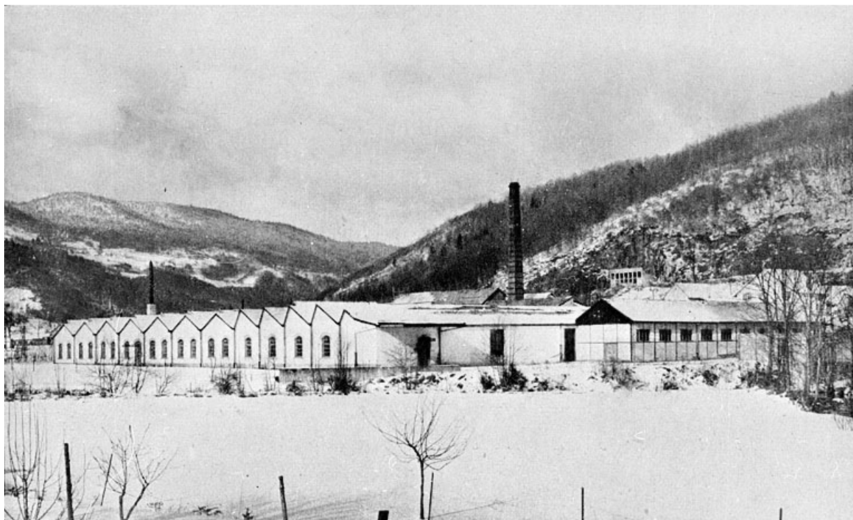
Vue d'ensemble depuis le sud.
