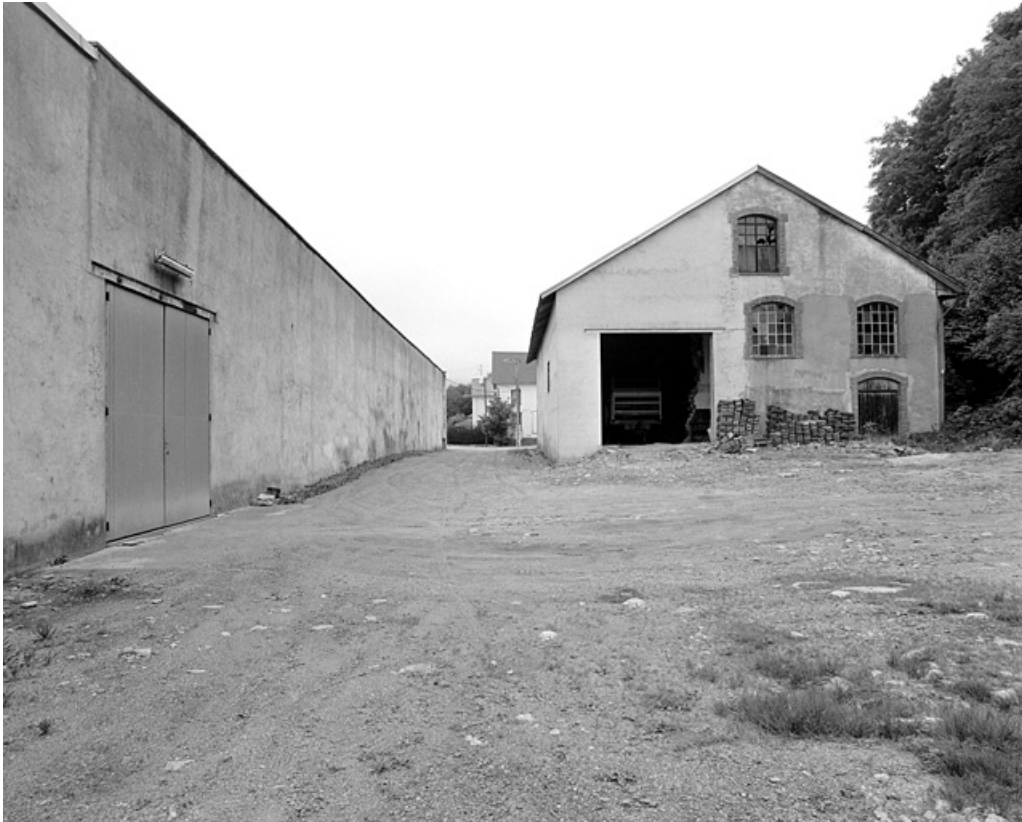
Façade postérieure de la salle des machines.
