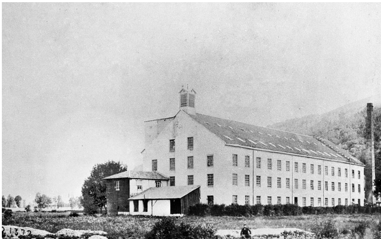
Vue d'ensemble de la filature.
