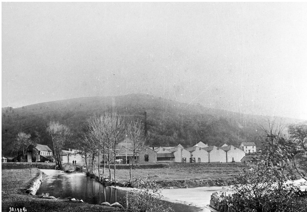
Société Anonyme de Filature et Tissage de Giromagny. Usine de la Fonderie : vue d'ensemble.
