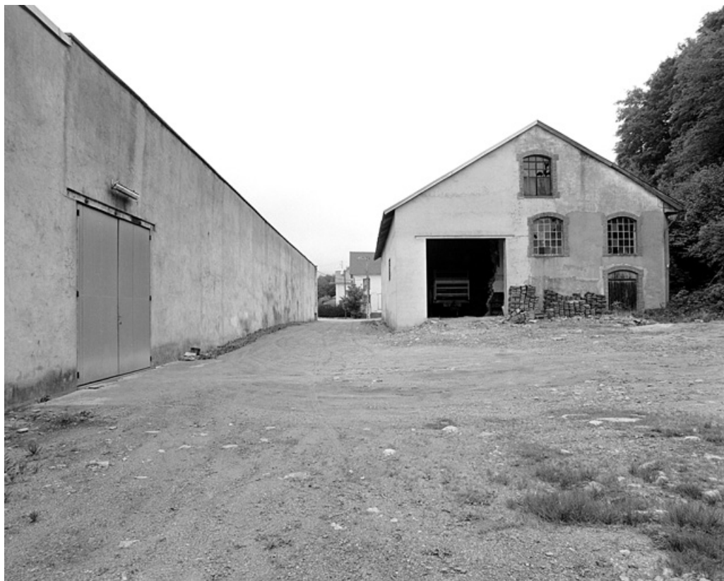
Façade postérieure de la salle des machines.
