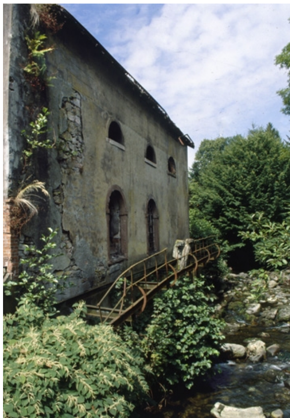
Façade sur la Savoureuse de la salle des machines. 90, Giromagny Grande Rue 31 à 35
