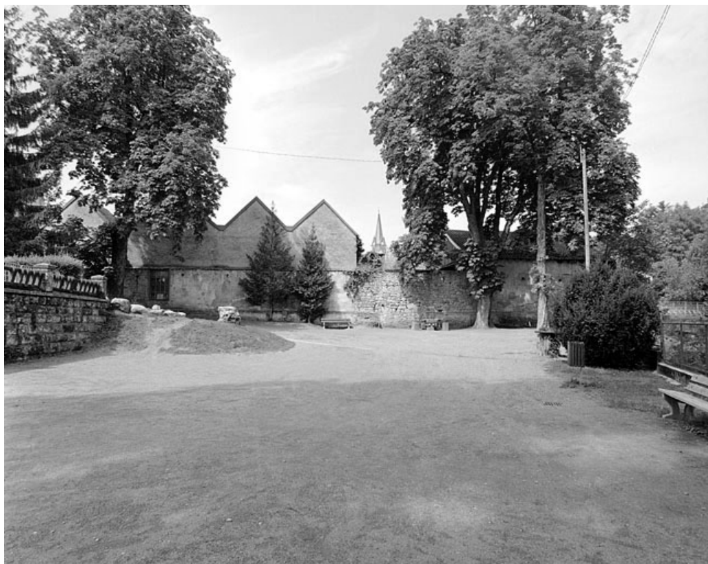
Murs-pignons postérieurs depuis le parc de l'ancien logement patronal.
