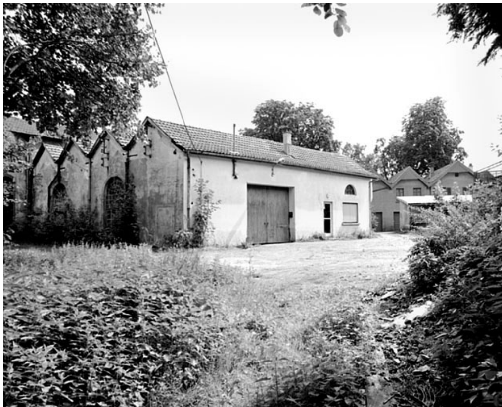
Salle des machines et chaufferie depuis l'ouest.
