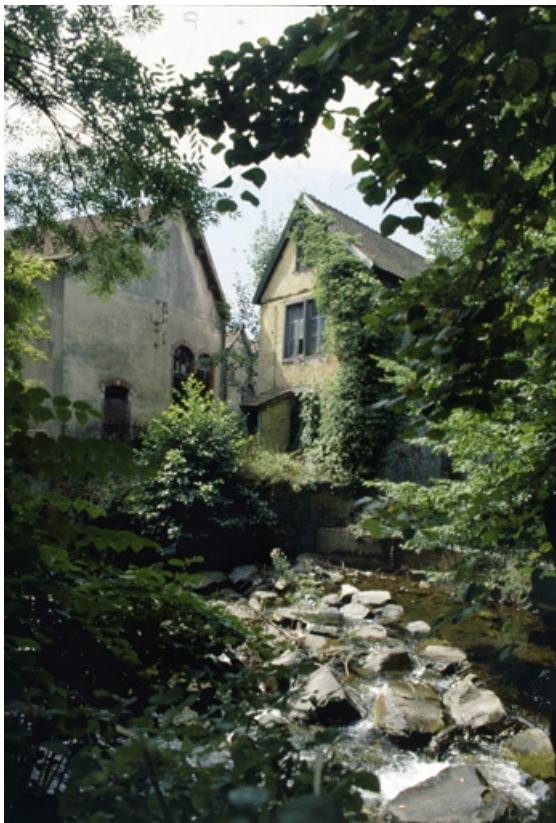
Murs-pignons de la salle des machines et de l'atelier de réparation depuis la Savoureuse. 90, Giromagny Grande Rue 31 à 35
