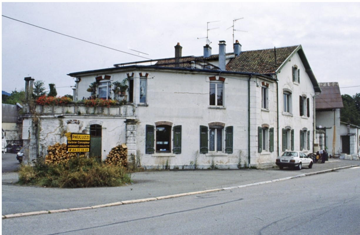
Vue d'ensemble depuis l'avenue de Schwabmünchen.
