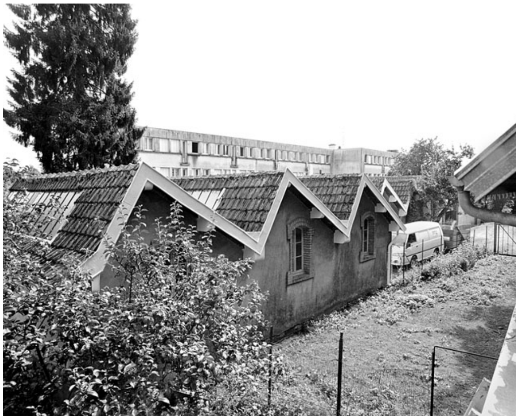
L'atelier de fabrication depuis le nord.
