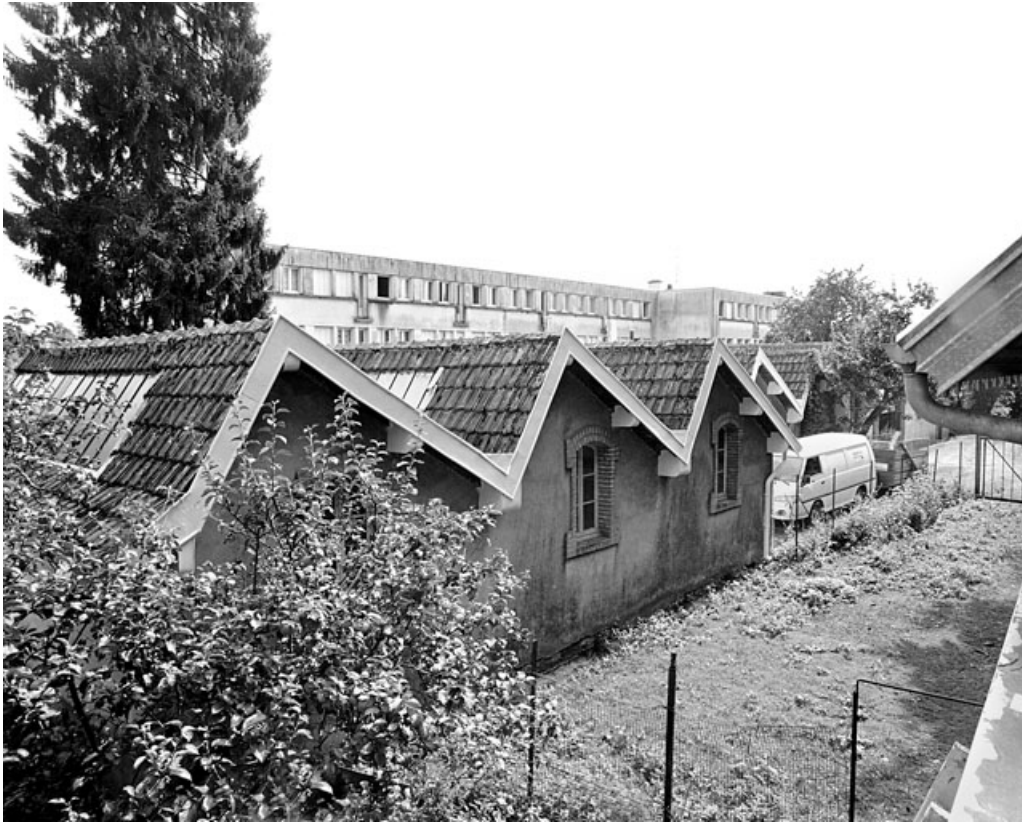
L'atelier de fabrication depuis le nord. 90, Giromagny, 23 faubourg de Belfort
