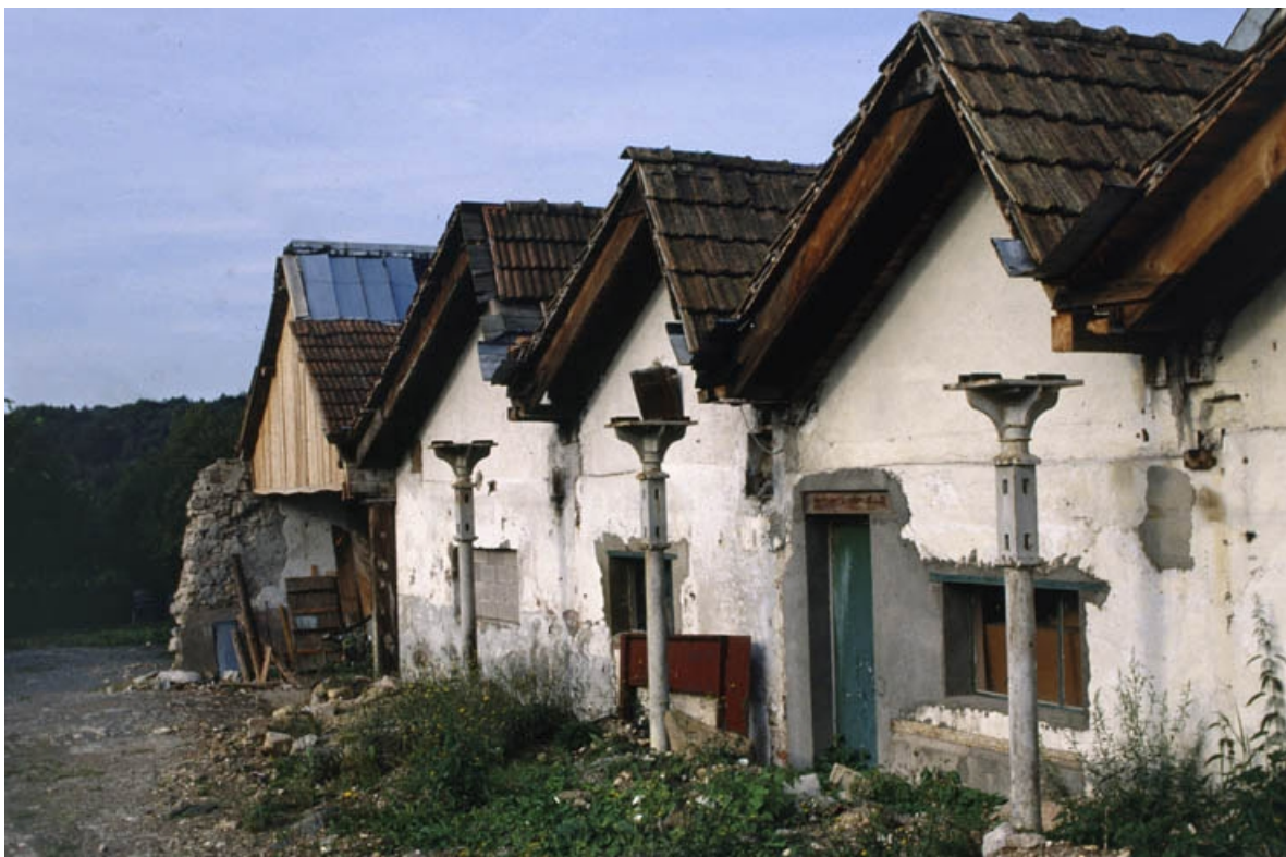
Sheds subsistants de l'atelier de fabrication.
