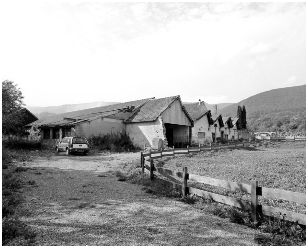
Extrémité orientale de l'atelier de fabrication depuis le sud-est.
