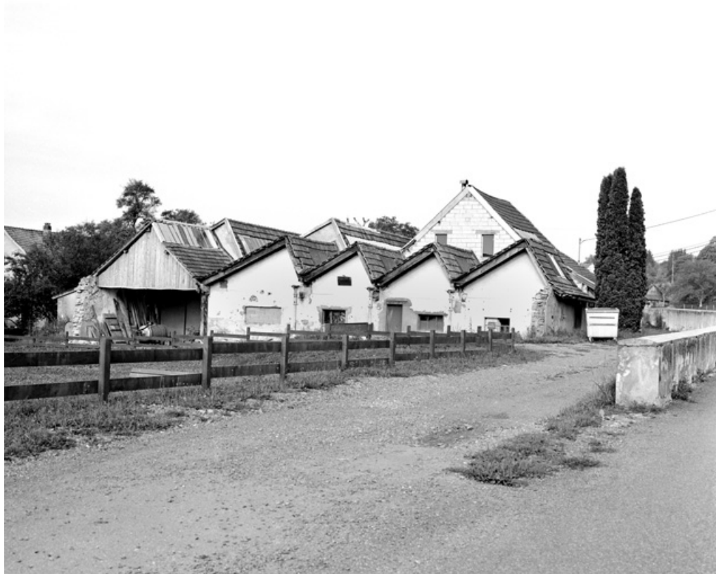
Extrémité orientale de l'atelier de fabrication.
