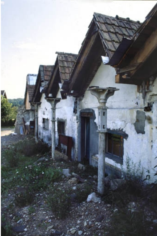
Détail du mur et des poteaux de fonte marquant la limite de destruction de l'atelier de fabrication. 90, Auxelles-Bas rue de la Paix
