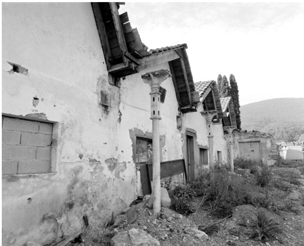
Sheds couvrant les vestiges de l'atelier de fabrication.
