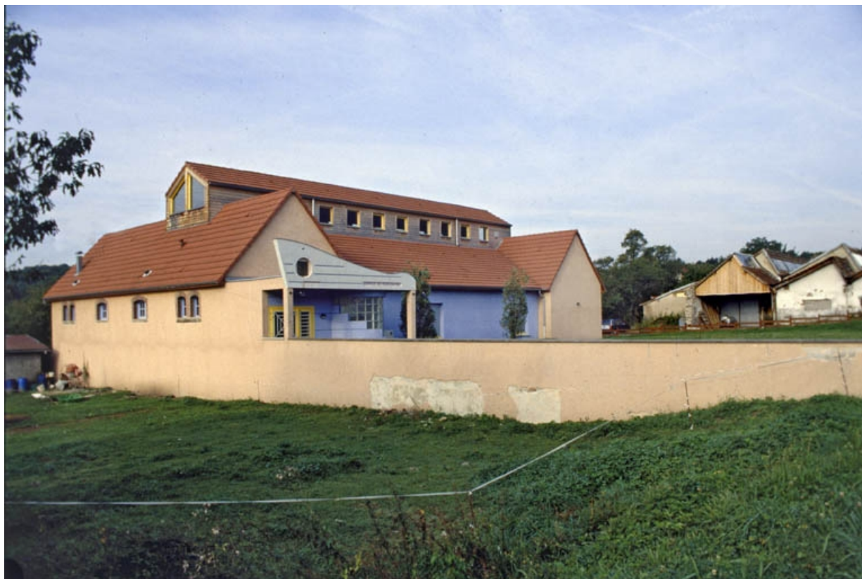
La salle des fêtes. On distingue à gauche les baies à arc segmentaire en briques d'un bâtiment du tissage, inséré dans le nouvel édifice.
