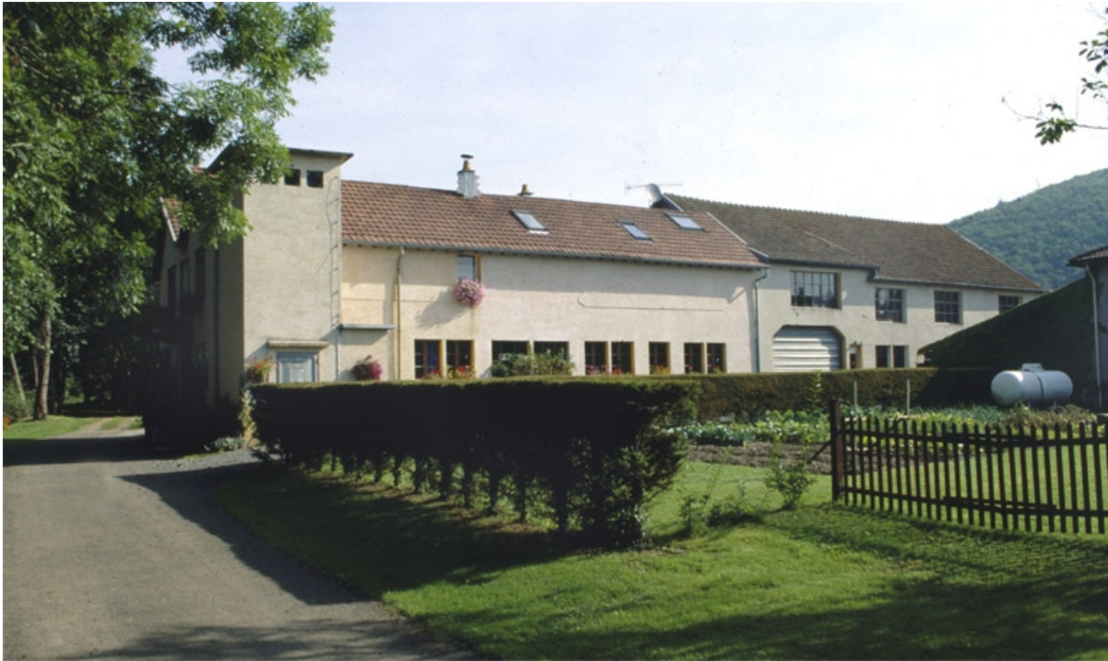
Atelier de fabrication nord depuis la rue. 90, Vescemont, 12, 14 rue de la Rosemontoise
