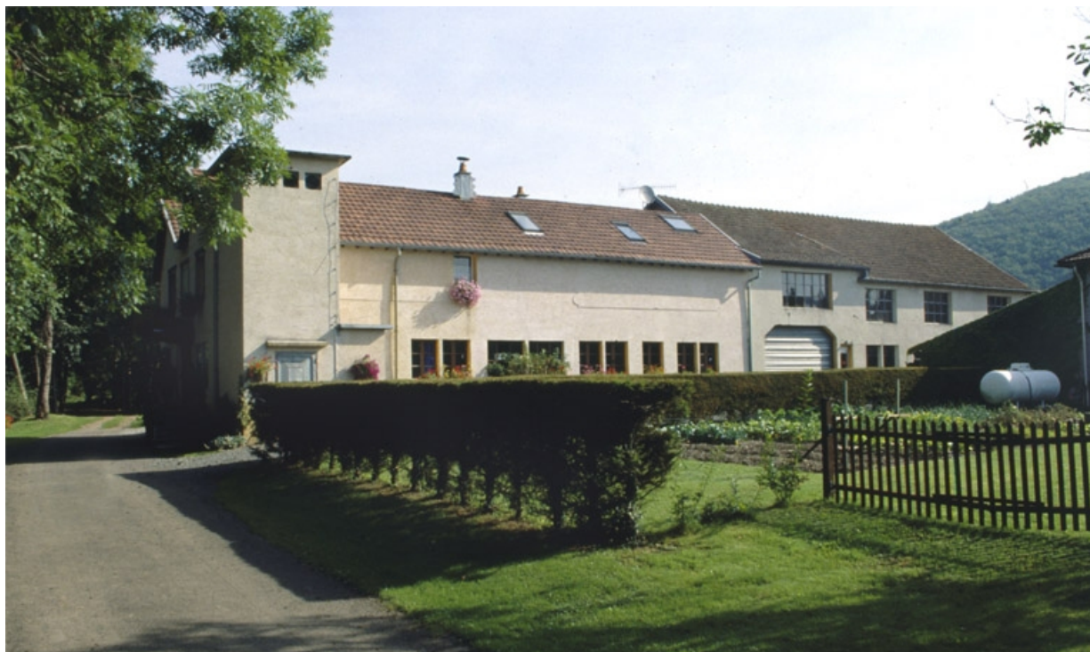
Atelier de fabrication nord depuis la rue. 90, Vescemont, 12, 14 rue de la Rosemontoise
