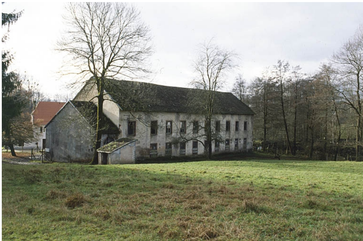
Vue de trois quarts arrière de l'atelier de fabrication.
