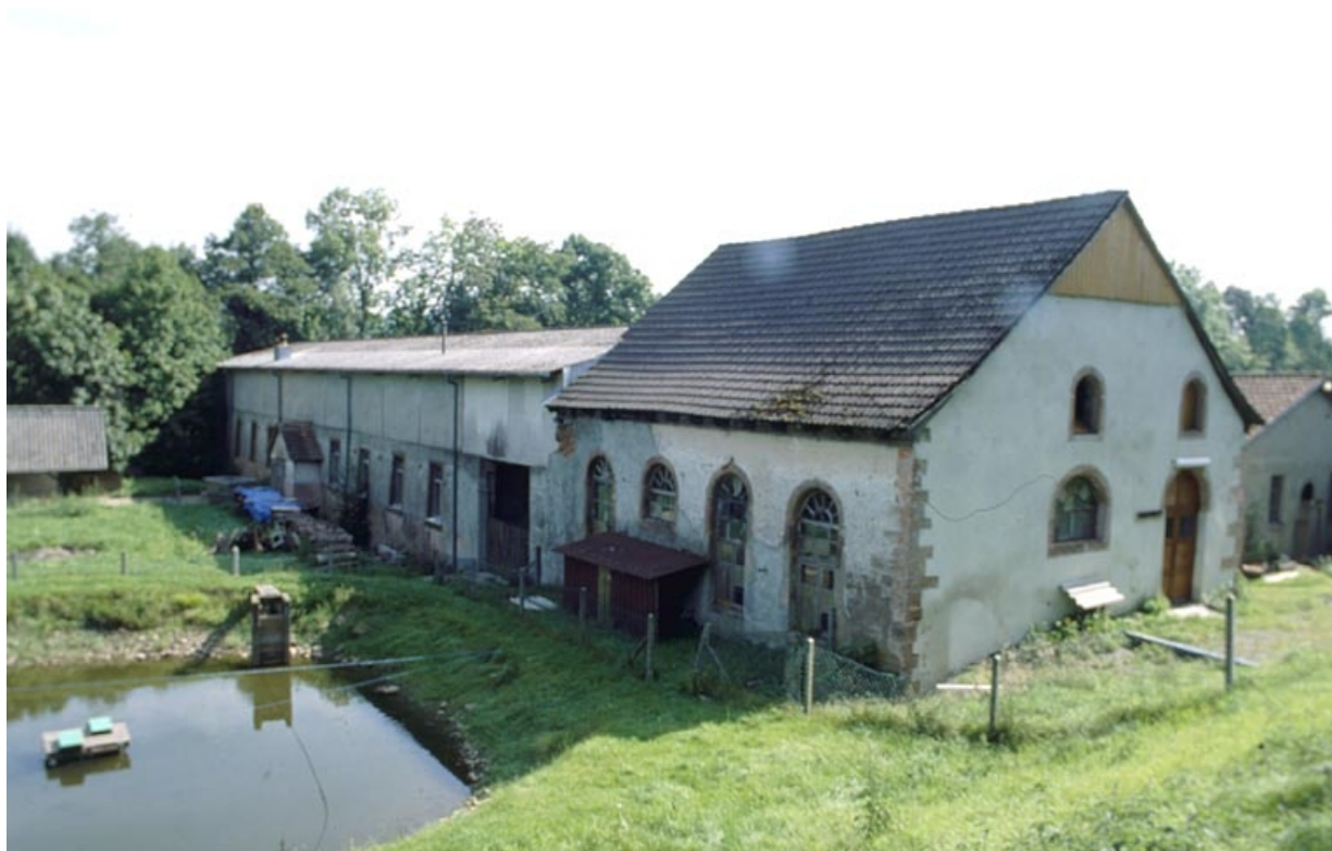
Vue de trois quarts de l'atelier de fabrication et de la salle des machines.
