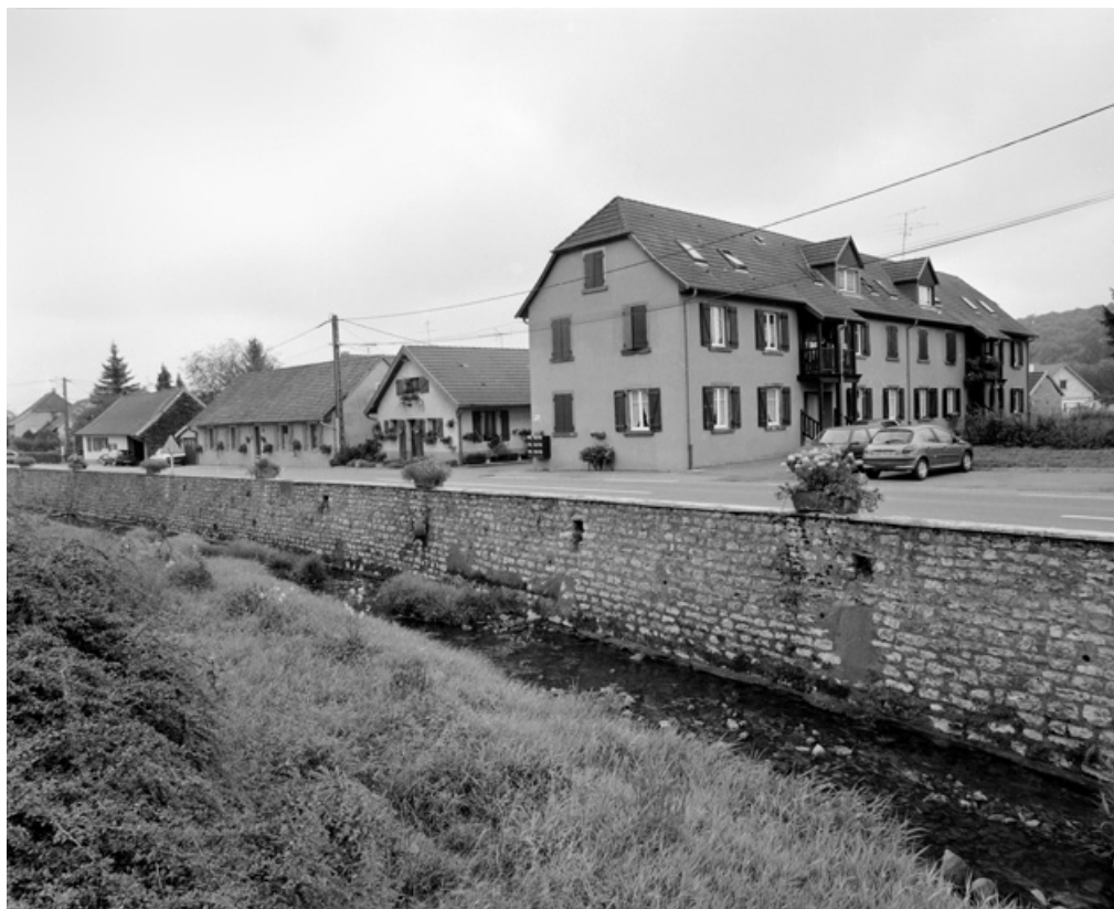
Vue d'ensemble des logements ouvriers.
