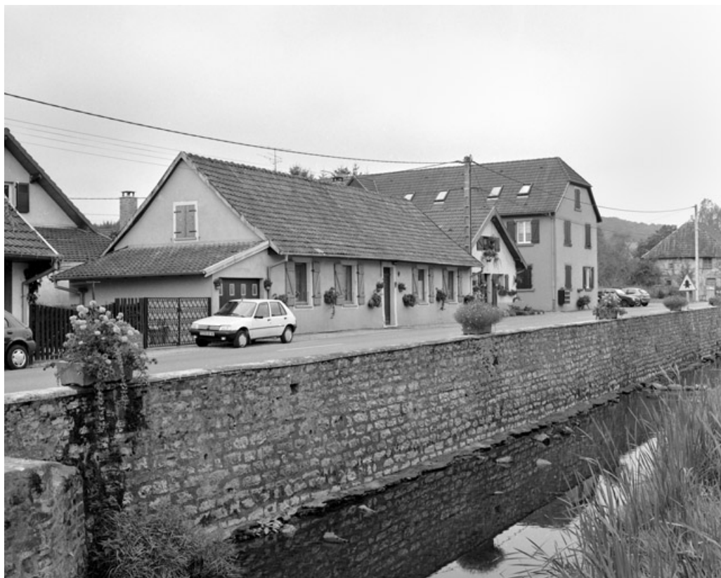
Vue de trois quarts des logements ouvriers.
