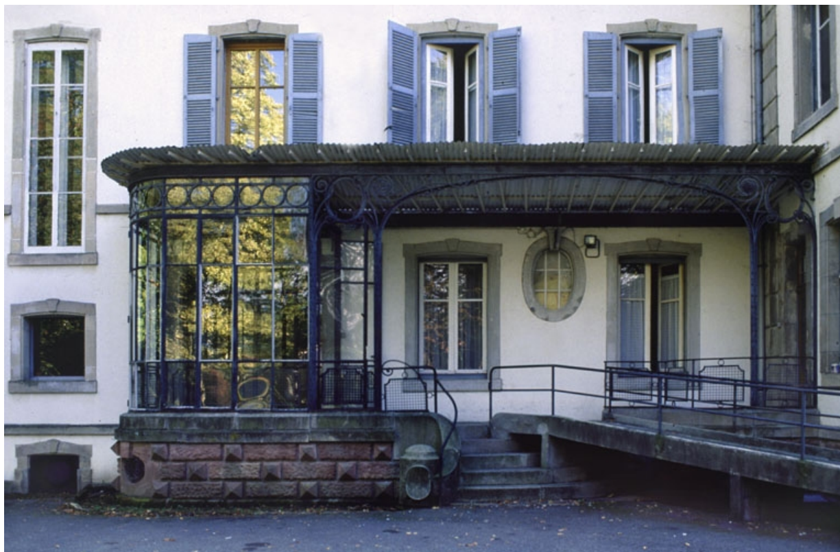
Perron et véranda du logement patronal.
