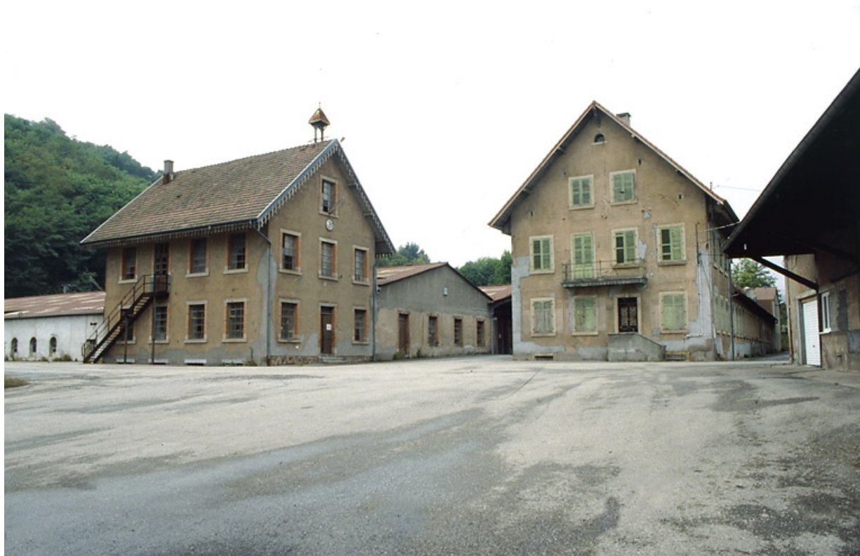
Laboratoire, bureaux et conciergerie depuis le sud.
