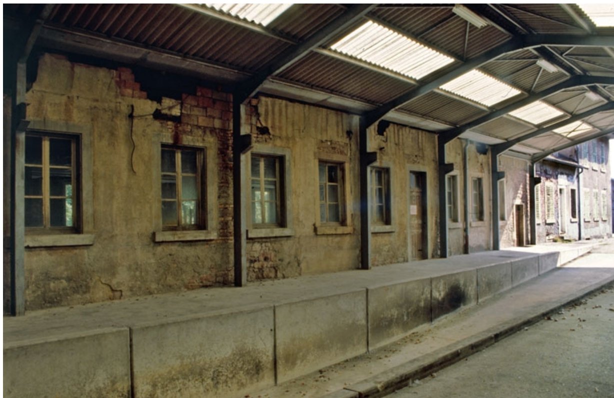
Quai couvert établi contre l'ancien tissage.
