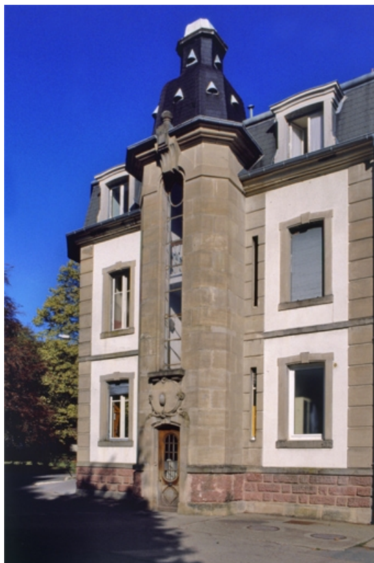
Tourelle sur la façade ouest du logement patronal. 90, Étueffont Grande Rue 28, 37
