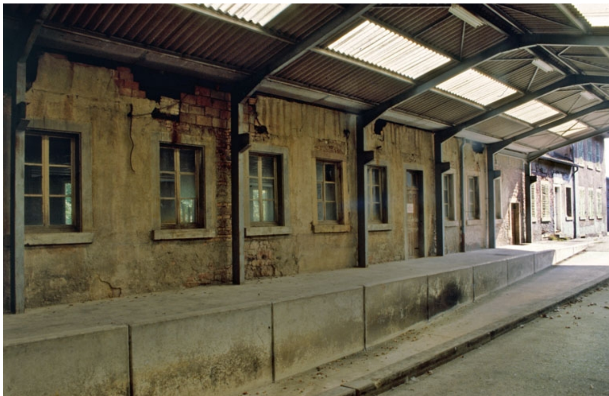
Quai couvert établi contre l'ancien tissage.
