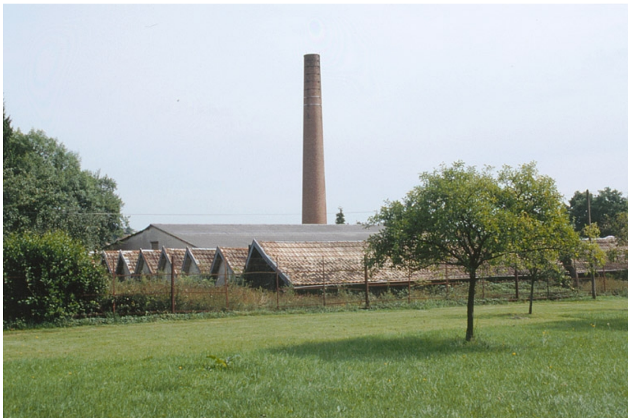
Ateliers de fabrication depuis le sud-ouest. 90, Rougemont-le-Château, 24 rue Jean Moulin
