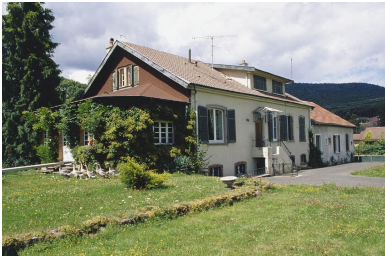
Les bureaux et le logement de contremaître depuis le sud-est.
