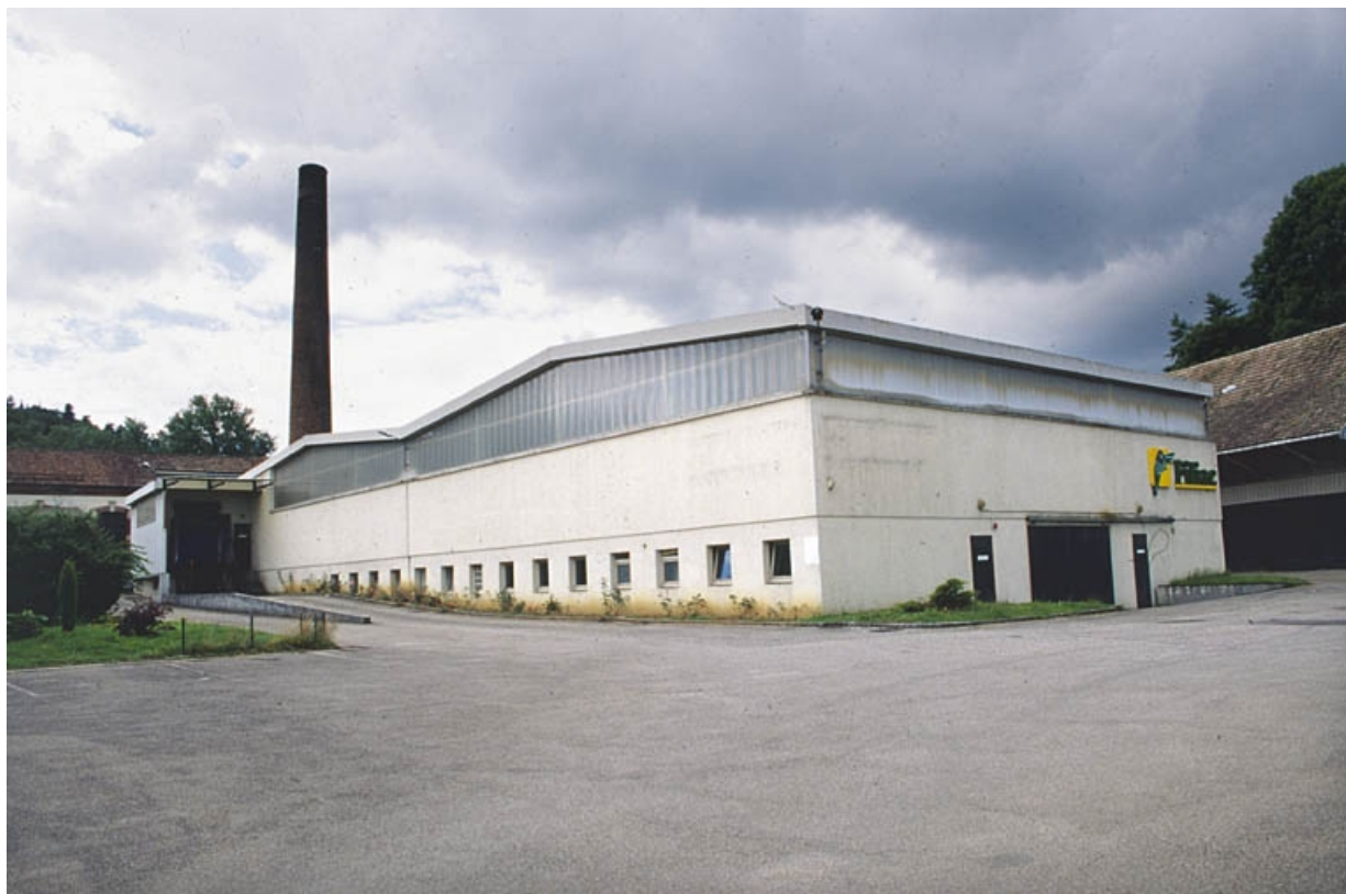
Bâtiment abritant un magasin industriel, les vestiaires et le local du comité d'entreprise.
