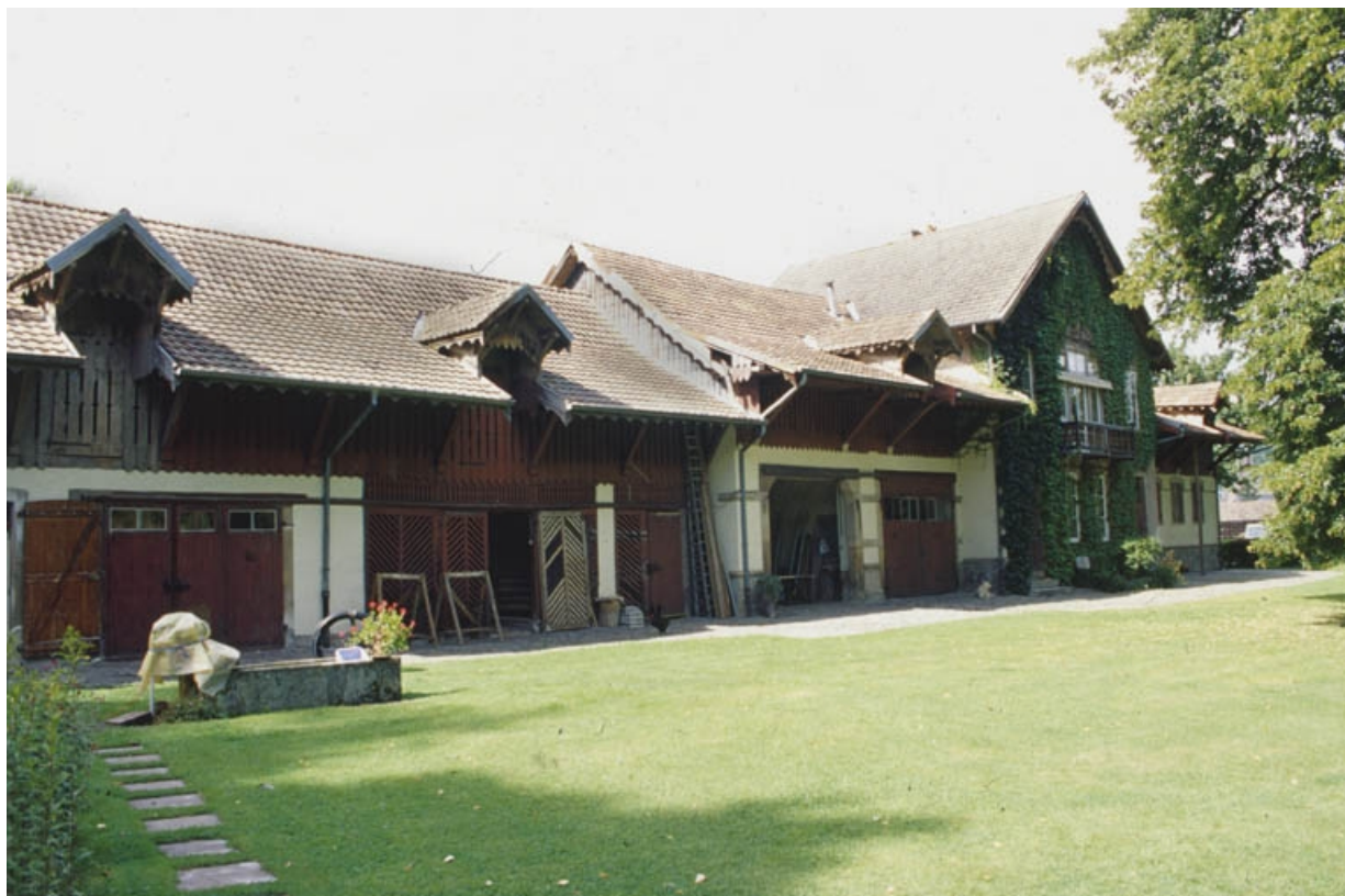
Façade antérieure de la ferme depuis le sud-est.
