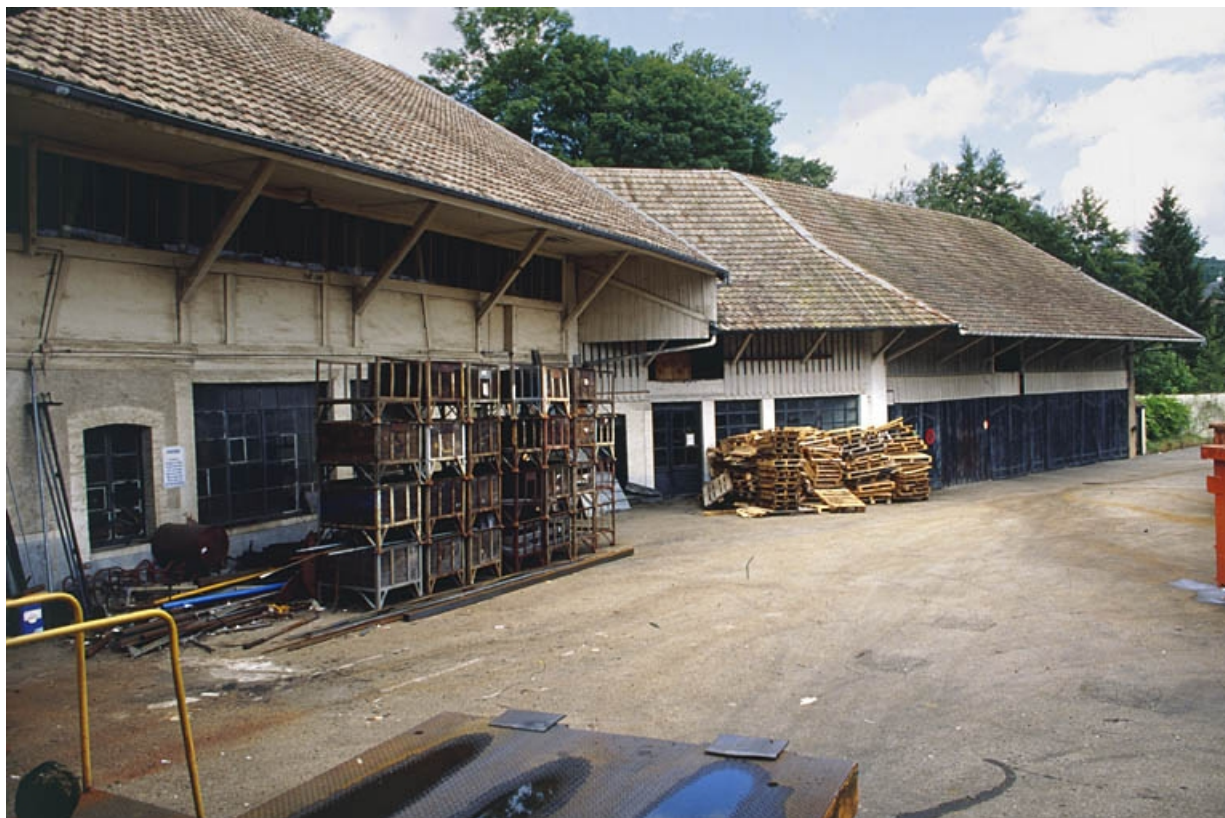
Atelier de réparation, menuiserie et remises. 90, Rougemont-le-Château, 24 rue Jean Moulin
