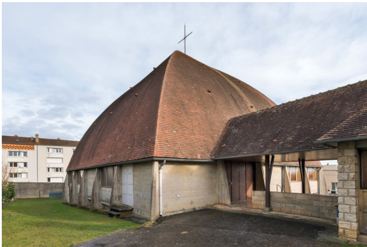
Eglise. Vue de trois quarts depuis l'est.
