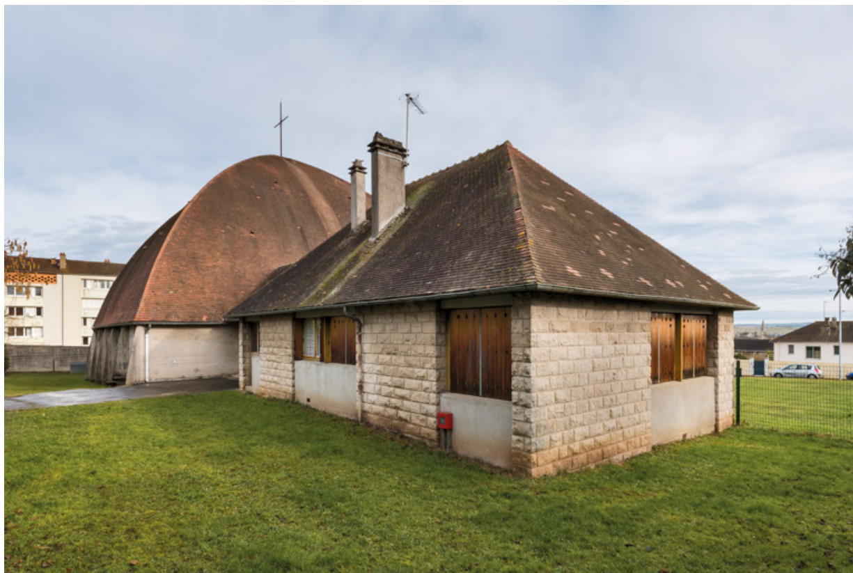
Centre paroissial. Vue de trois-quarts depuis le sud-ouest. Au premier plan, le presbytère. 89, Auxerre, 15 avenue 4ème régiment d'infanterie
