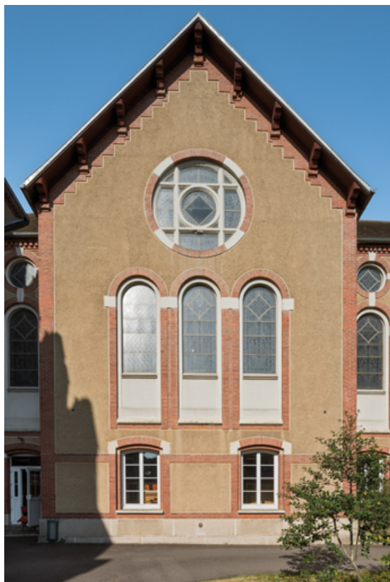
Vue extérieure de la travée centrale de la chapelle.
