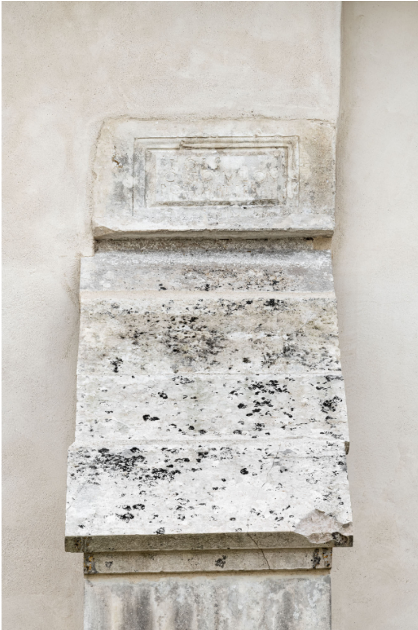
Contrefort en pierre de taille sur le mur nord de la nef surmonté d'un cartouche portant une inscription (dédicace ?). 89, Venoy rue de l' Église
