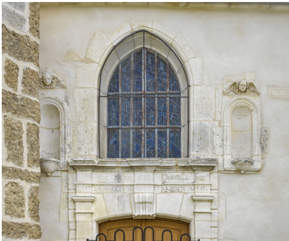
Élévation nord : détail du portail et de la baie éclairant le transept. 89, Venoy rue de l' Église
