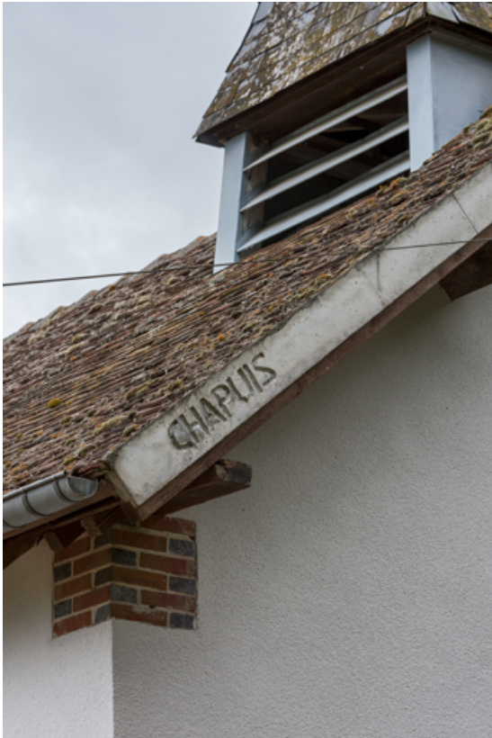
Rampant et rive de la toiture (détail).
