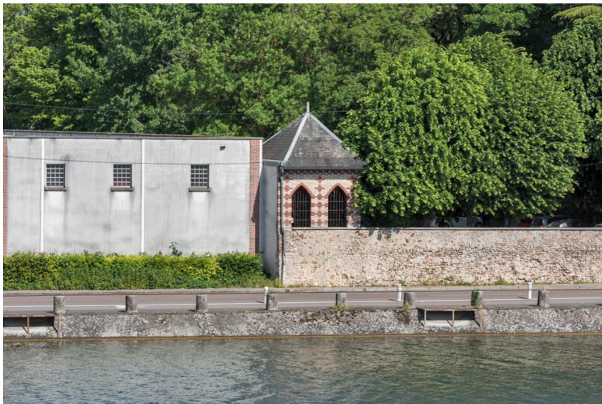
Détail de l'ancien domaine de Saint-Sauveur : à gauche l'atelier de fabrication de palettes, à droite le kiosque installé le long de l'Yonne.
