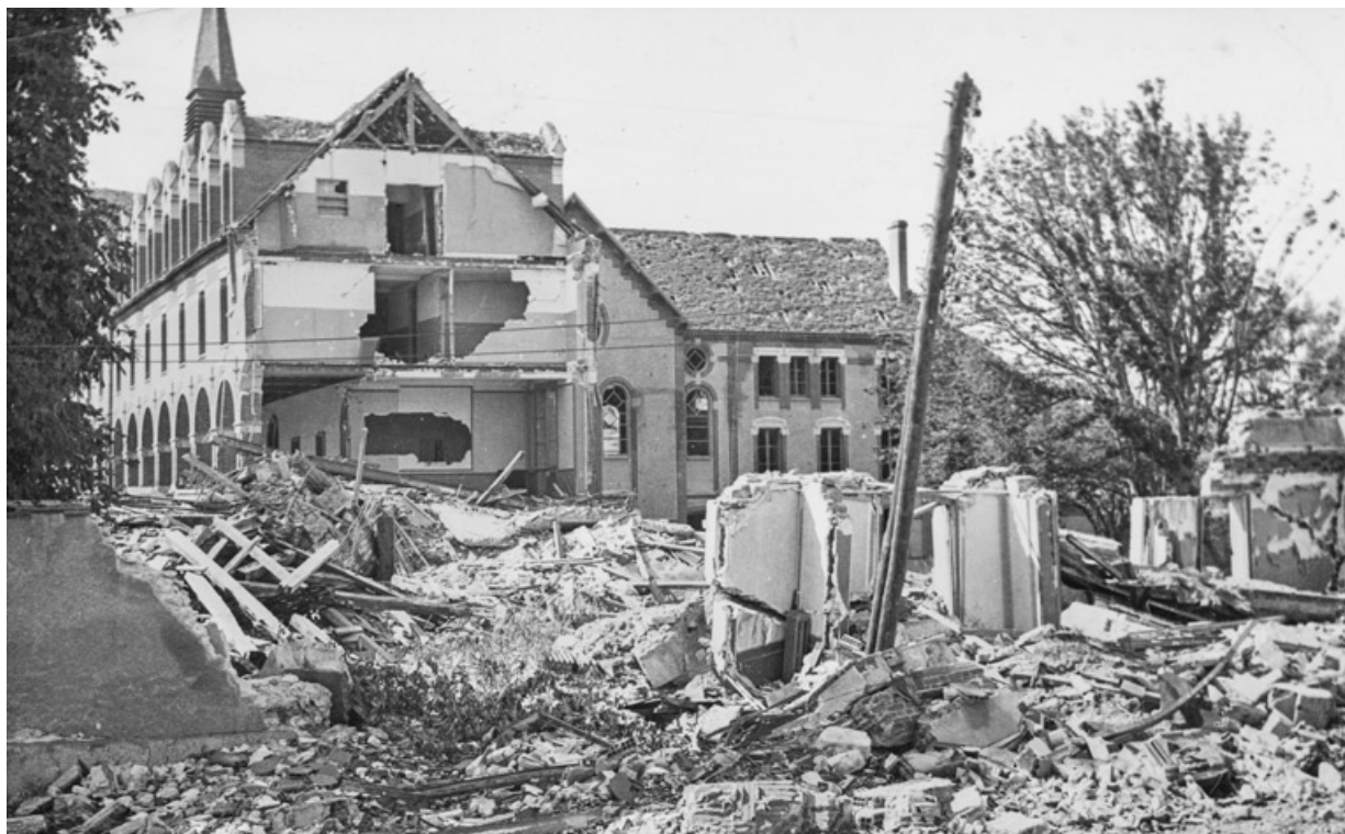
Vue de la partie est du séminaire détruite par les bombardements en 1944.
