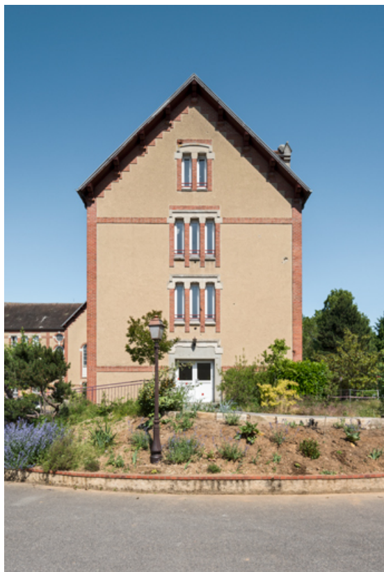
Vue du pignon ouest.
