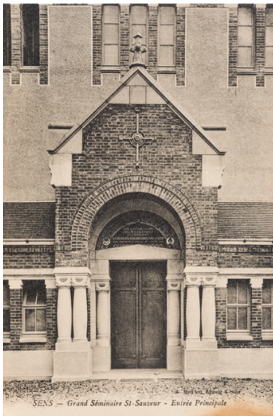
Détail de l'entrée principale, entre 1921 et 1934. 89, Sens, 67 rue Carnot
