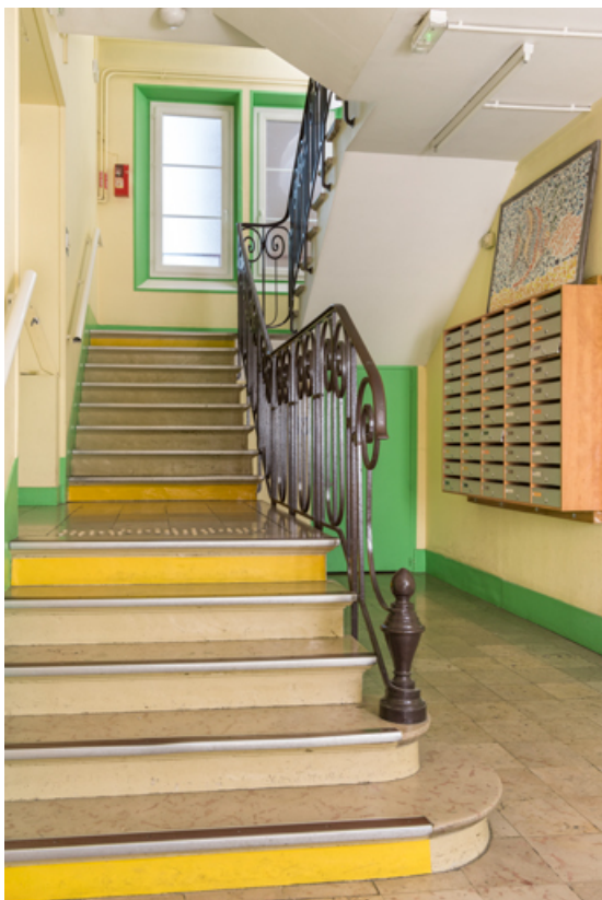
Vue d'un escalier intérieur.
