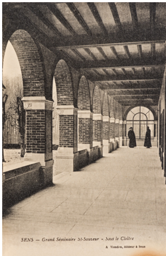
Vue du cloître, en direction de l'ouest, entre 1921 et 1934. 89, Sens, 67 rue Carnot
