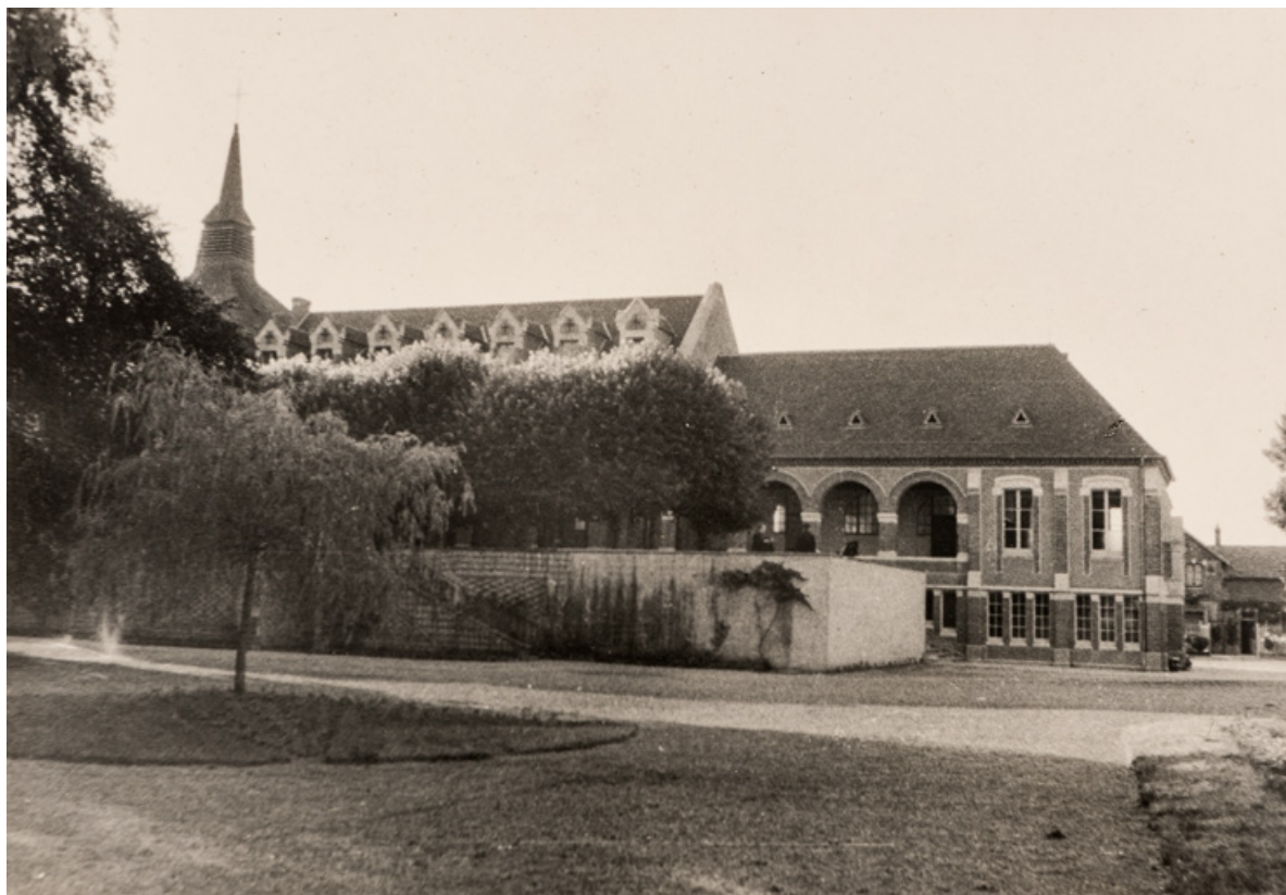
Vue de la partie est du grand séminaire après sa reconstruction.
