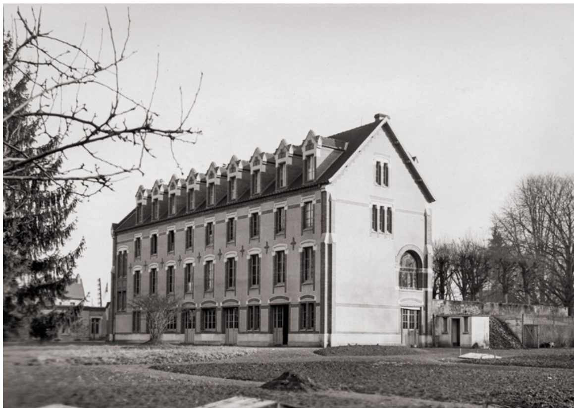
Vue du séminaire avant les travaux d'extension en 1934.
