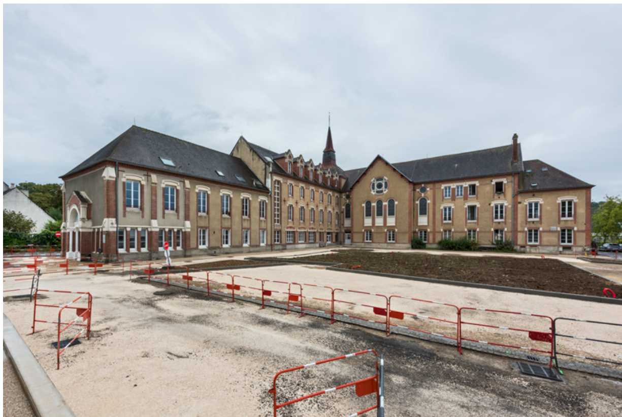
Vue d'ensemble du séminaire : façades nord et est. 89, Sens, 67 rue Carnot
