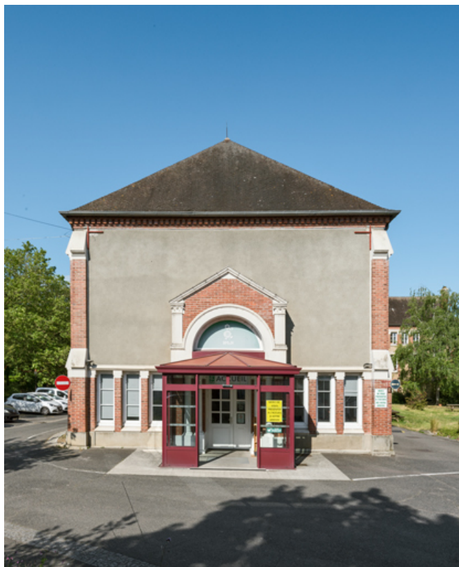
Vue du pignon est accueillant l'entrée principale.
