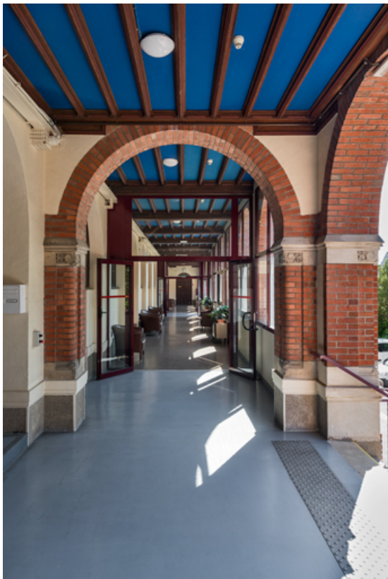
Vue de la galerie ouverte en direction de l'est.
