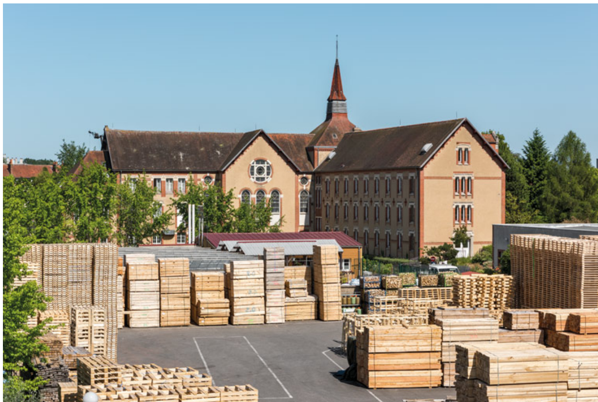
Vue d'ensemble du séminaire devenu ESAT et de l'espace de fabrication et de stockage des palettes. 89, Sens, 67 rue Carnot
