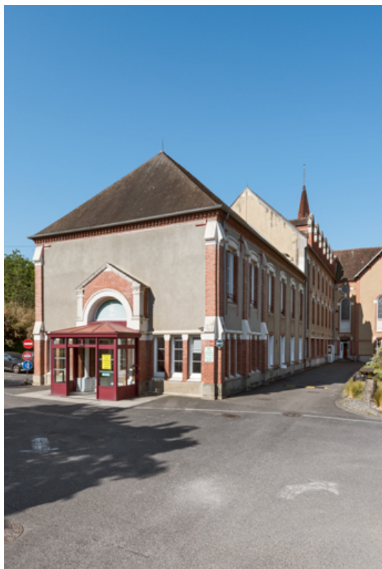
Vue des façades nord et est.
