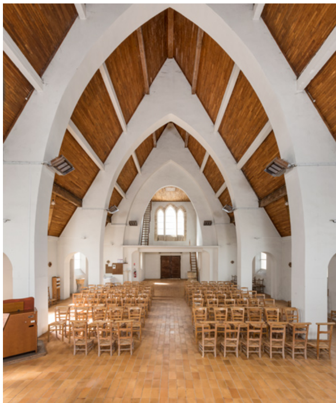
Vue de la nef en direction de l'entrée.
