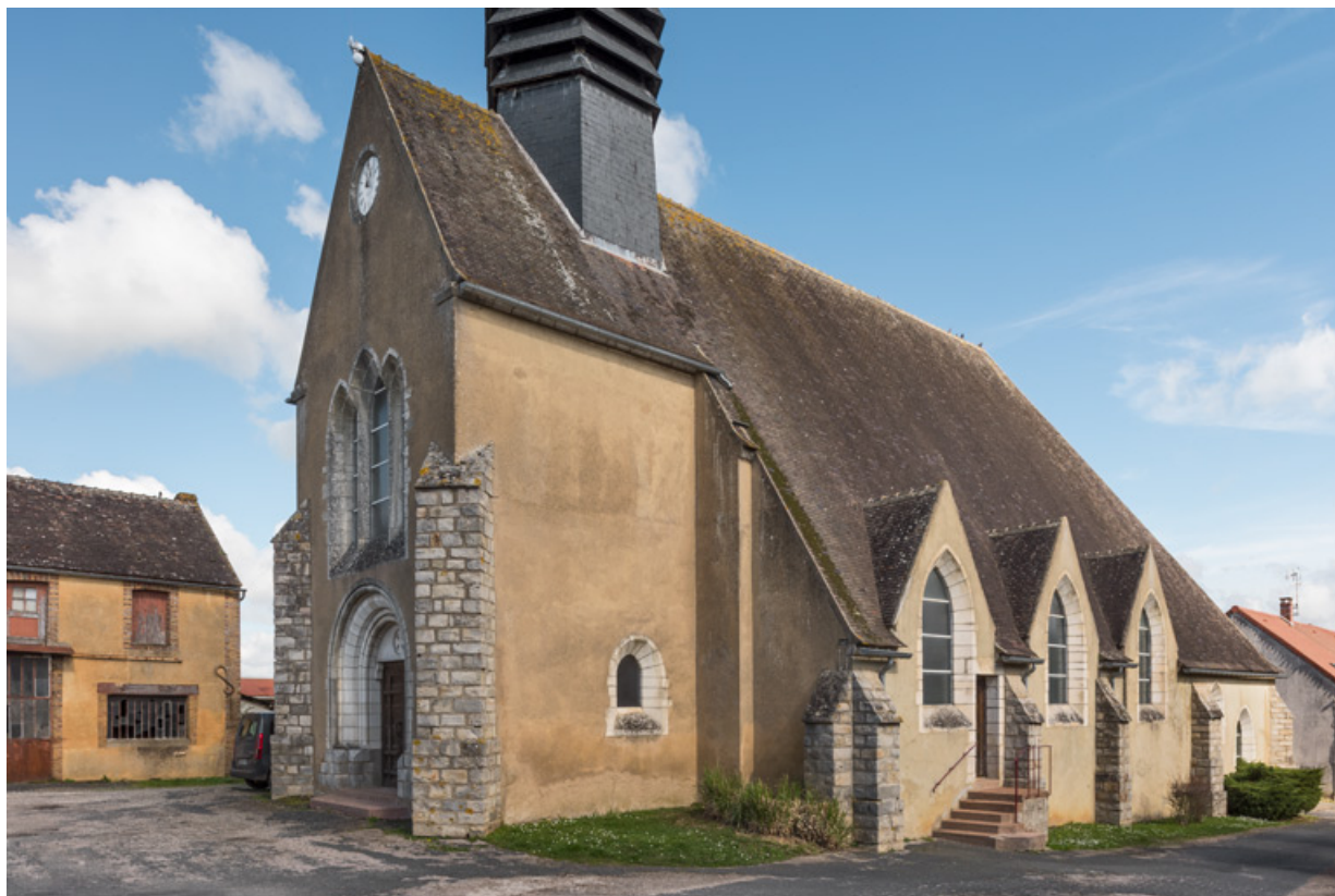
Vue des façades antérieure et droite.
