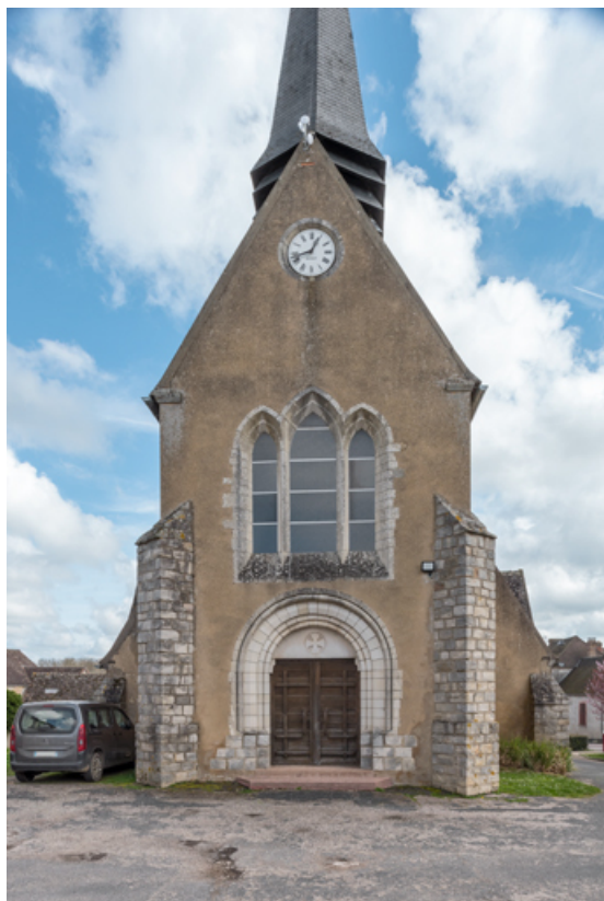
Vue de la façade antérieure : entrée principale de l'église.
