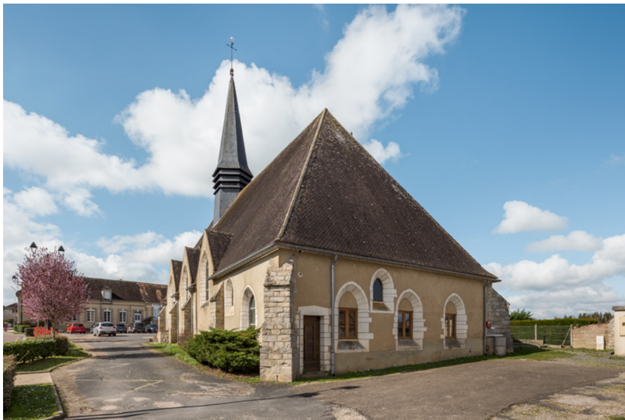
Vue de la sacristie (façade postérieure).
