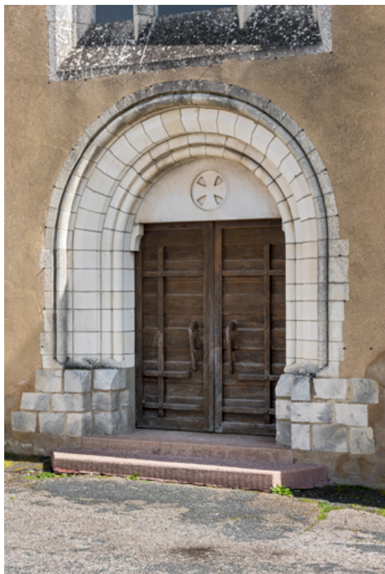
Détail de la baie de la façade antérieure (de trois quarts). 89, Montacher-Villegardin, 8 Grande Rue
