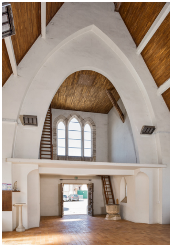
Vue de l'entrée principale et de la tribune.
