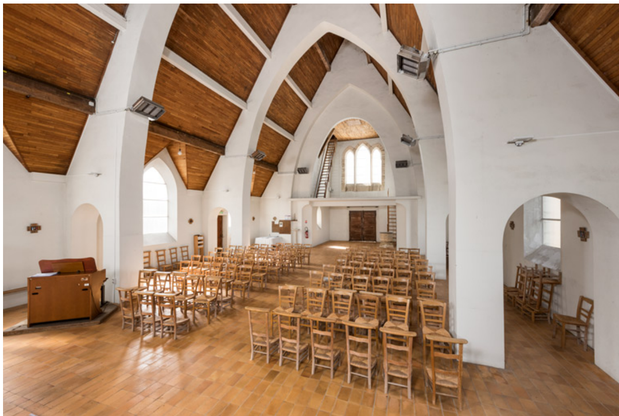
Vue de la nef et des faux bas-côtés formés par les baies en arc en plein cintre des piliers.
