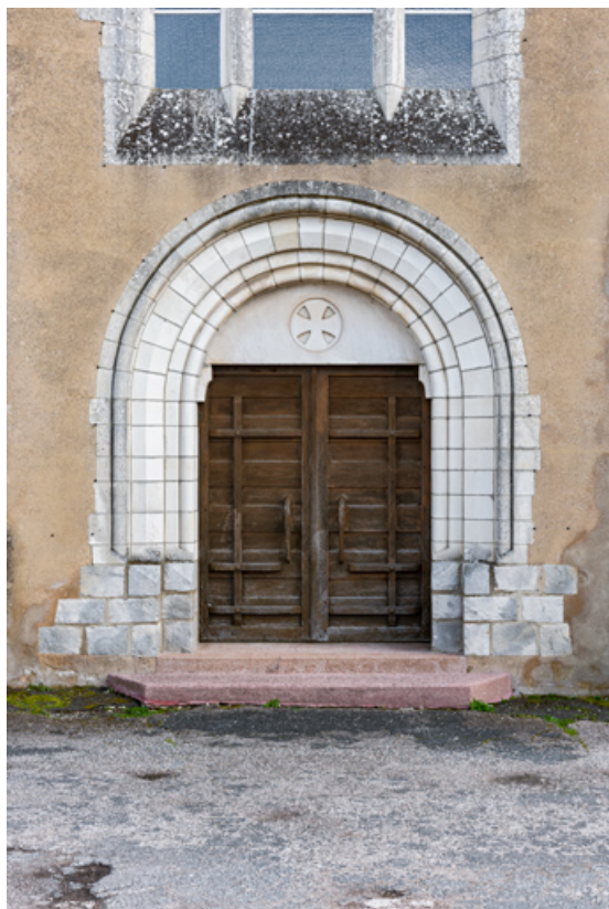
Détail de la baie à arc en plein cintre de la façade antérieure et sa porte en bois. 89, Montacher-Villegardin, 8 Grande Rue
