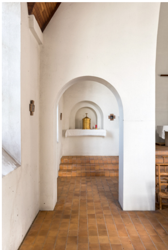
Vue du faux bas-côté gauche.
