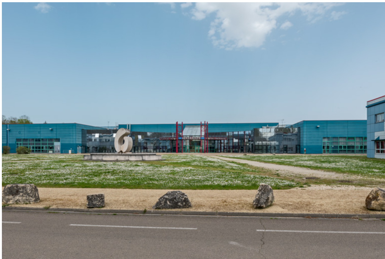
Palais des congrès Auxerrexpo. La grande salle se trouve au centre, encadrée par les deux petites salles, chacune dans une aile. 89, Auxerre
