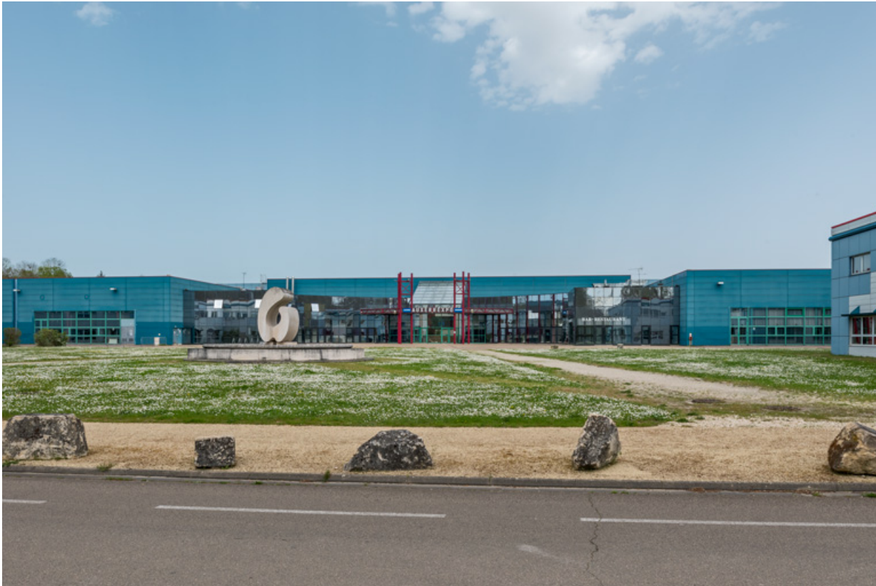
Palais des congrès Auxerrexpo. La grande salle se trouve au centre, encadrée par les deux petites salles, chacune dans une aile. 89, Auxerre
