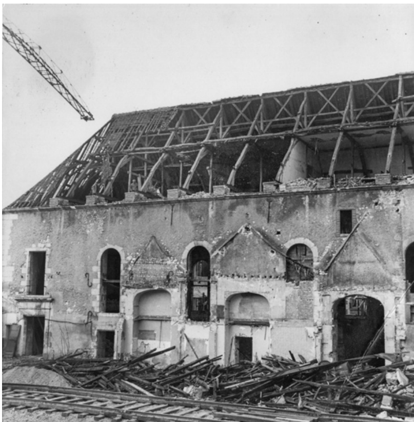
[Destruction de l'ancien théâtre : vue extérieure]. S.d. [1er trimestre 1960 ?]. 89, Auxerre
