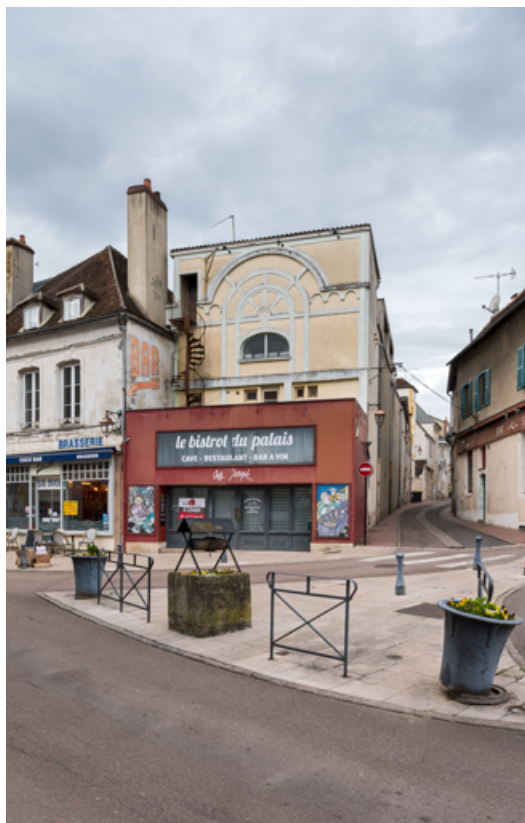
Cinéma désaffecté Botex, puis Select puis Paris (65 rue de Paris). 89, Auxerre
