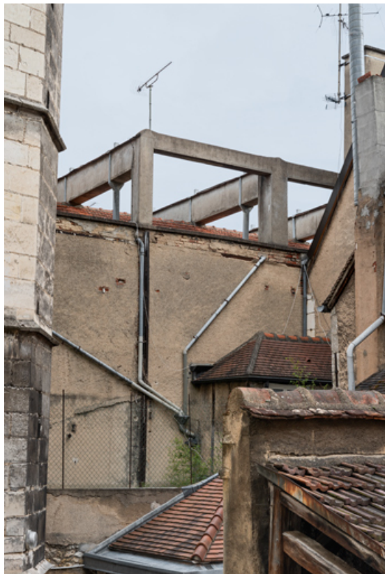
Façade latérale gauche et portiques en béton.
