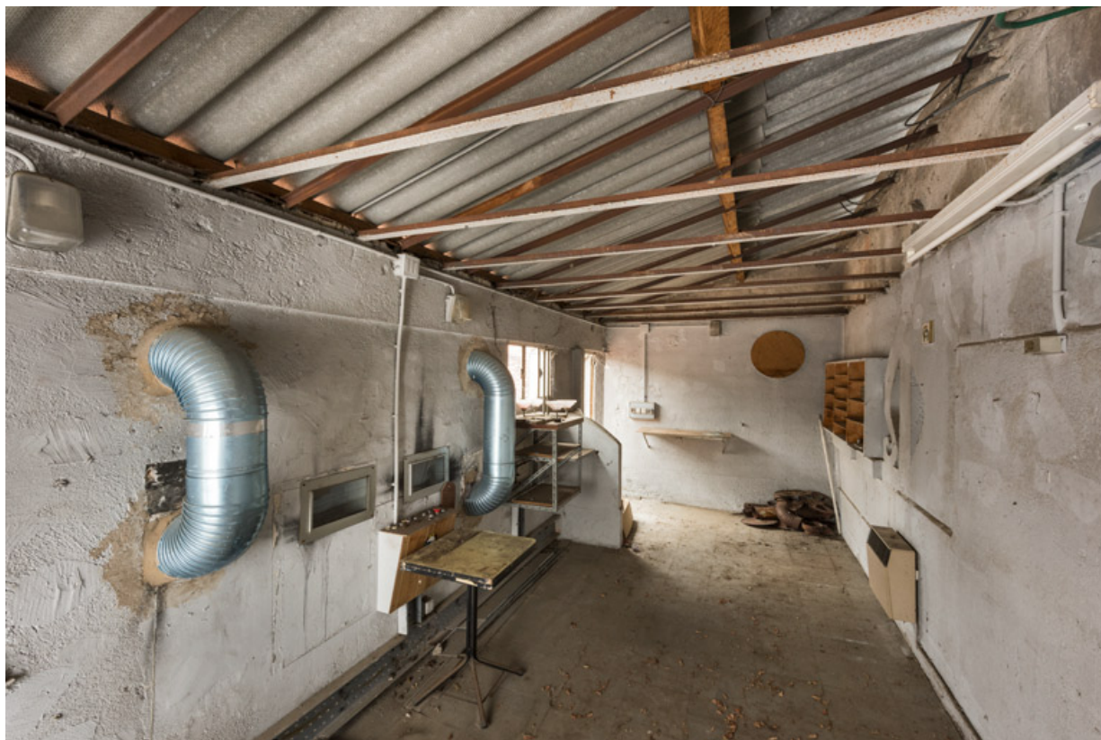
Cabine de projection. La façade antérieure est à droite.
