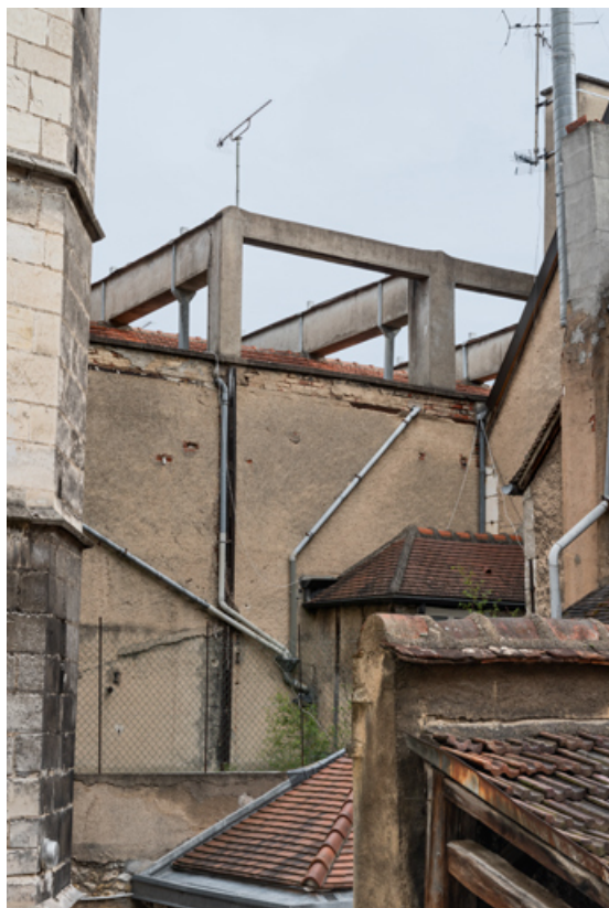
Façade latérale gauche et portiques en béton.
