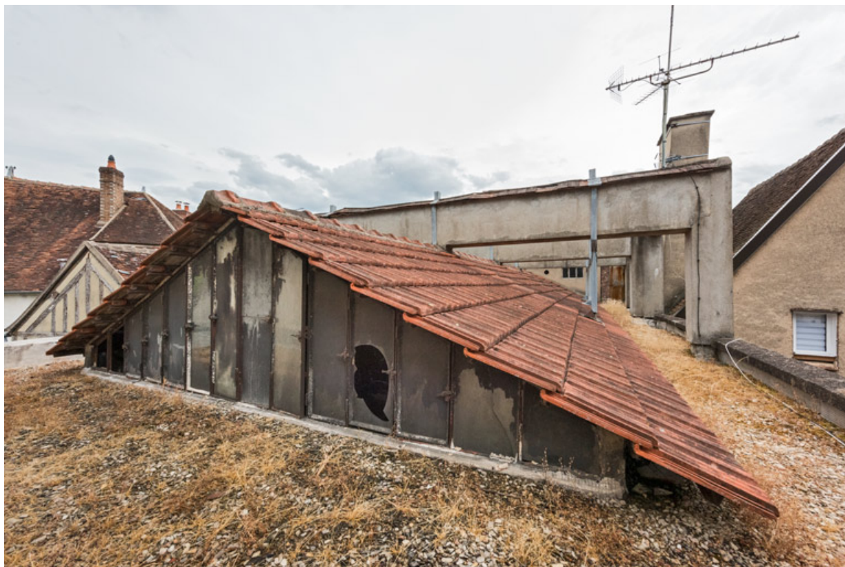
Terrasse sur la salle : lanterneau et portiques en béton.
