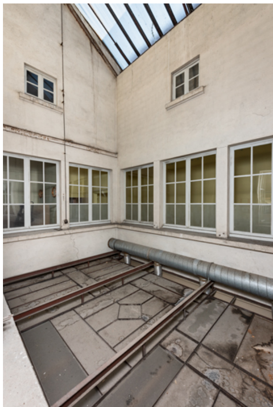
Puits de lumière au 1er étage.
