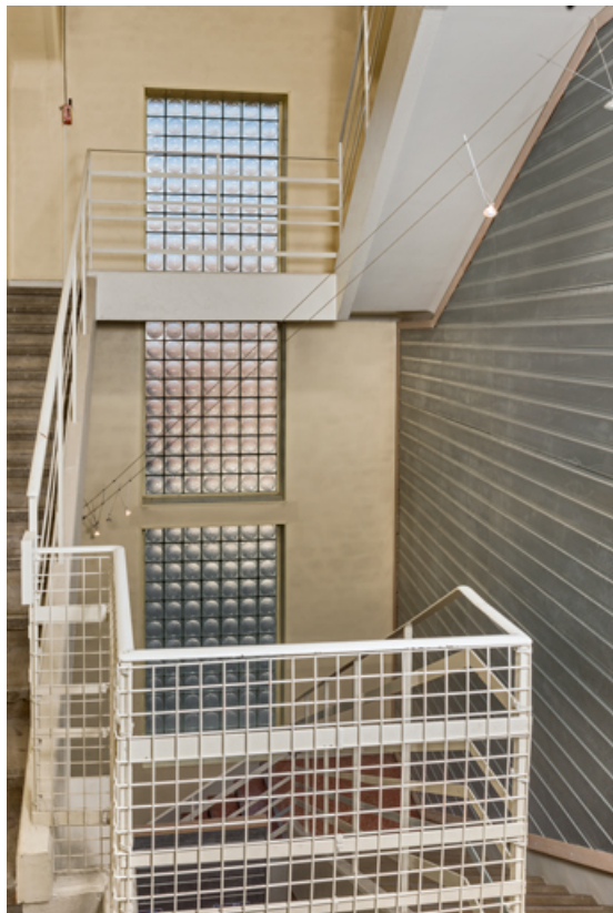
Cage d'escalier, depuis le 1er étage.
