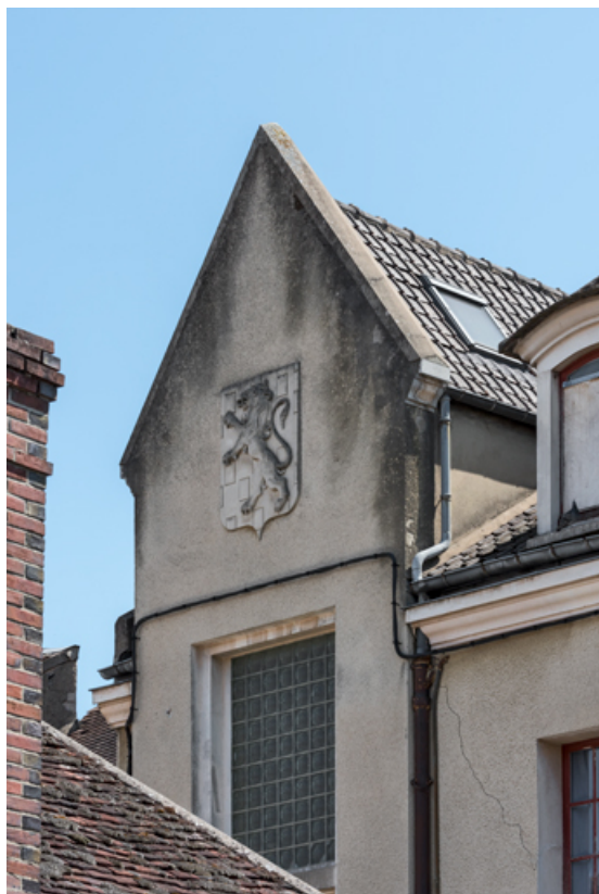
Pignon sculpté de la cage d'escalier.
