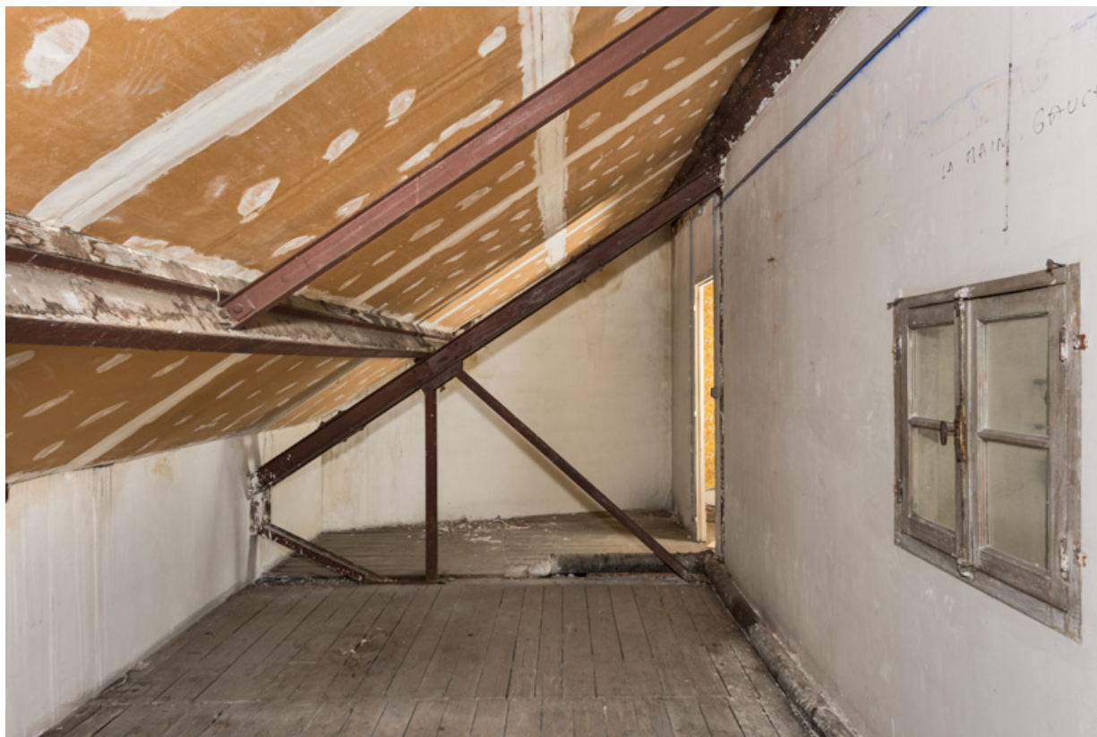
2e étage : charpente métallique.
