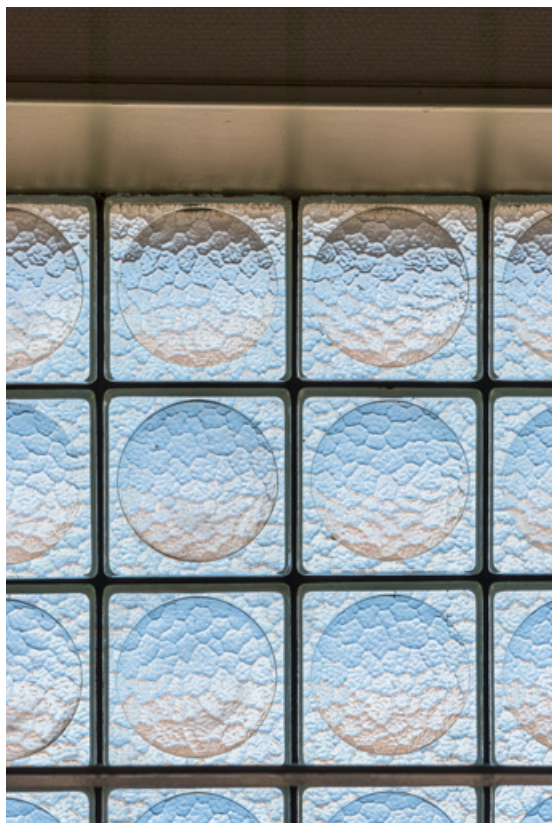
Cage d'escalier : détail des pavés de verre.
