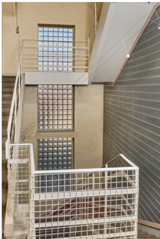
Cage d'escalier, depuis le 1er étage.
