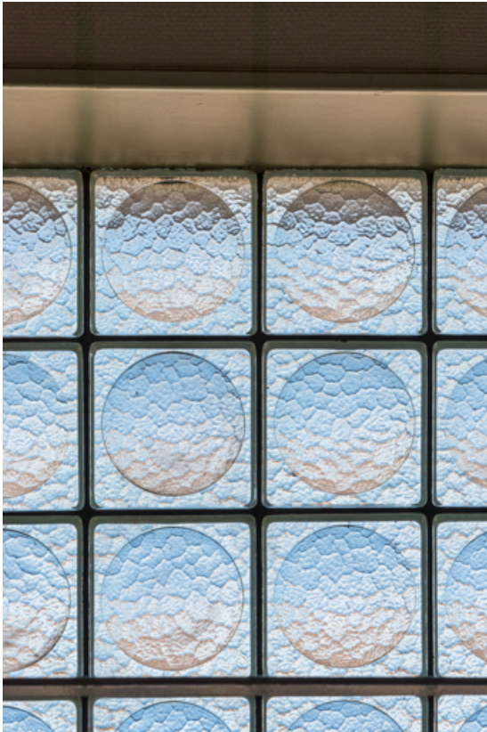
Cage d'escalier : détail des pavés de verre.
