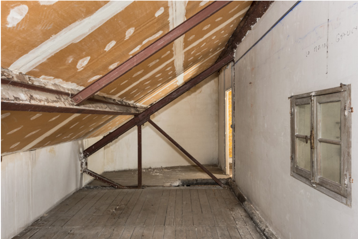
2e étage : charpente métallique.
