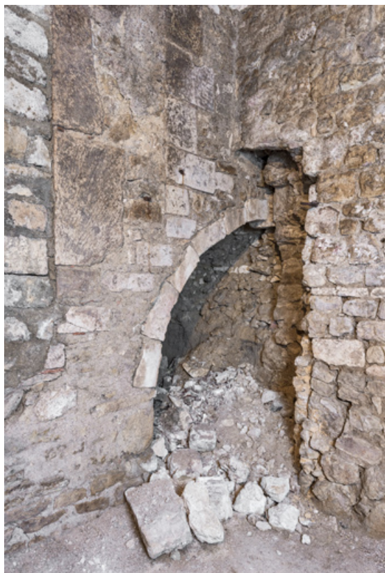
Caves sud, 1re pièce : traces d'escalier dans le mur (12e siècle ?). 89, Auxerre rue Joubert
