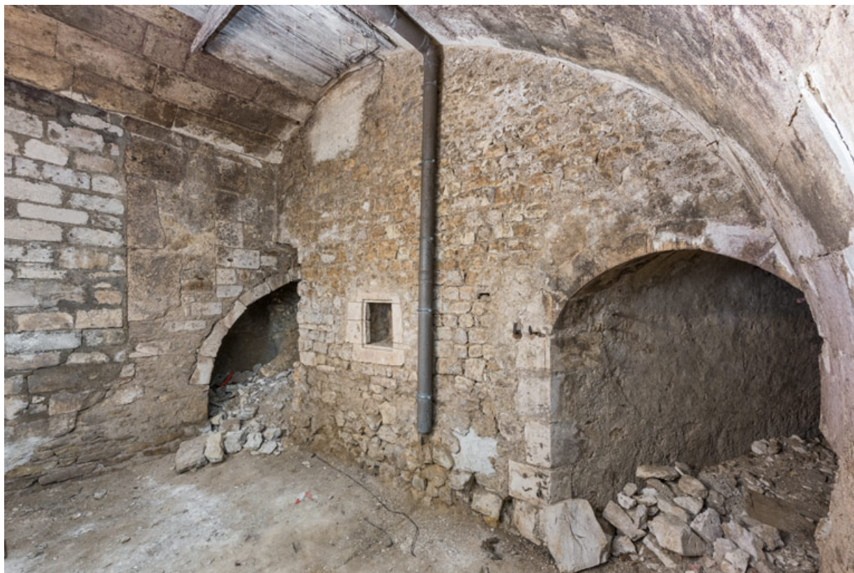
Caves sud : 1re pièce, depuis l'escalier au sud. 89, Auxerre rue Joubert
