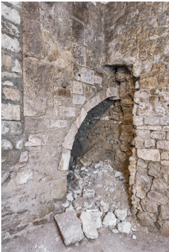
Caves sud, 1re pièce : traces d'escalier dans le mur (12e siècle ?). 89, Auxerre rue Joubert
