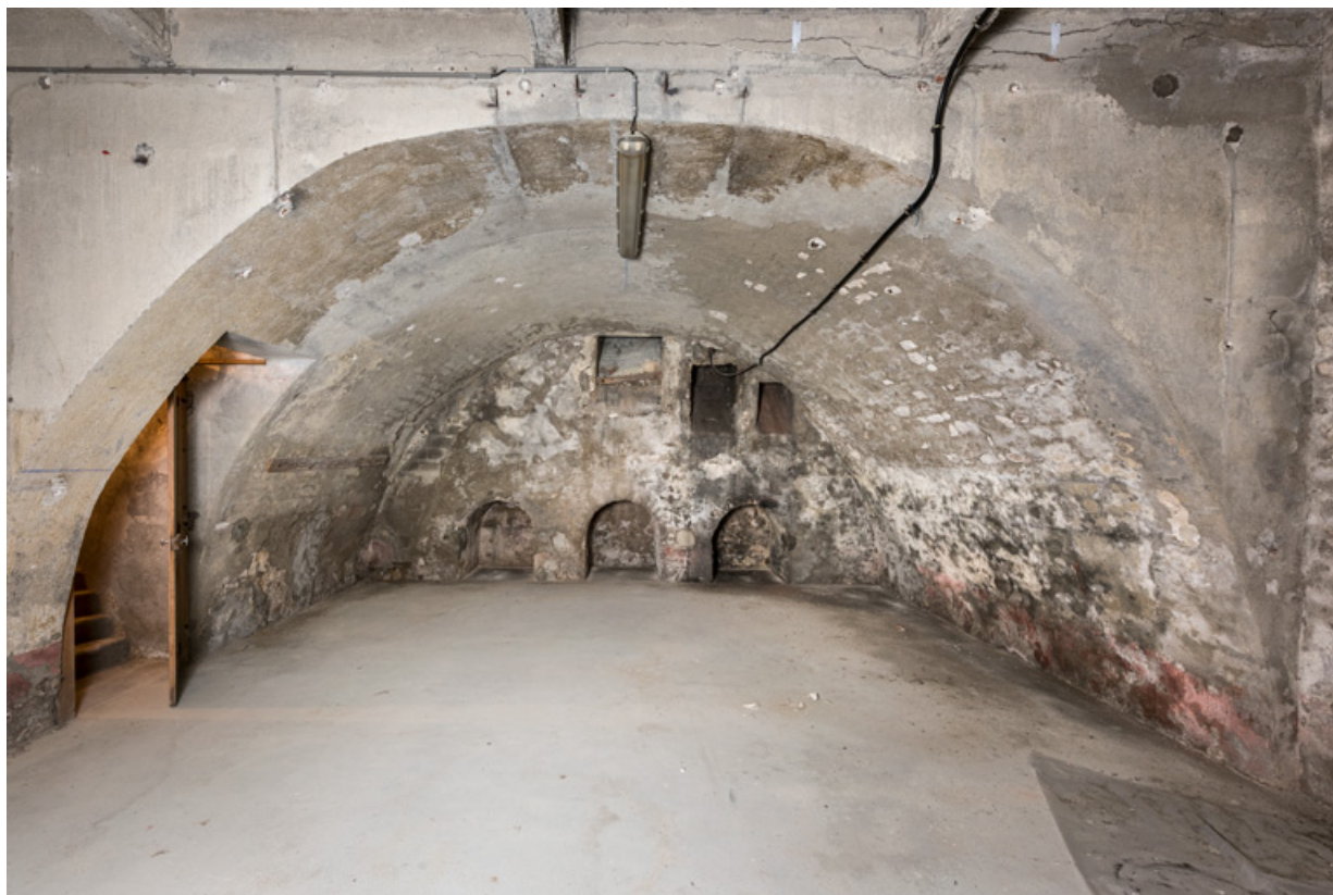
Caves nord : vue depuis l'est.
