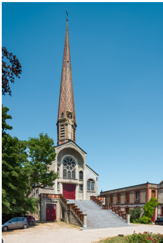
Eglise et chapelle. Vue de trois quarts.
