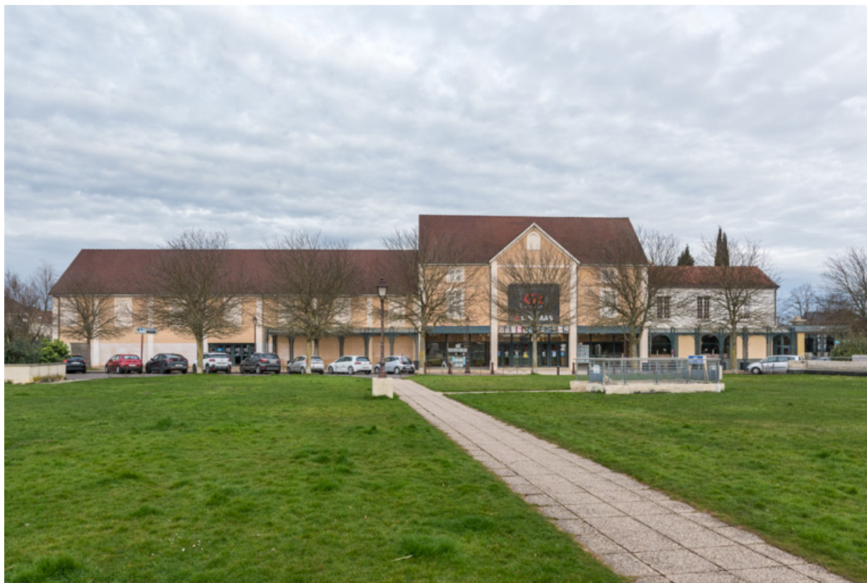
Façade sur la rue Larabit et la place de l'Arquebuse.
