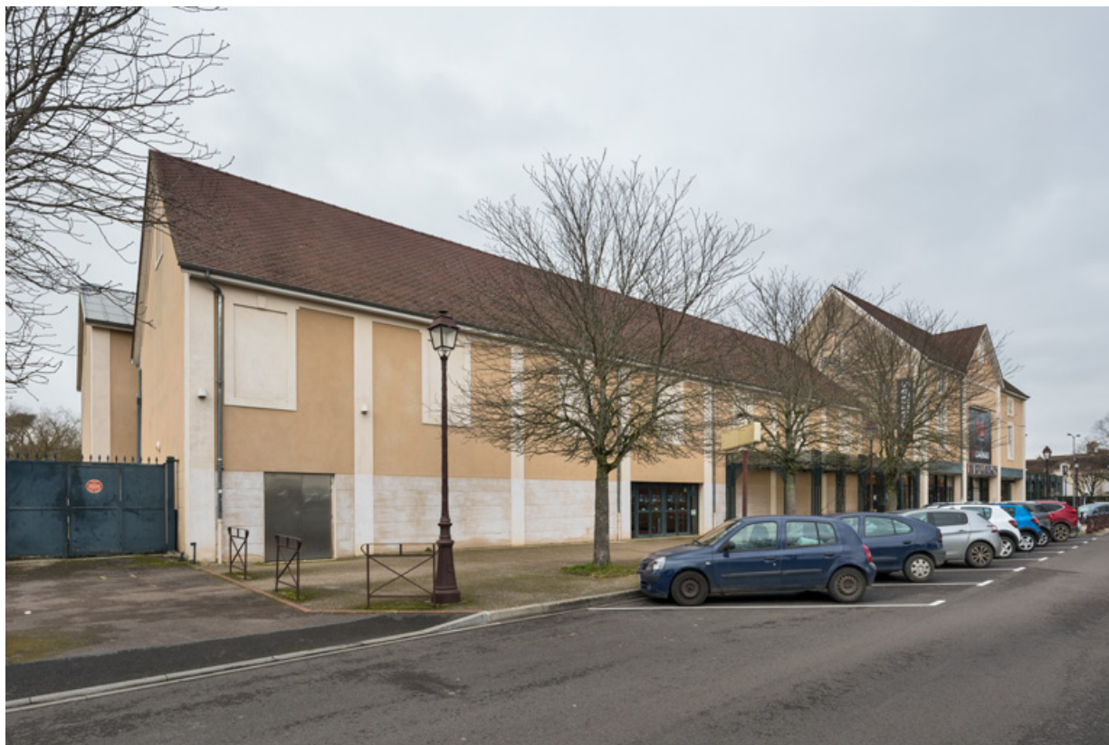
Façade sur la rue Larabit et la place de l'Arquebuse, de trois quarts gauche. 89, Auxerre, 1 boulevard du 11 Novembre
