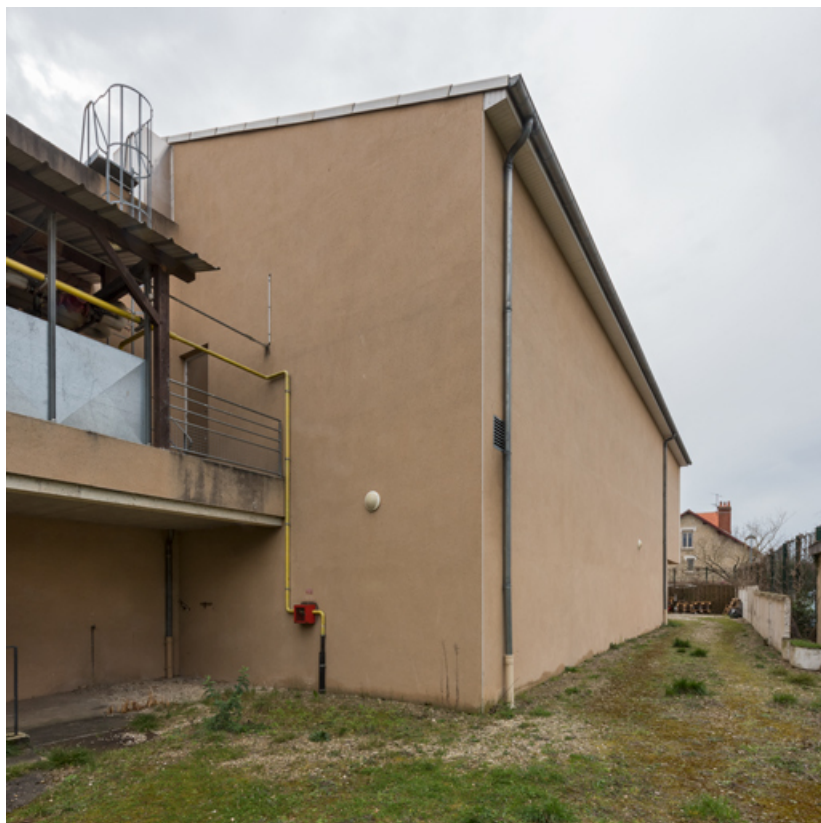
Salle 8, vue du nord.
