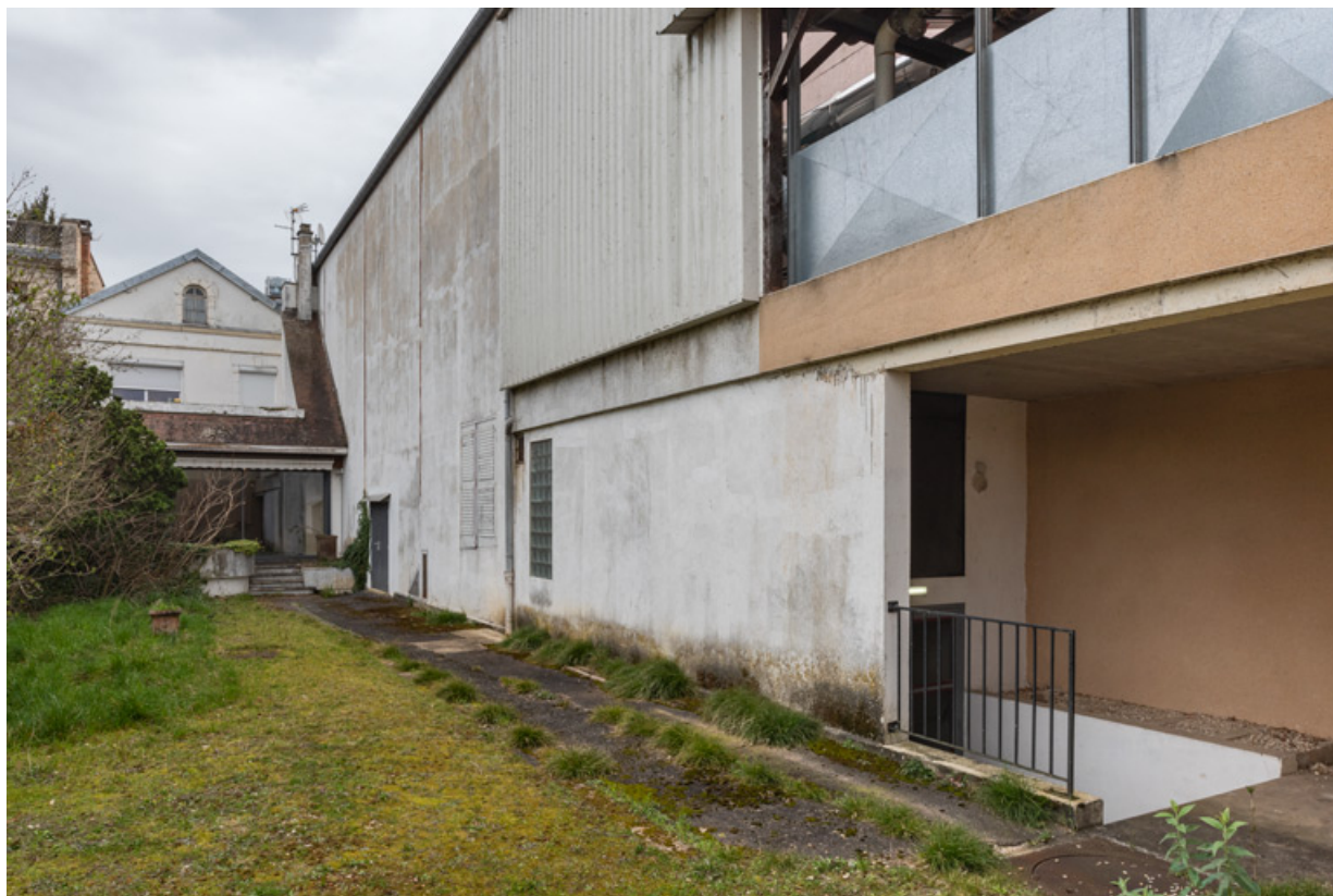
Façade postérieure du logement et salles 1-2 (ancienne salle de spectacle) et 7. 89, Auxerre, 1 boulevard du 11 Novembre
